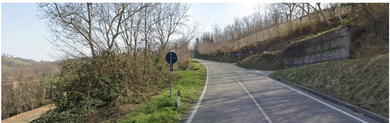
Figura 3-17 - Sopra, SP78 stato attuale stradale in direzione sud presso borgata Case Rosse di Sarnano; sotto, SP237 stato attuale stradale in direzione sud presso ansa di Montane
