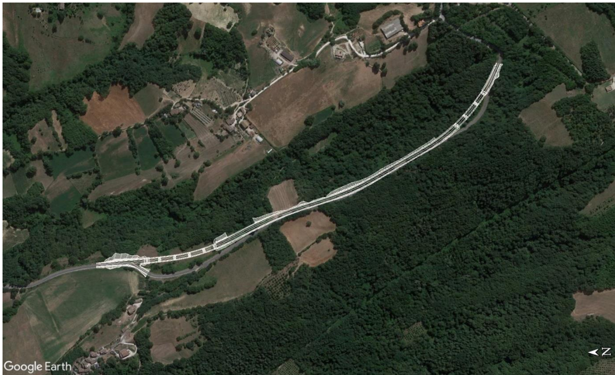
Figura 3-10 - Lotto 2 Stralcio 1 Lungo la S.S. N. 78 "Picena" - Sarnano – Amandola – secondo tratto Montane-Rustici in direzione abitato di Rustici per uno sviluppo di circa 2,20 km
