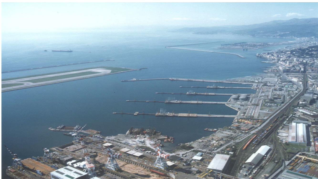
Figura 1: Vista area della nuova calata a mare e sullo sfondo il Canale di calma di Prà
