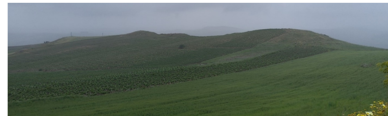
Figura 11: Panoramica dell'area interessata dalle opere per la realizzazione dell'aerogeneratore T4
