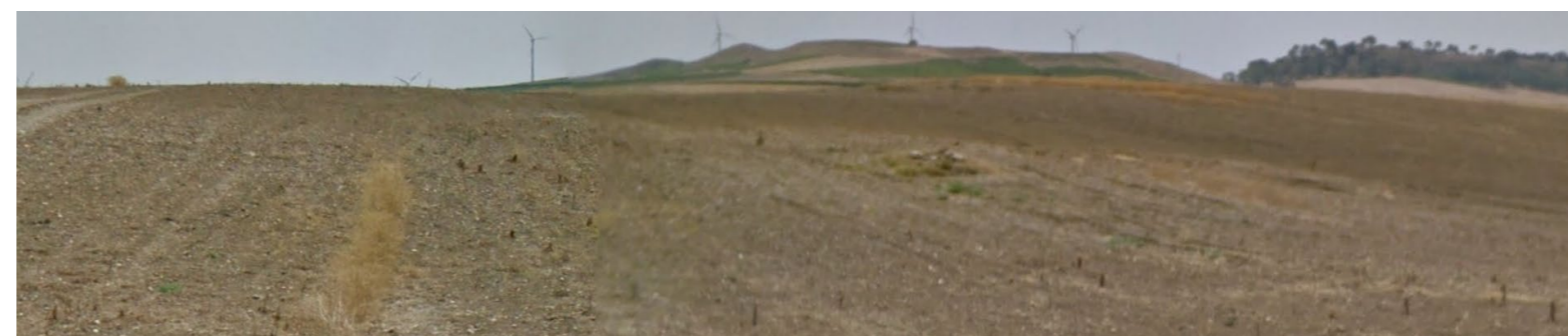
Figura 9: panoramica dell'area interessata dalle opere per la realizzazione dell'aerogeneratore T2
