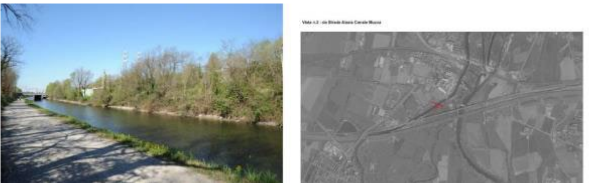
Fig.35 vista da strada Alzaia canale Muzza – stato di fatto
