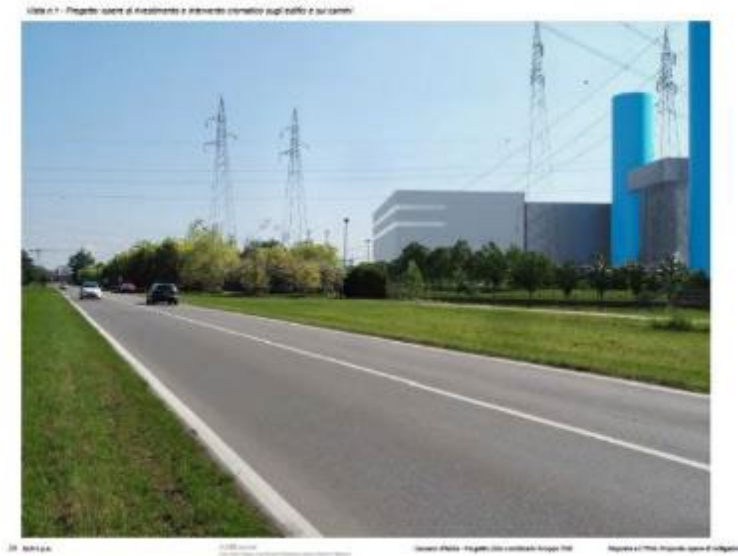
Fig.33 vista da strada provinciale Sp104 -opere di rivestimento e intervento cromatico su camini
