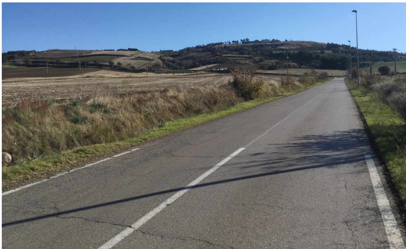
Foto 1 – Vista panoramica del tratto interessato dalla realizzazione del viadotto NV05.
