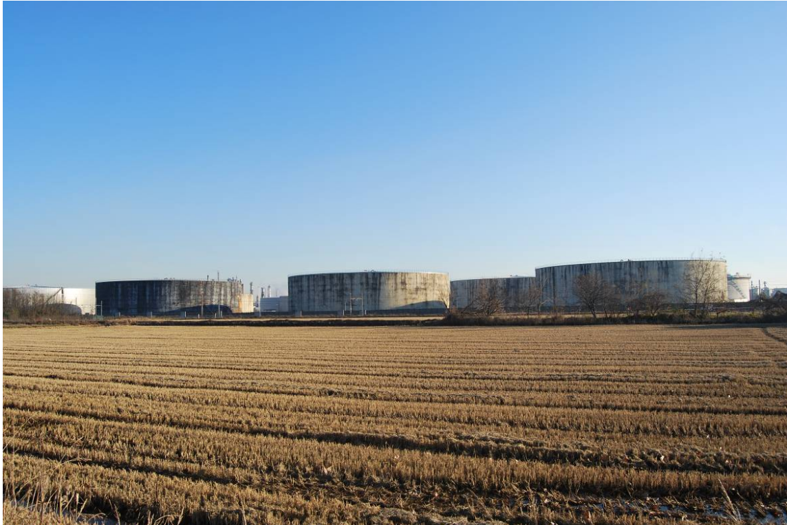
Figura 16 – I serbatoi della Sarpom visti dalla SS 11
