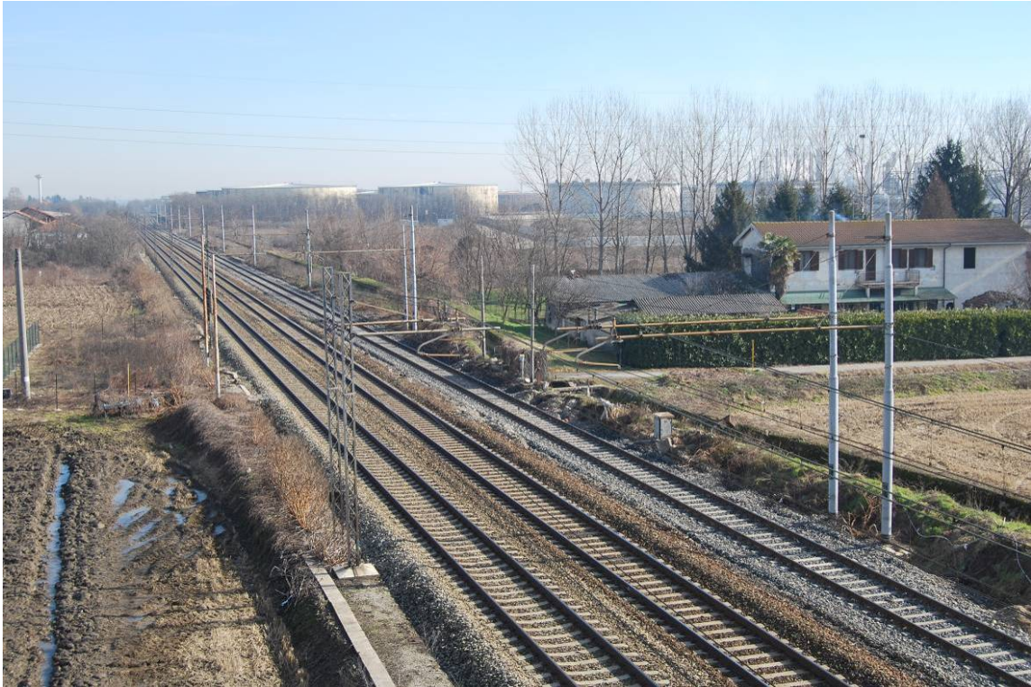
Figura 17 – Vista verso est: la linea FF SS Torino Milano e sullo sfondo i serbatoi della Sarpom
