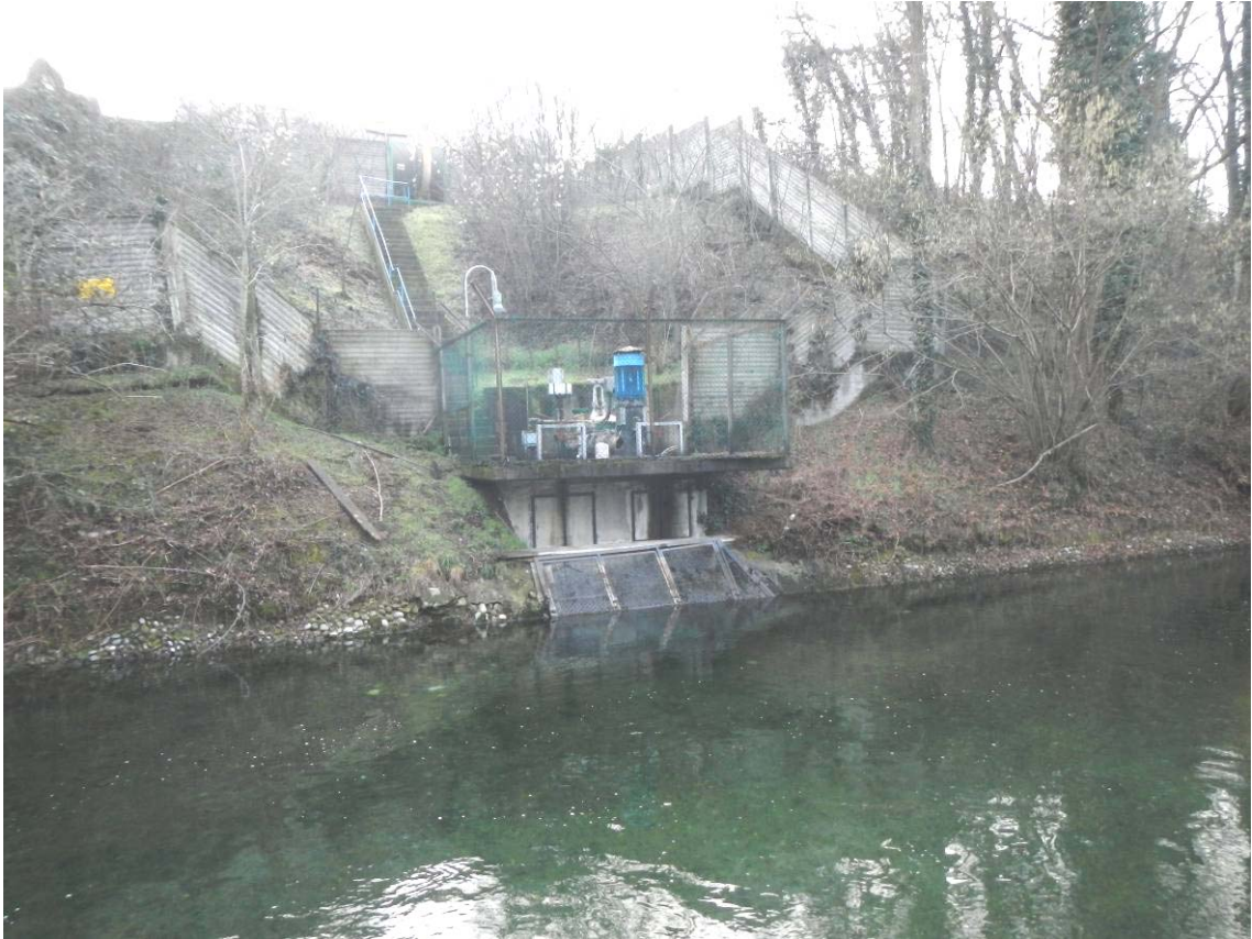
Fig. 46 – Vista dell’opera di presa sul naviglio Langosco
