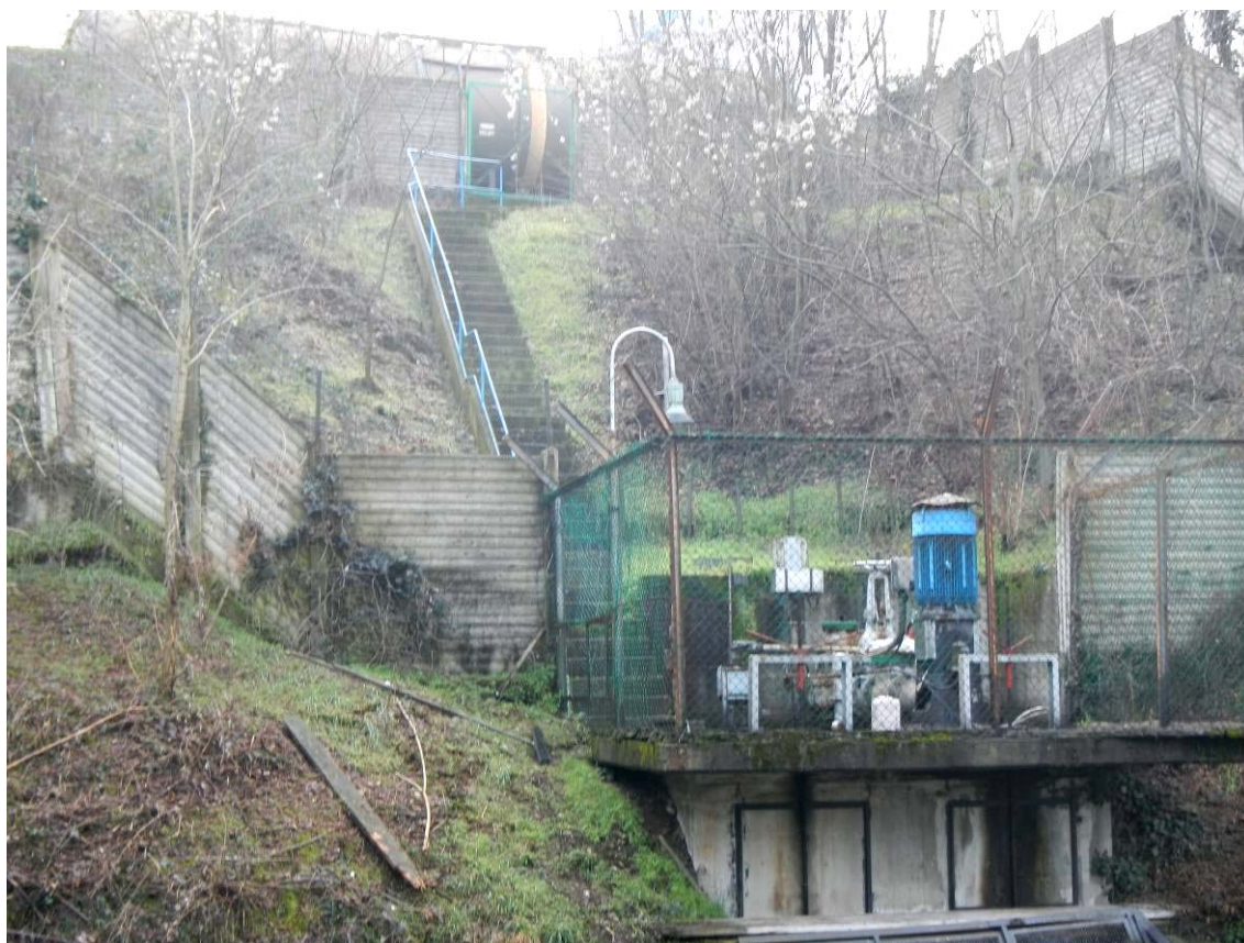
Fig. 45 – Vista dell'opera di presa sul naviglio Langosco
