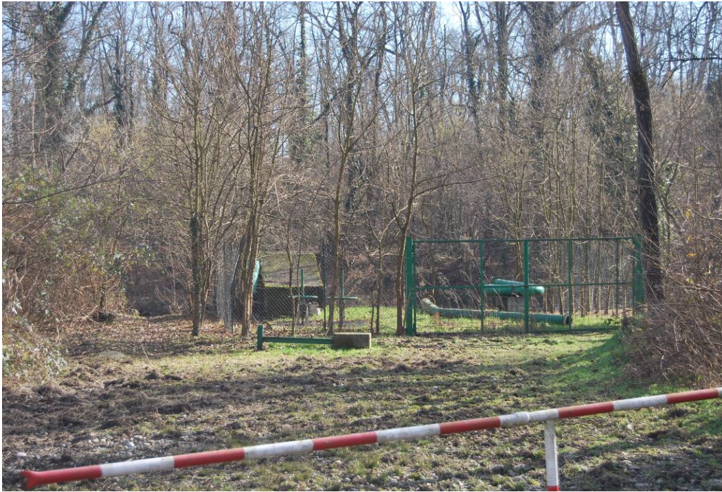
Fig. 48 – Vista dell'impianto di scarico: sulla parte destra si nota il cancello di ingresso
