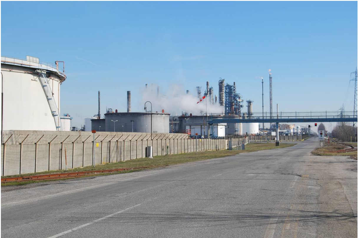
Fig. 14 – Vista della Via S. Cassiano in direzione della SP 6
