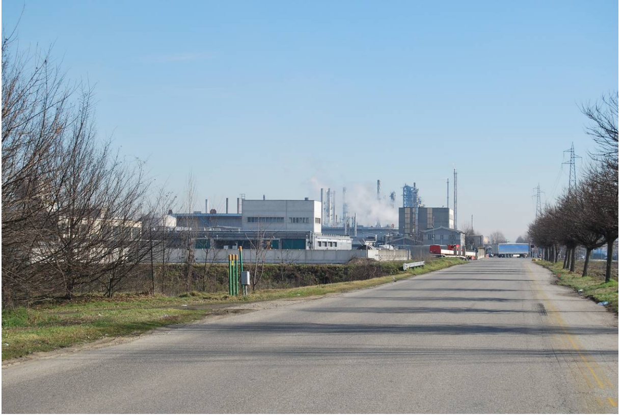
Fig. 13 – Vista della Via S. Cassiano in direzione della SP 6
