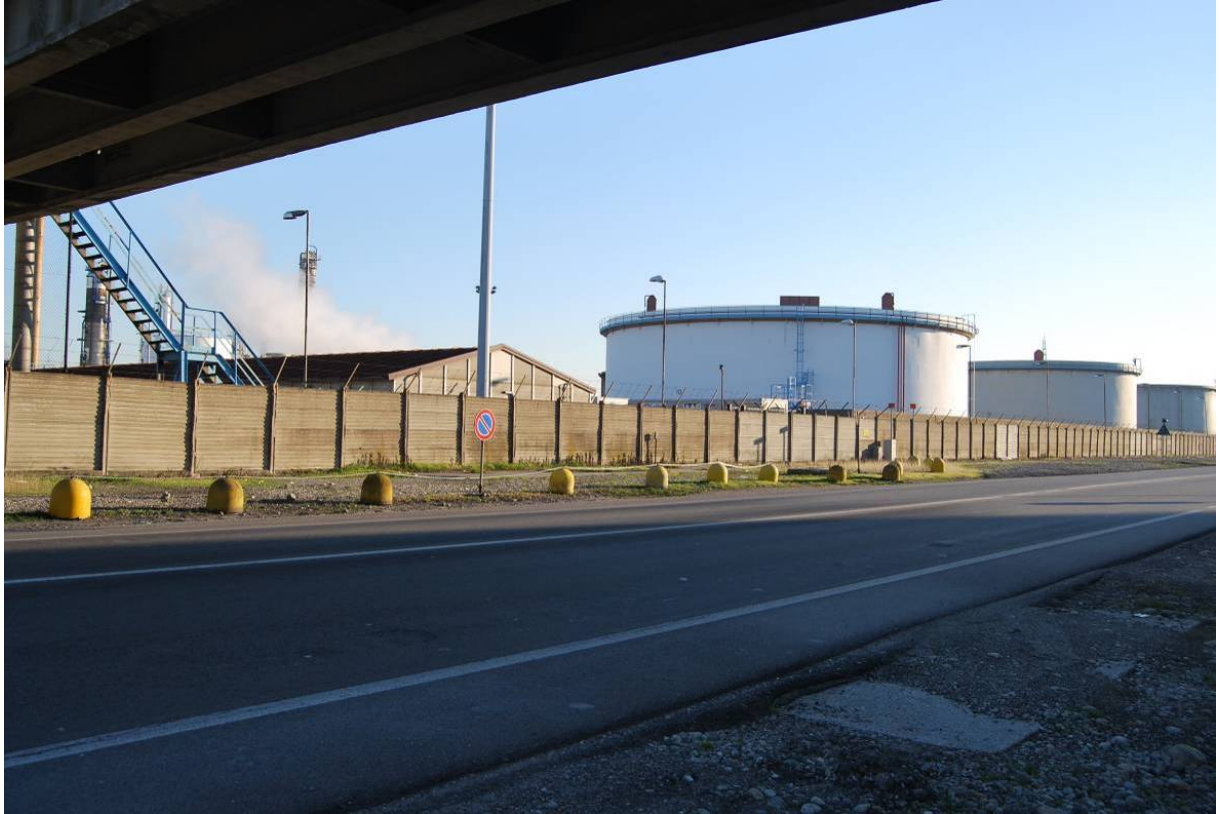
Figura 26 – Vista dalla SP 6
