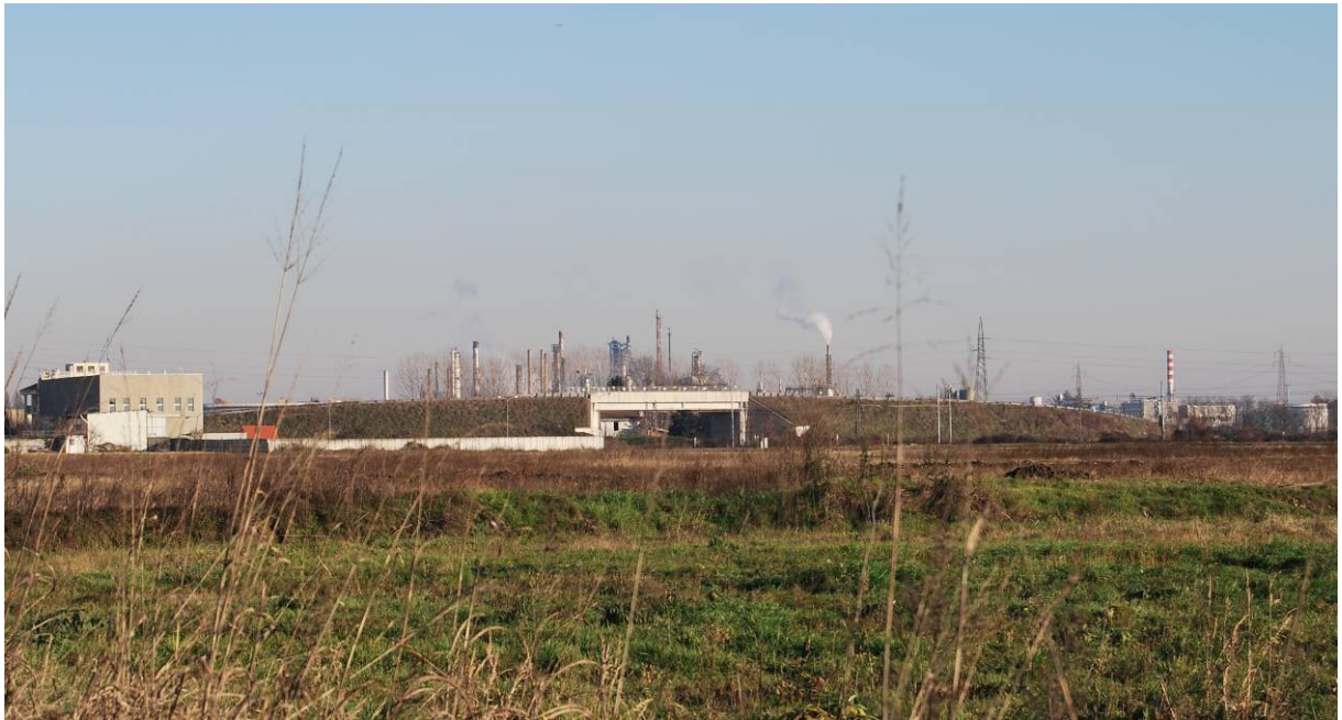
Figura 8 – L'impianto della raffineria visto dalla SS 11: la distanza e alcuni elementi come il sovrappasso mitigano la vista
