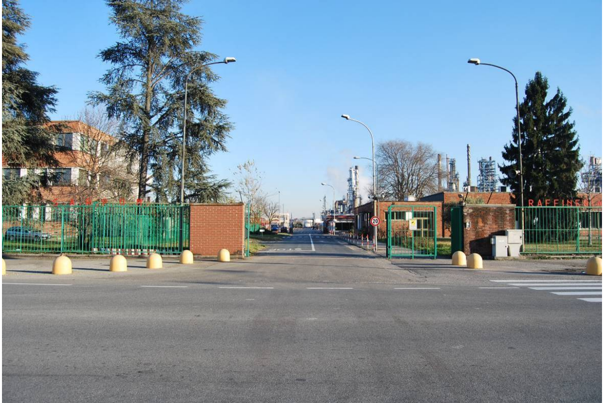
Figura 24 – Vista dalla SP 6: ingresso della Sarpom
