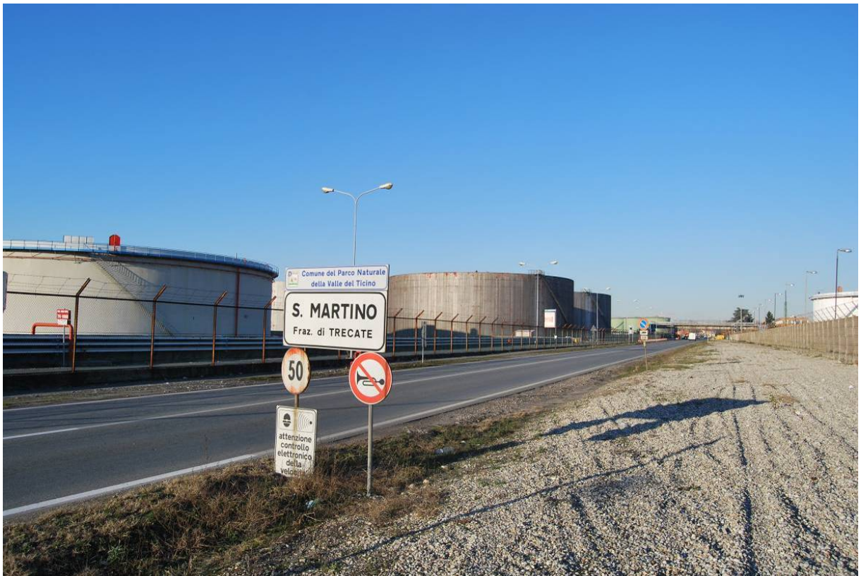
Figura 27 – Vista dalla SP 6 da Cerano verso San Martino
