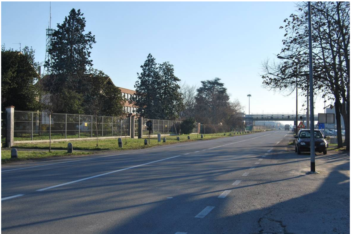
Figura 23 – Vista dalla SP 6: la zona degli uffici della Sarpom
