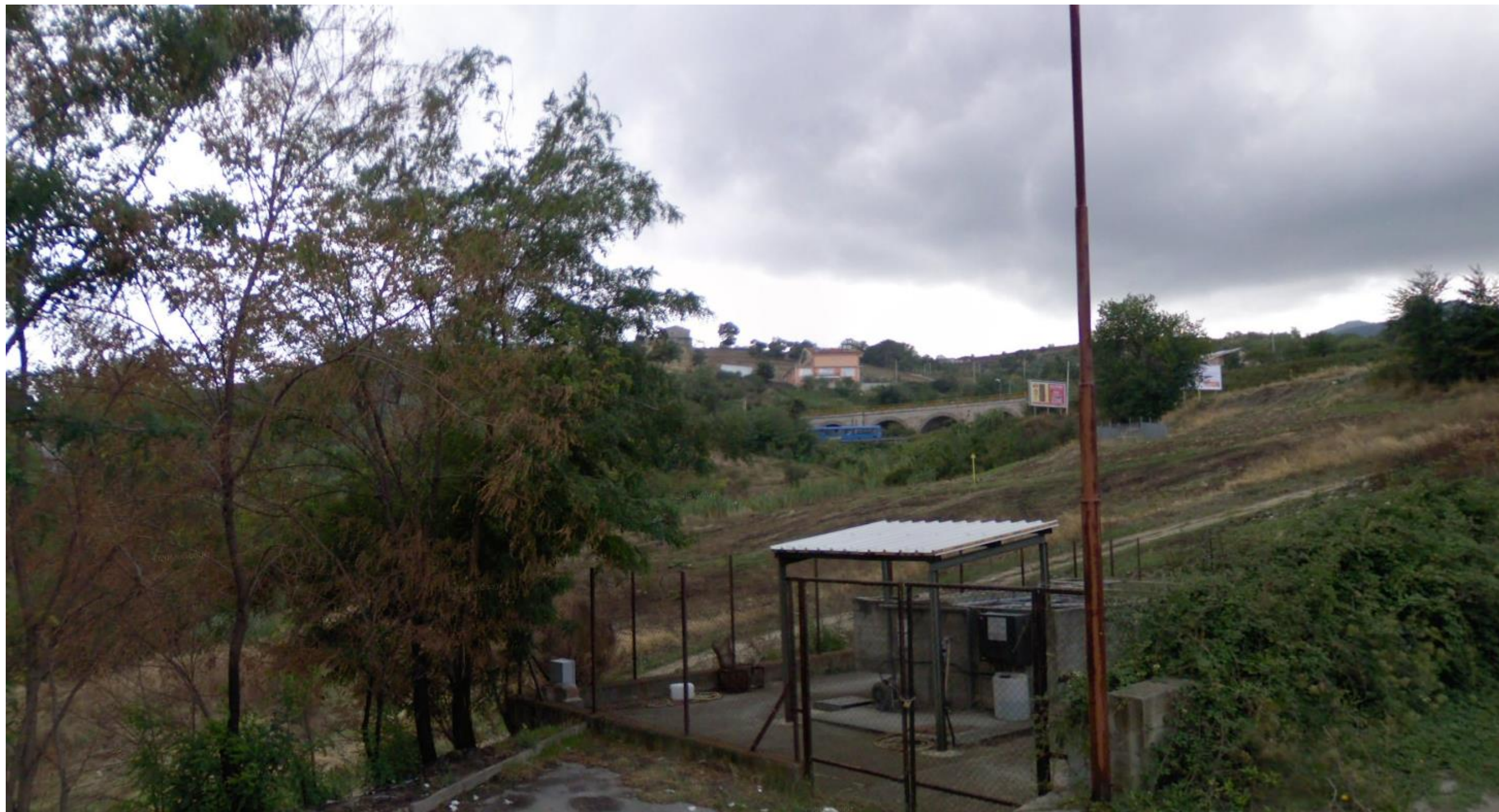
Punto 2 - Vista dall'area industriale a sud dell'insediamento di Barile in direzione dell'area di intervento che interferisce con il tratto vincolato ai sensi dell'art.142 comma 1 lett. m) D.Lgs 42/2004. Il nuovo intervento si svilupperà antistante il ponte della ferrovia, connettendo l'insediamento di Barile a quello di Rionero In Vulture. (fonte: Google Earth).
