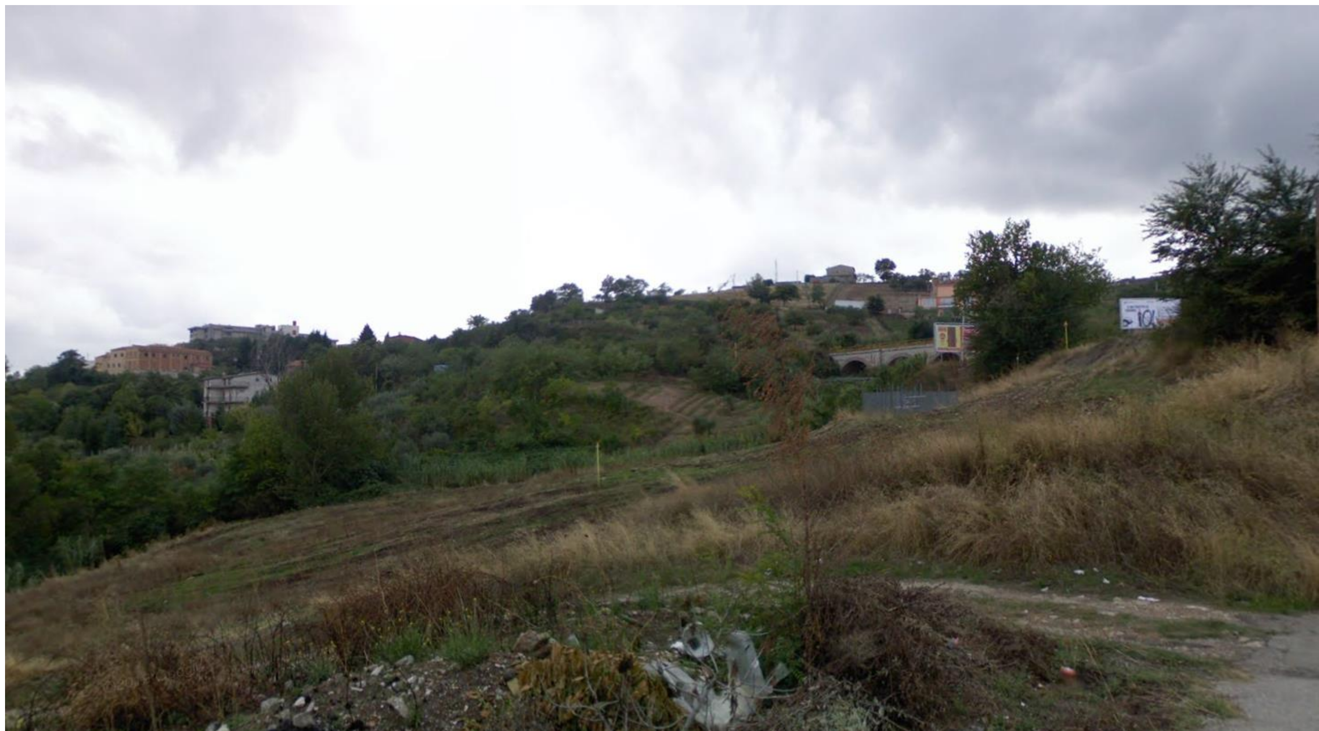
Punto 1 - Vista dall'area industriale a sud dell'insediamento di Barile in direzione dell'area di intervento. A destra dell'immagine, in secondo piano, è individuabile il ponte della ferrovia su arcate nella cui prossimità, è presente il tratturo vincolato ai sensi dell'art.142 comma 1 lett. m) D.Lgs 42/2004. Il nuovo intervento si svilupperà antistante il ponte della ferrovia, connettendo l'insediamento di Barile a quello di Rionero In Vulture. In primo piano, sarà realizzata la deviazione di via delle More. (fonte: Google Earth).
