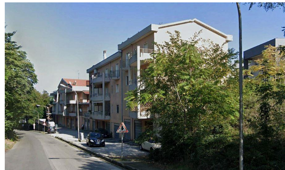
Figura 2-29 Edifici lungo la s.s.93, nel contesto edilizio più prossimo all'area di progetto – Fonte: Google Street View
