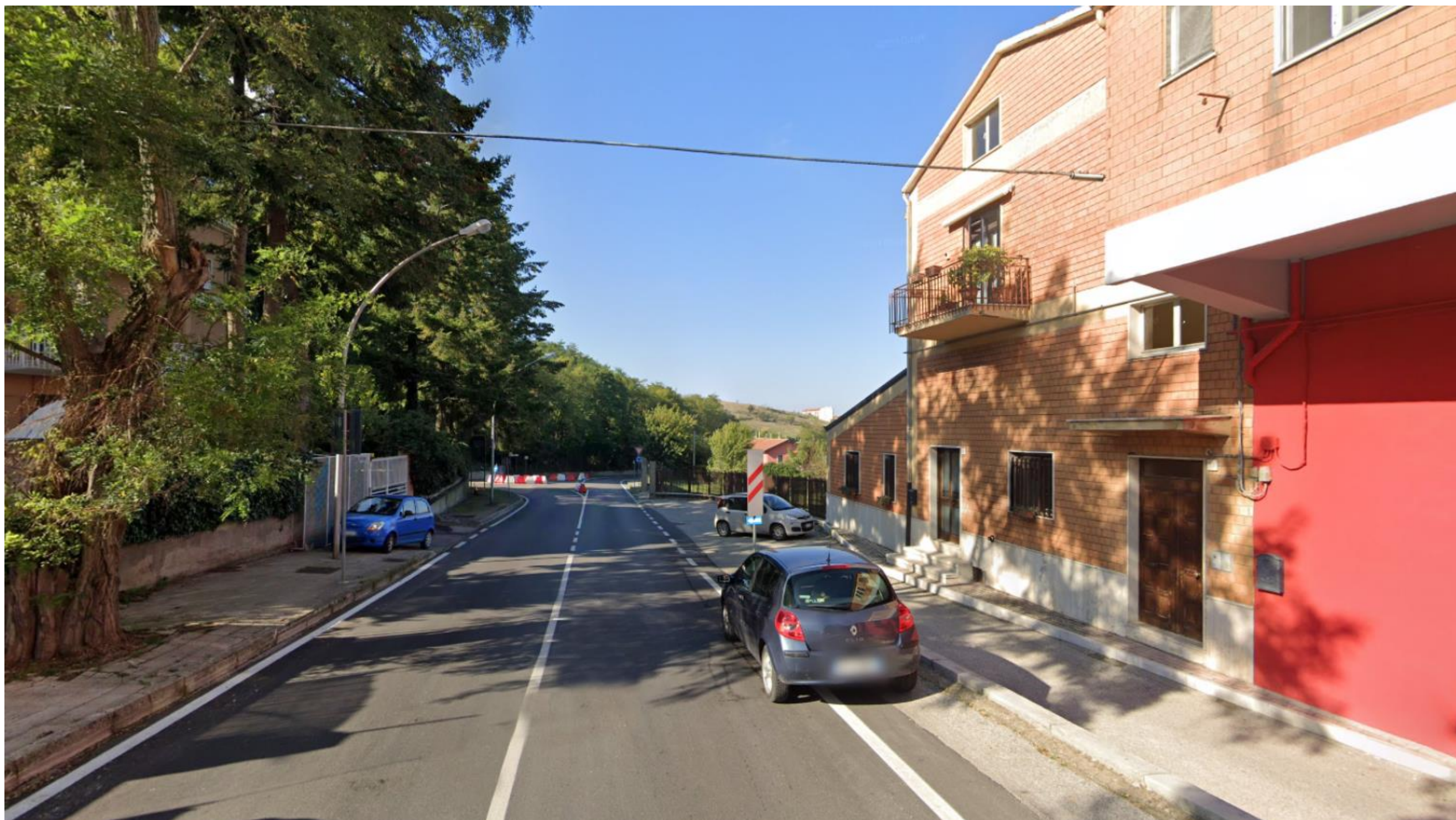
Punto 5 - Vista da via Padre Pio, a nord dell'insediamento di Rionero in Vulture, verso nord in direzione del comune di Barile. L'incrocio in secondo piano vedrà la realizzazione di una nuova rotonda e un riassetto generale della viabilità proprio in corrispondenza del vincolo del tratturo, del quale non si riscontra traccia della sua struttura morfologica originaria. (fonte: Google Earth).
