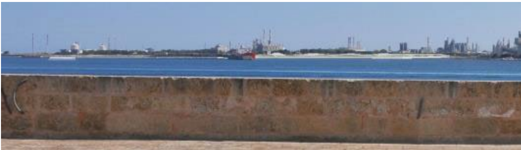
Figura 54 - Situazione post operam
