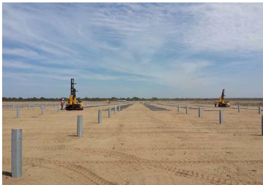
Figura 12 – Posa in opera profili di palificazione
