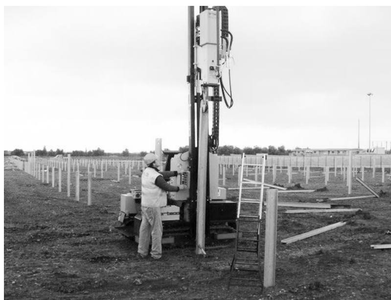
Figura 13 – Infissione con macchina battipalo
