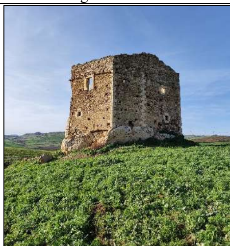
Torre di Albospino vista da SE
