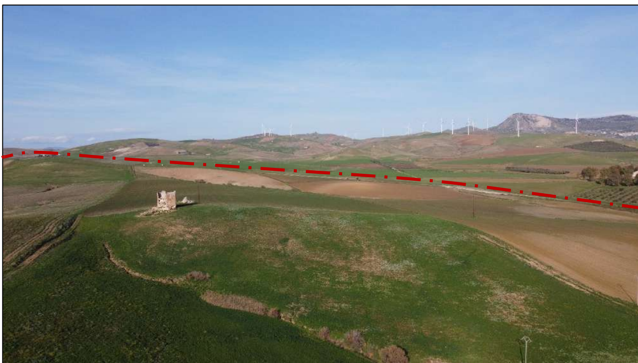
Fig. 20: vista da drone del settore centrale dell'impianto, in prossimità della Torre di Albospino
