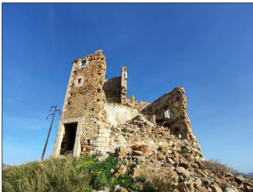
Torre di Albospino, prospetto occidentale
