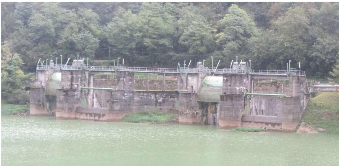
**Figura 5** – Imbocchi degli scarichi di superficie in sponda sinistra
