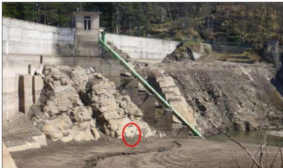
Figura 3 – Localizzazione nuova opera di presa dello scarico di fondo.
