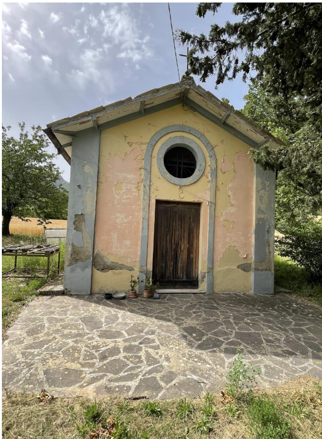
Foto 3-3 Chiesa rupestre in stato di abbandono.
