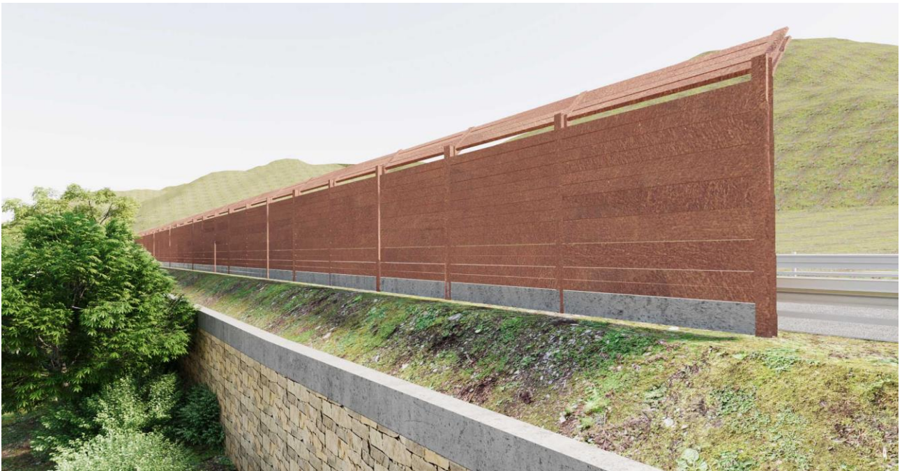
Figura 5-41 - Esempio di barriere acustiche in corten su muro sottoscarpa
