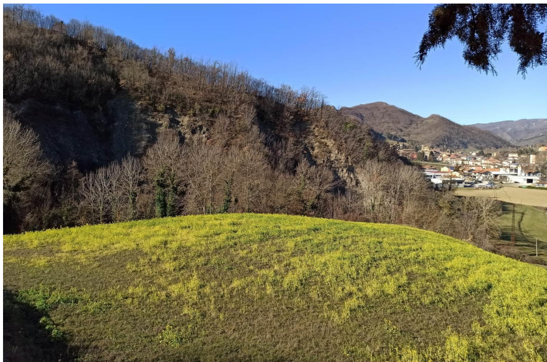
Foto 3-7 Imbocco est della seconda galleria
