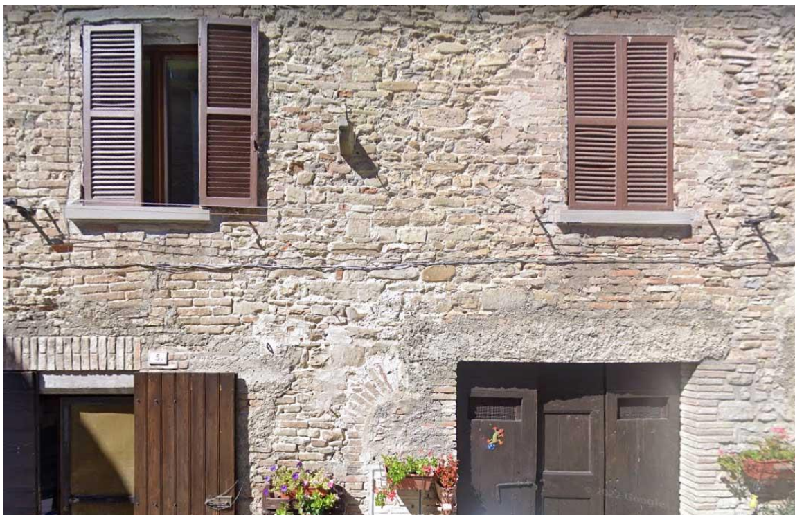
Figura 5-28 Esempio di muratura mista pietra/laterizio - edificato storico di Mercatello
