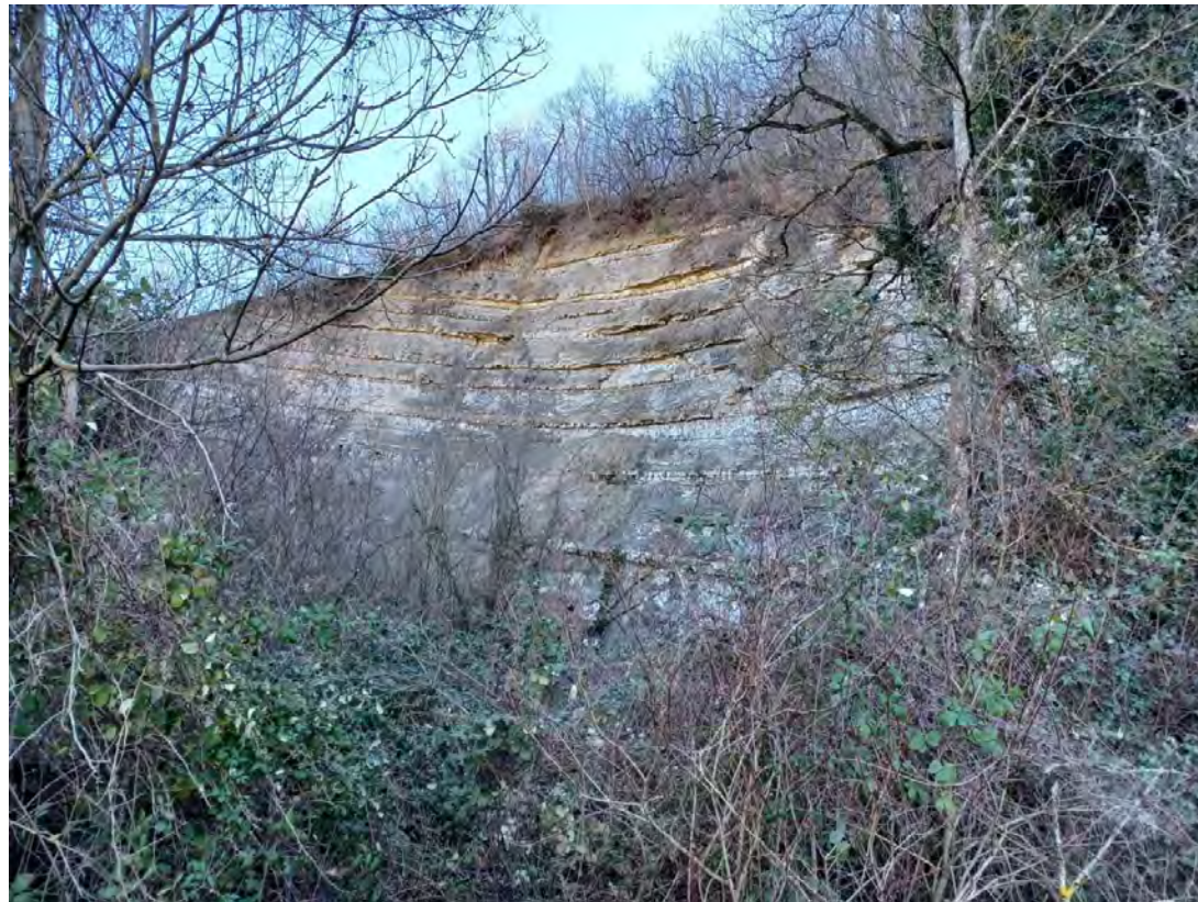
Foto 4-1 Affioramento della parte sommitale del Membro di Corniolo, spesso circa 30 m, in destra idrografico del Torrente S. Antonio, presso l'origine dei tracciati stradali in località Casa Tabina; sono evidenti gli strati e banchi arenacei, in rilievo sulla superficie della scarpata in quanto più resistenti all'erosione delle peliti circostanti.
