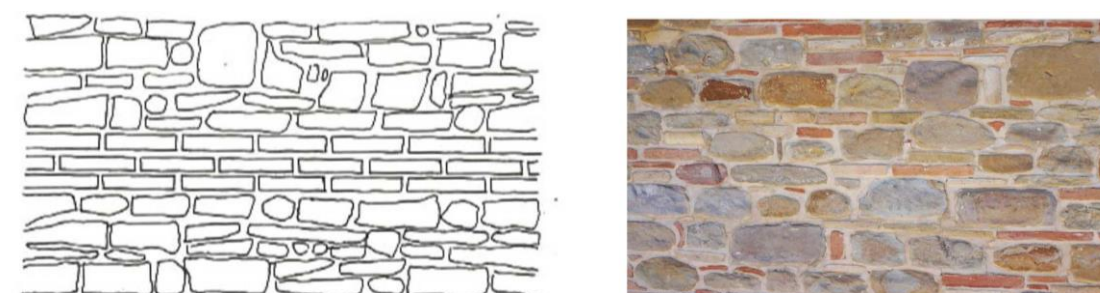
Figura 7-6 - Esempio di muratura arenaria/calcareo mista a laterizio (da Marinelli F., 2017. L'architettura delle campagne marchigiane. Ricerca sull'architettura rurale nelle Marche centro-meridionali. Tesi di Laurea - Politecnico di Milano)
