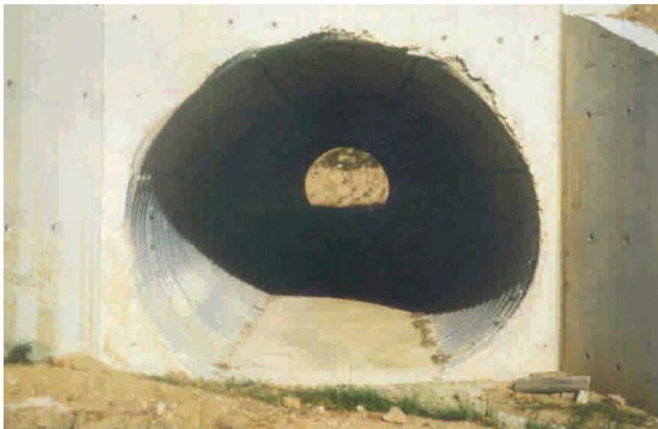
Figura 3-1 Tombino a scopo idraulico adattato ad un possibile uso da parte della fauna
