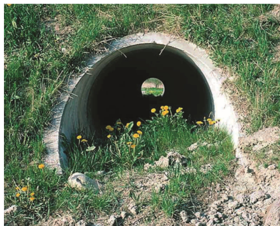
Figura 3–6 Esempi di sottopasso per mammiferi di media e piccola taglia (da Luell, 2003)
