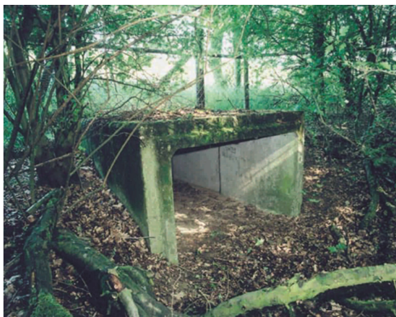
Figura 3–6 Esempi di sottopasso per mammiferi di media e piccola taglia (da Luell, 2003)
