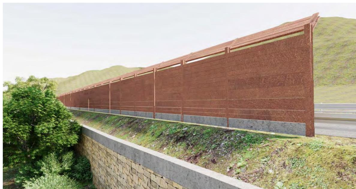
Figura 7-22 - Esempio di barriere acustiche in corten su muro sottoscampa - T00IA14AMBDT04
