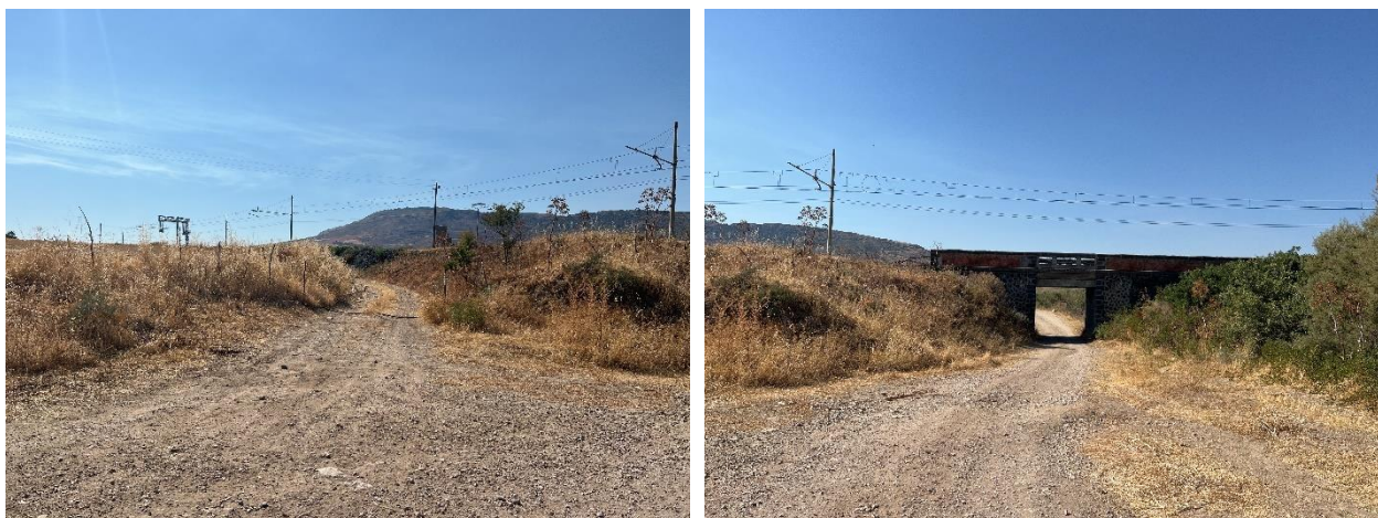
Figura 3.2: Presa Fotografica 1 - interferenza rappresentata dalla Rete Ferroviaria. L'attraversamento previsto non interesserà però la ferrovia in sé in quanto il Cavidotto risulta essere interrato al di sotto del ponte ferroviario.
