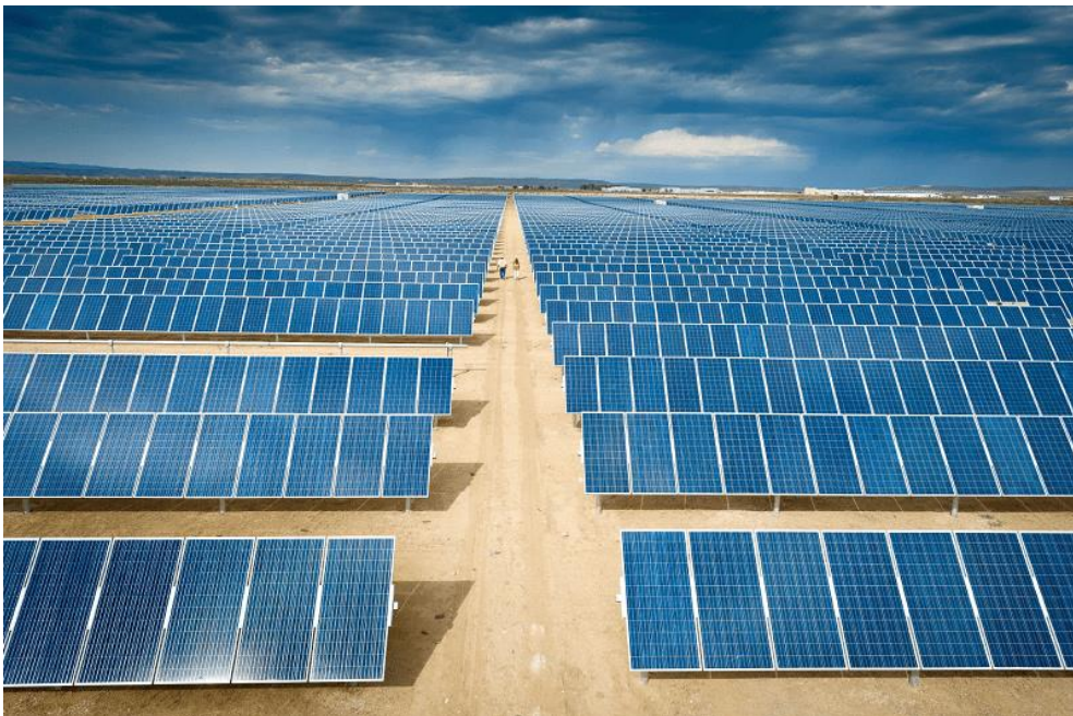
Figura 3.2: Esempio struttura fissa
