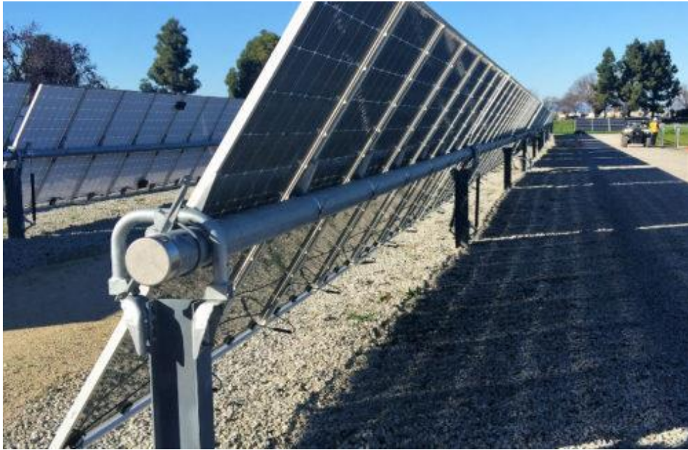
Figura 3.1: Esempio di struttura a tracker monoassiale.
