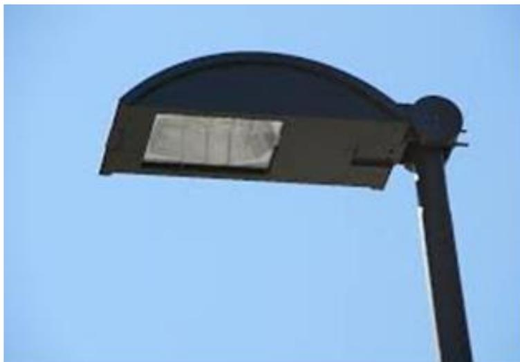
*Figura 4.41: Esempio di apparecchio completamente schermato (full-cut-off).*
