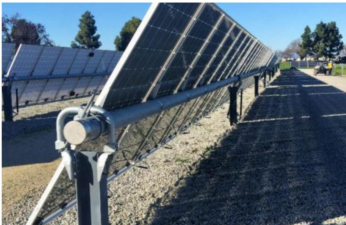
Figura 2.38: Esempio di struttura a tracker monoassiale
