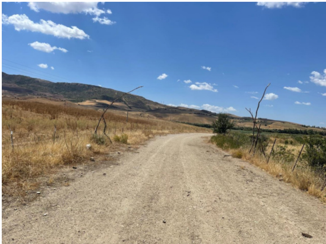
Foto 28 - Panoramica UR 05 (cavidotto interrato)
