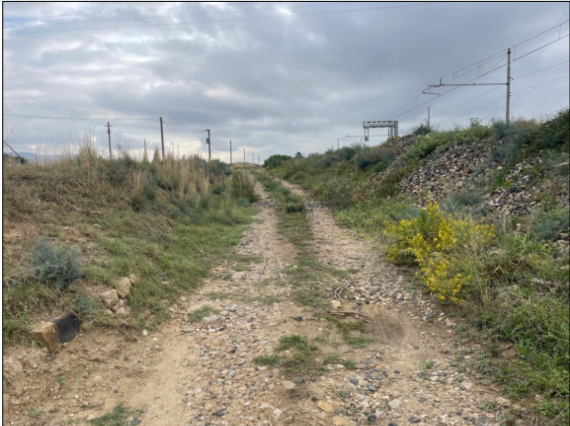
Foto 27 - Panoramica UR 05 (cavidotto interrato)
