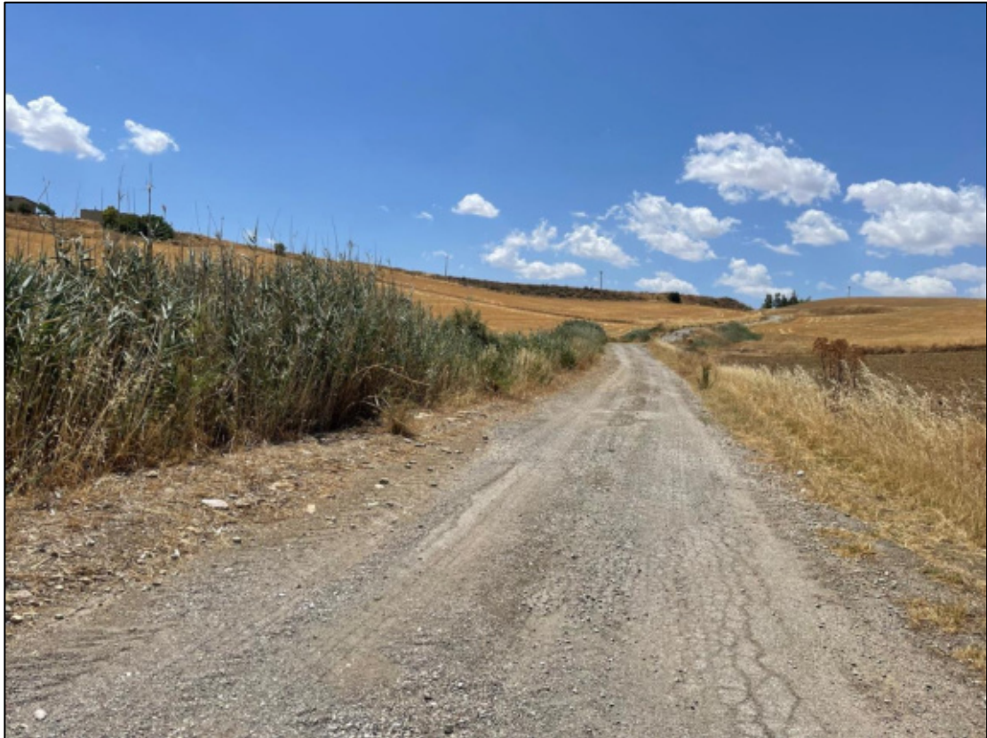
Foto 31 - Panoramica UR 07 (cavidotto interrato)
