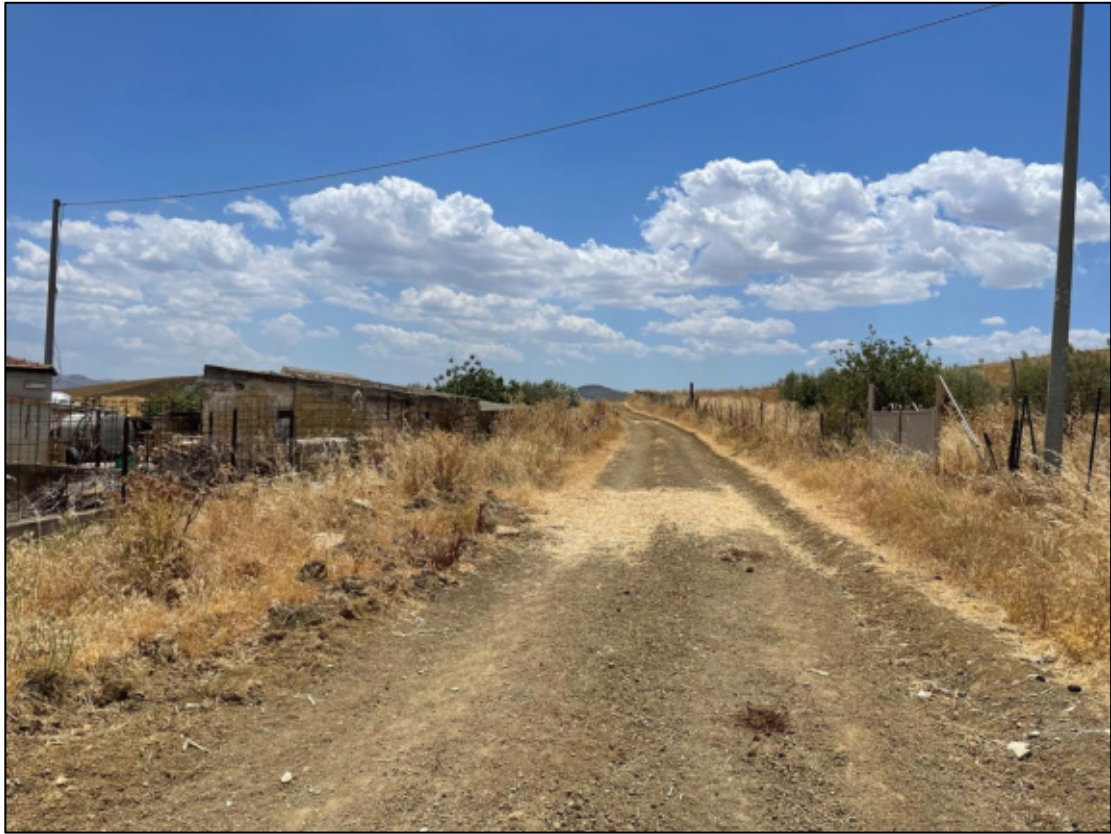
Foto 51 - Panoramica UR 08 (cavidotto interrato)
