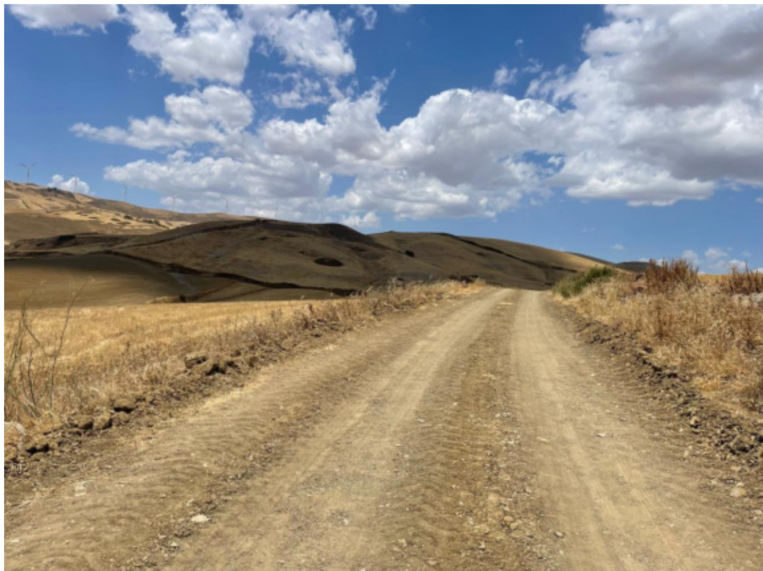
Foto 48 - Panoramica UR 08 (cavidotto interrato)
