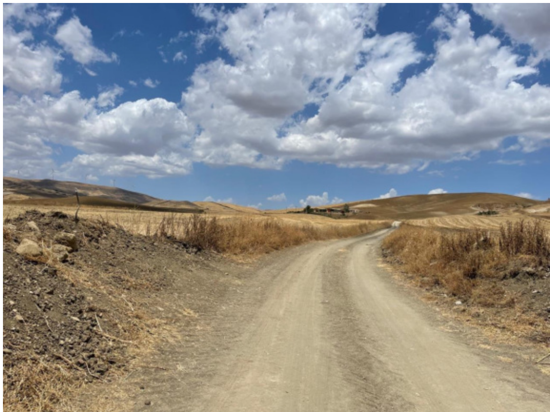
Foto 50 - Panoramica UR 08 (cavidotto interrato)
