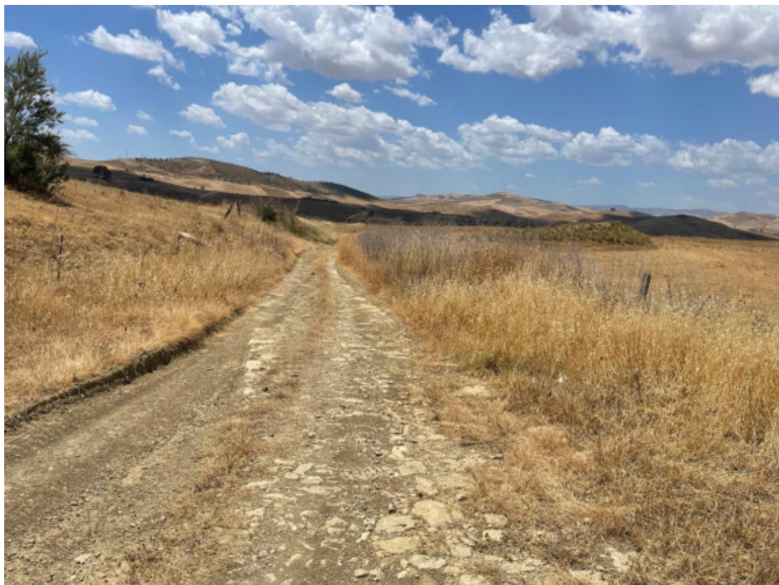
Foto 36 - Panoramica UR 07, basolato in situ R.T. n. 358 Raddusa-Regalbuto (cavidotto interrato)
