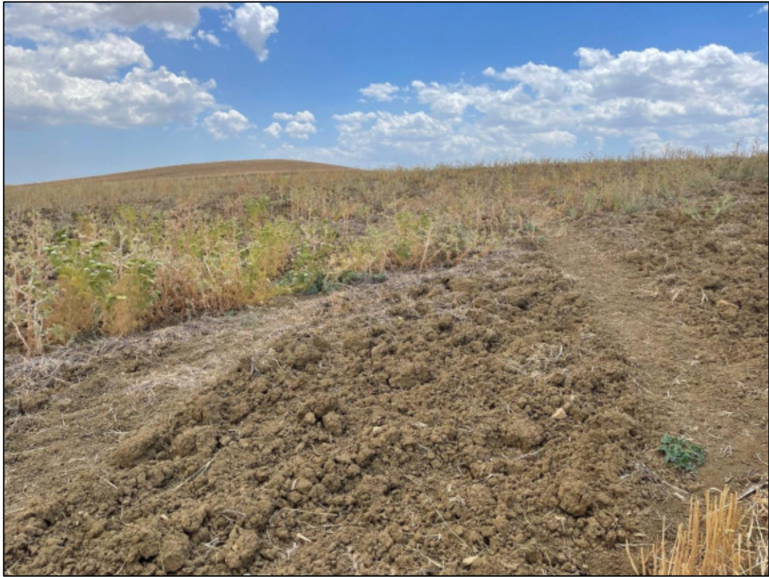
Foto 53 - Panoramica UR 09 (sottostazione elettrica)
