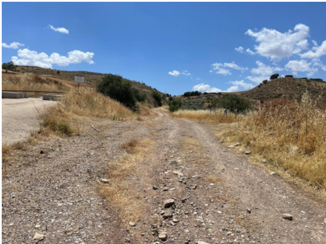
Foto 32 - Panoramica UR 07 (cavidotto interrato)
