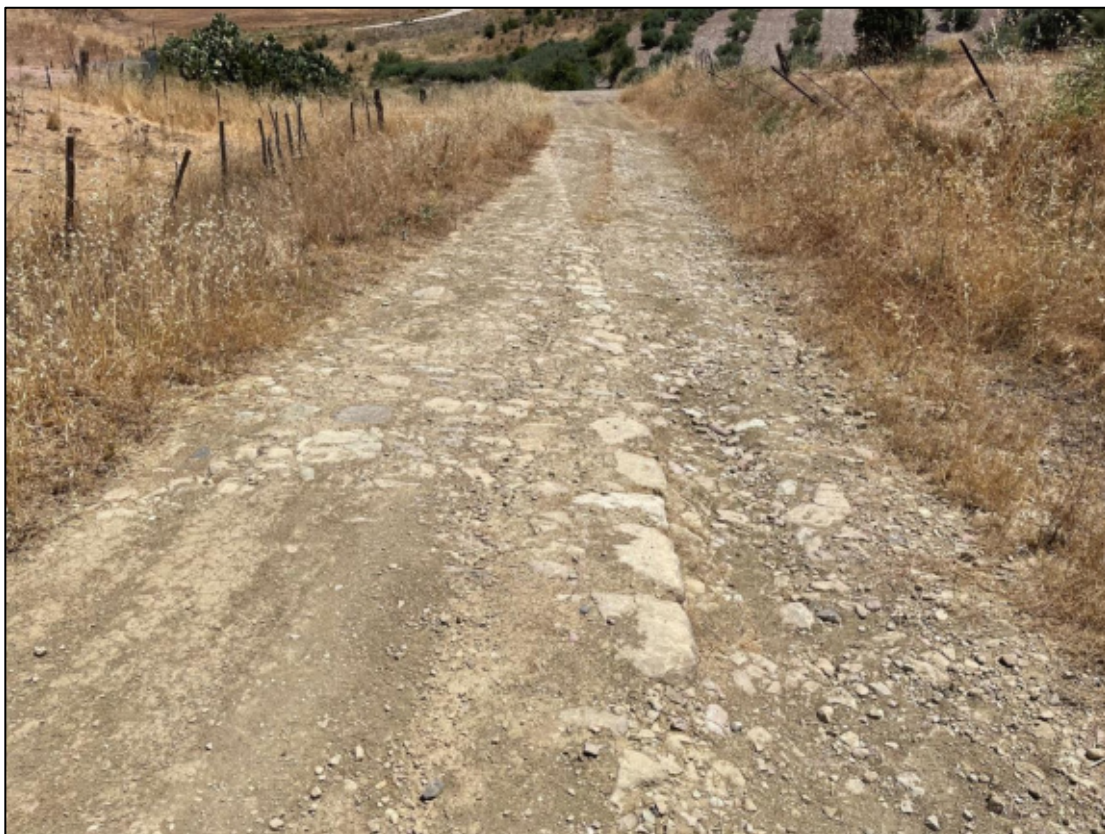
Foto 33 - Panoramica UR 07, basolato in situ R.T. n. 358 Raddusa-Regalbuto (cavidotto interrato)
