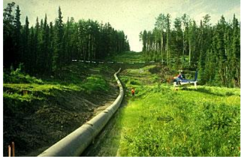
Fig. 12 - A sinistra il modello illustra l'interazione tra una frana ed una condotta disposta perpendicolarmente alla direzione di movimento della frana (Treccani). A destra: un oleodotto che si è spostato lateralmente di 9,5 m a causa di una frana.
