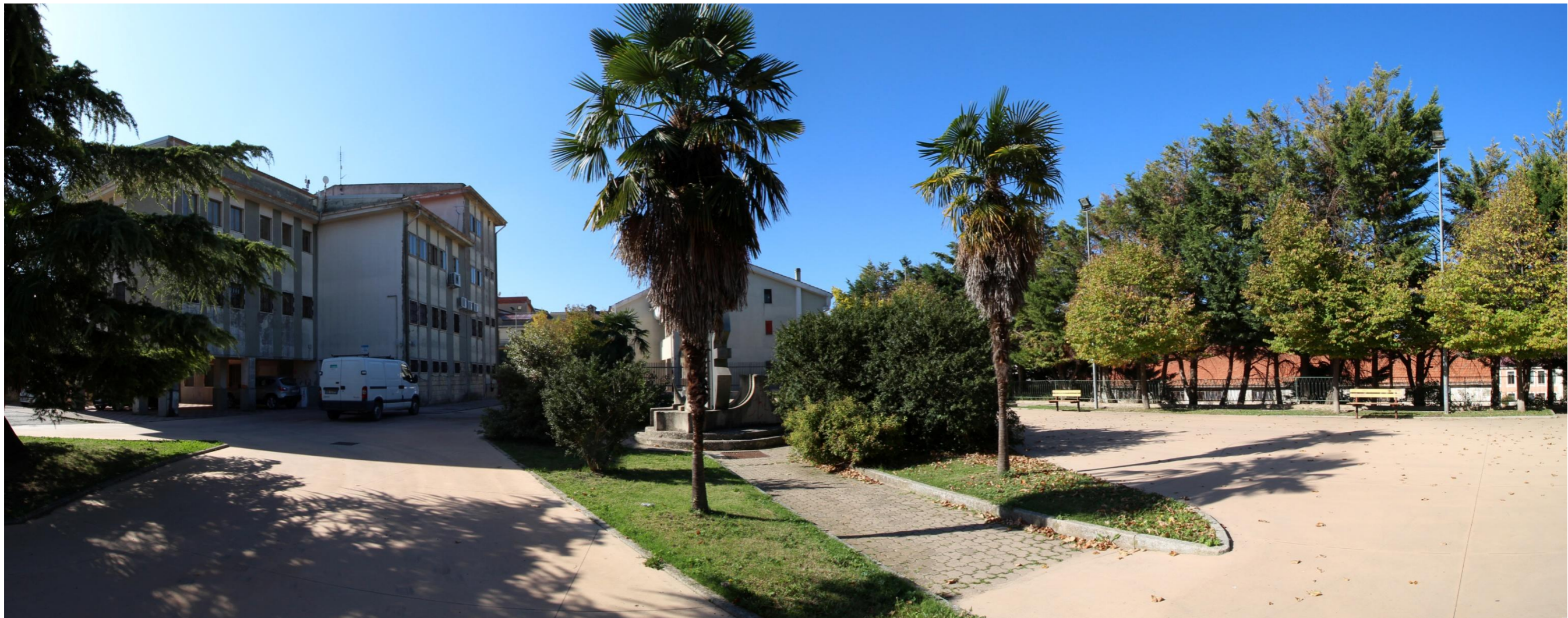
Scatto 12_Vista da Largo Omero_ANTE OPERAM = POST OPERAM
