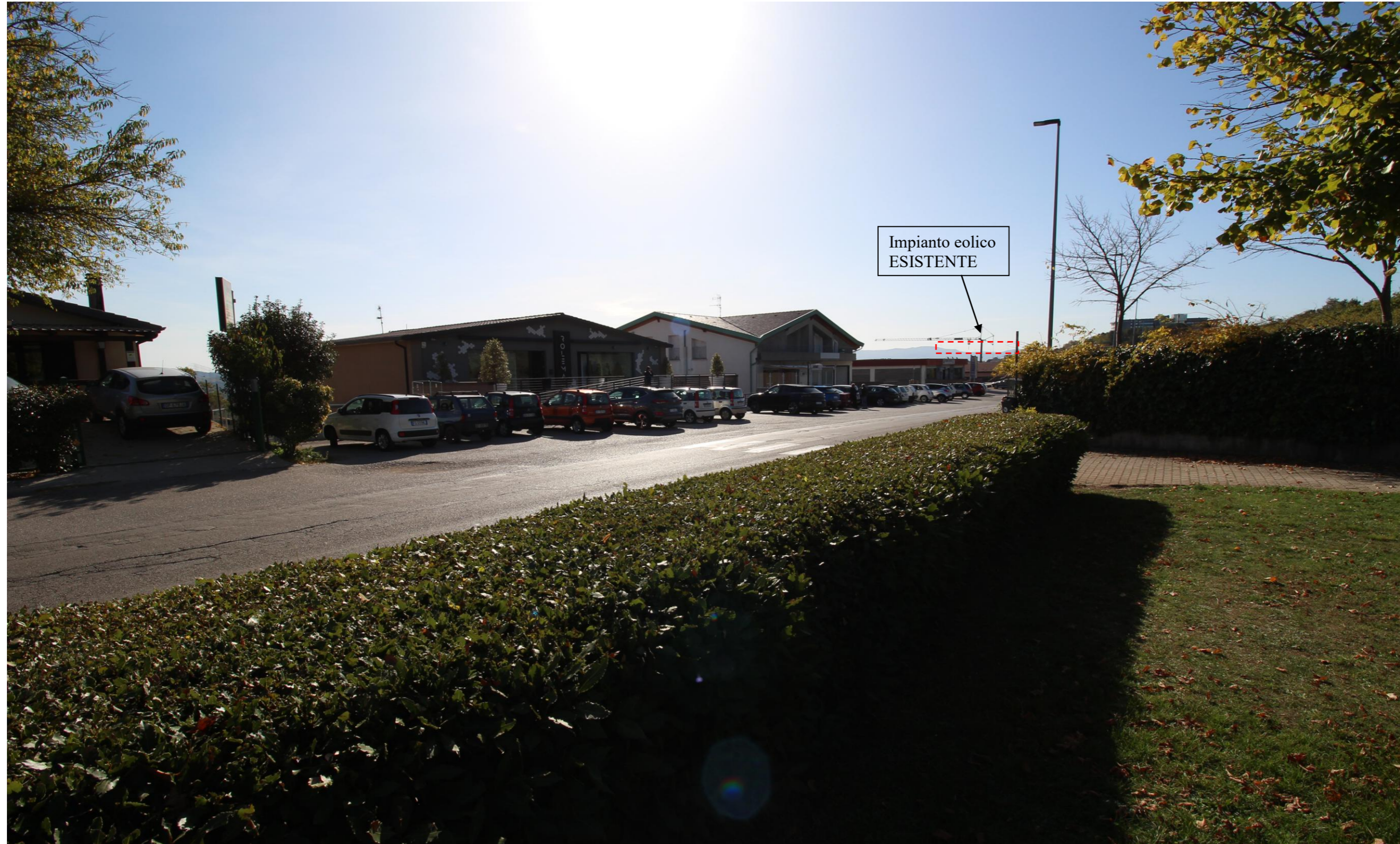
Scatto 1_Vista da Piazza Unità d'Italia-Barile_ANTE OPERAM = POST OPERAM
