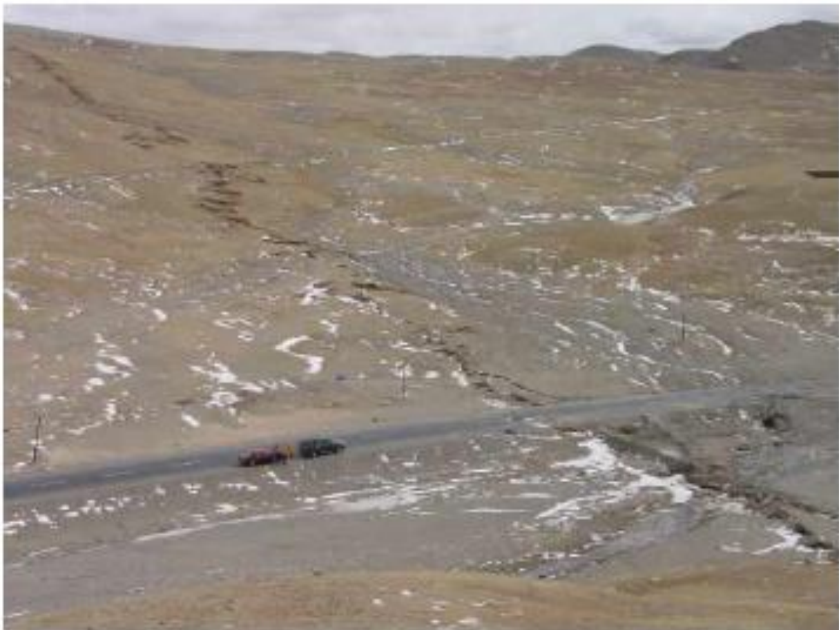
Fig. 24 - Rottura di un oleodotto sepolto a causa di un terremoto nel 2001 vicino a Qinghai-Xinjiang, Cina. La foto mostra la rottura del suolo a causa di una faglia trascorrente che attraversa la strada perpendicolarmente e che è stata caratterizzata da un rigetto orizzontale di 3,5 metri e da uno verticale di 0,8 metri. L'oleodotto attraversa la strada nello stesso punto in cui viene attraversata dalla faglia (Fig. 25).
