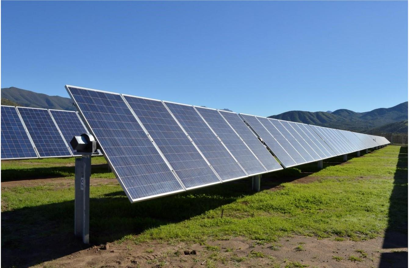
Le strutture di sostegno (infisse al suolo) e di movimento dei tracker saranno in acciaio galvanizzato secondo normativa ISO 1461:2009.
