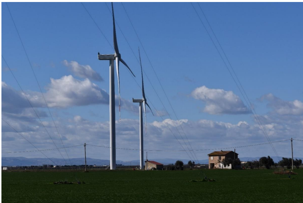
Figura 81 - Sito, impianto eolico esistente, anemometro (da rimuovere) e case coloniche
