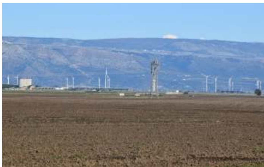
Figura 21 – Punto di innesto Stazione Elettrica
