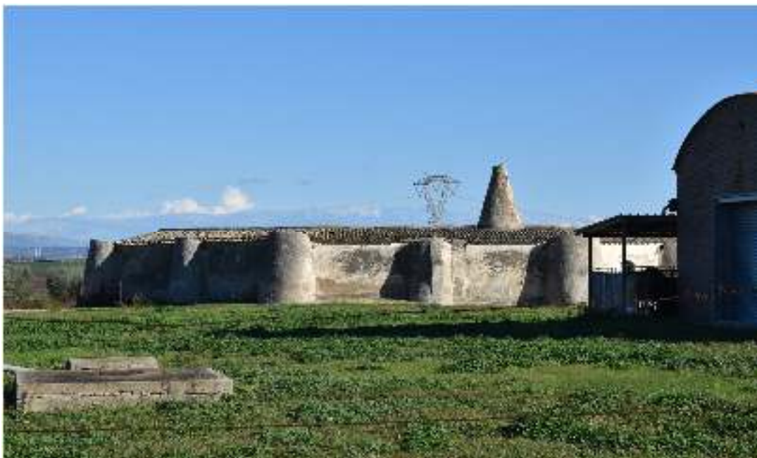
Figura 18 – Masseria su Strada Provinciale 13
