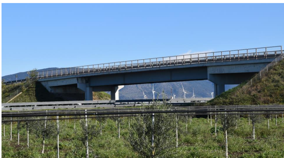
Figura 37 - Ponte di sovrappasso su Autostrada Adriatica (2)
