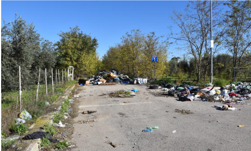
Figura 40 - Sottopasso ferroviario su strada comunale a Strada Statale (3)
