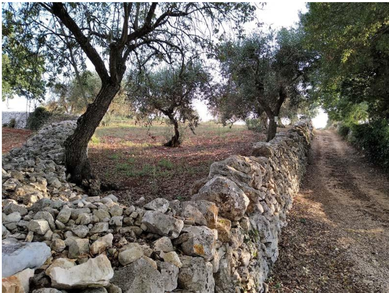
Figura 76 - Esempio di muretto a secco pugliese tipico
