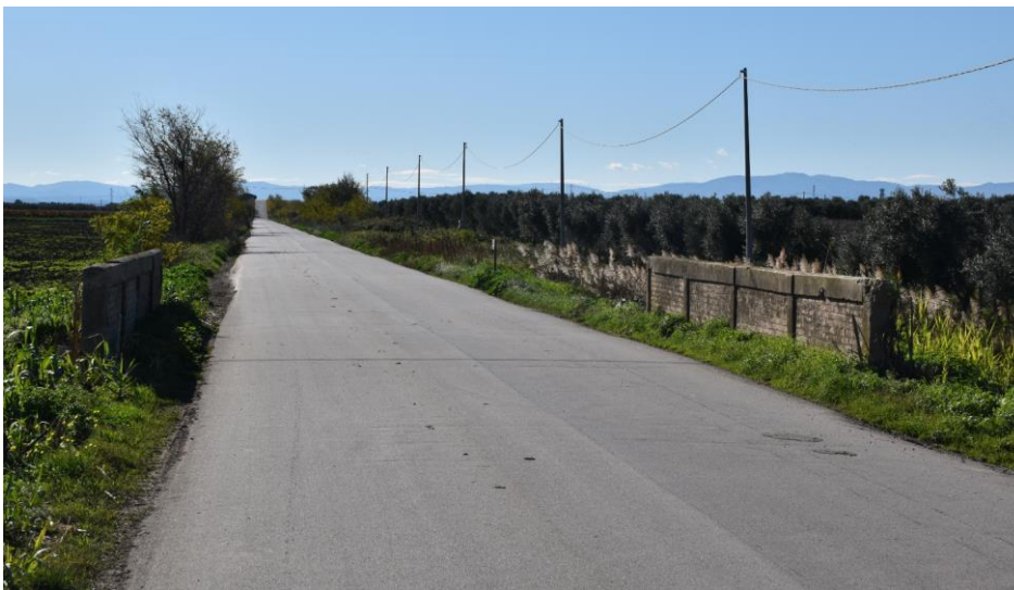
Figura 36 - Tratto su Strada Provinciale 27, ponticello (1)
