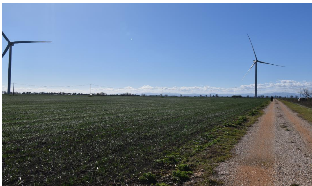
Figura 14 - Area impianto da Ovest
