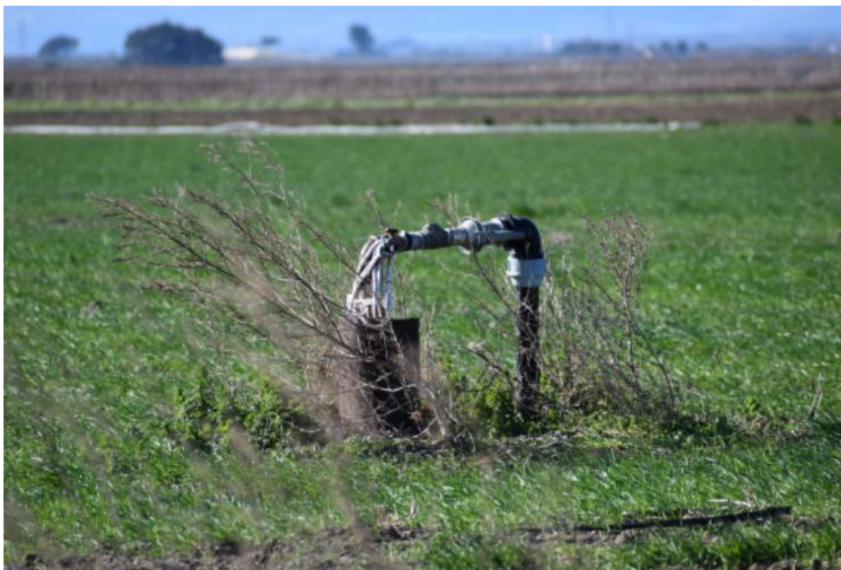
Figura 23 - Particolare area con pozzo esistente
