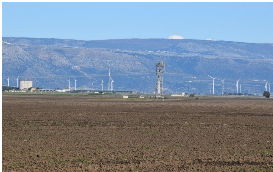
Figura 51 - Punto di innesto Stazione Elettrica
