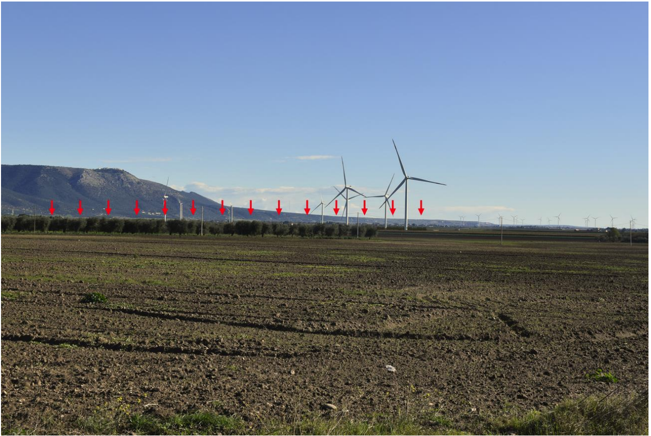
Figura 43 - Vista da Nord Ovest nei pressi delle pale eoliche di progetto
