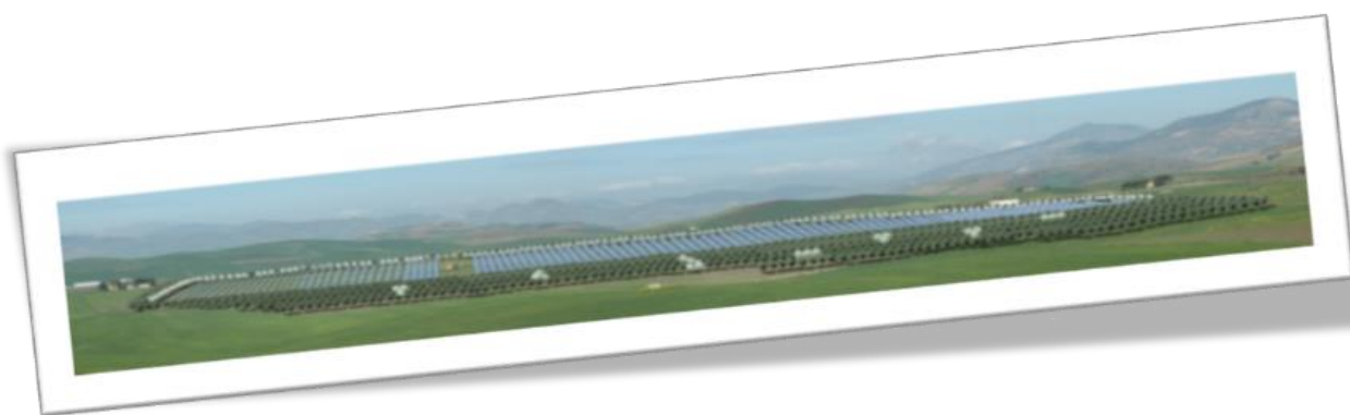
Figura 39 - Impianto fotovoltaico da 5 MW, "Heliospower", Monreale /(PA) 2010
