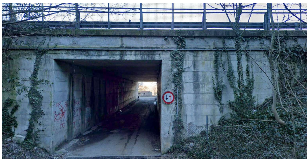
Figura 10-3 Sottopasso stradale al disotto della S.S. 36
