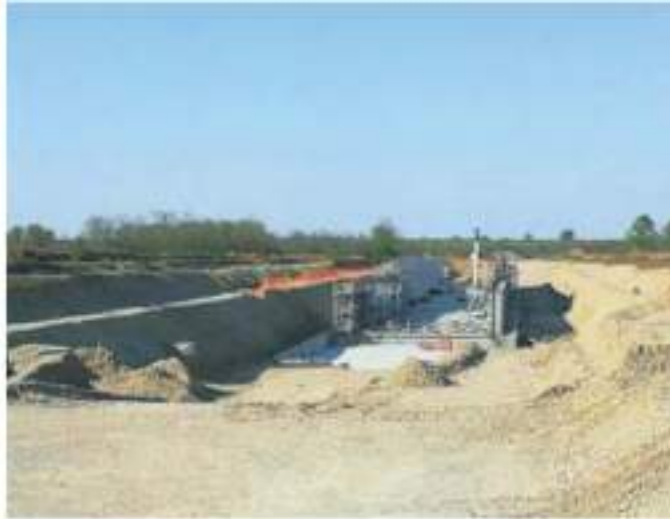
Cantiere Terzo Valico di Pozzolo
