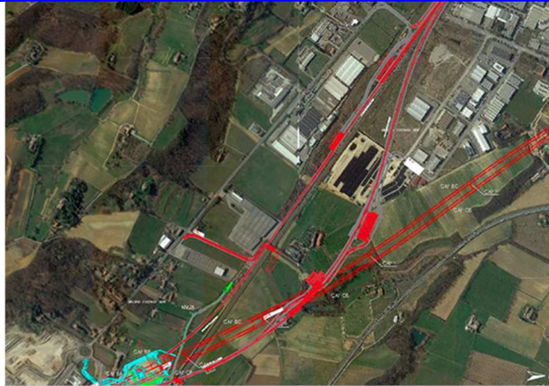
Cantiere Pernigotti - Interconnessione di Novi Ligure
