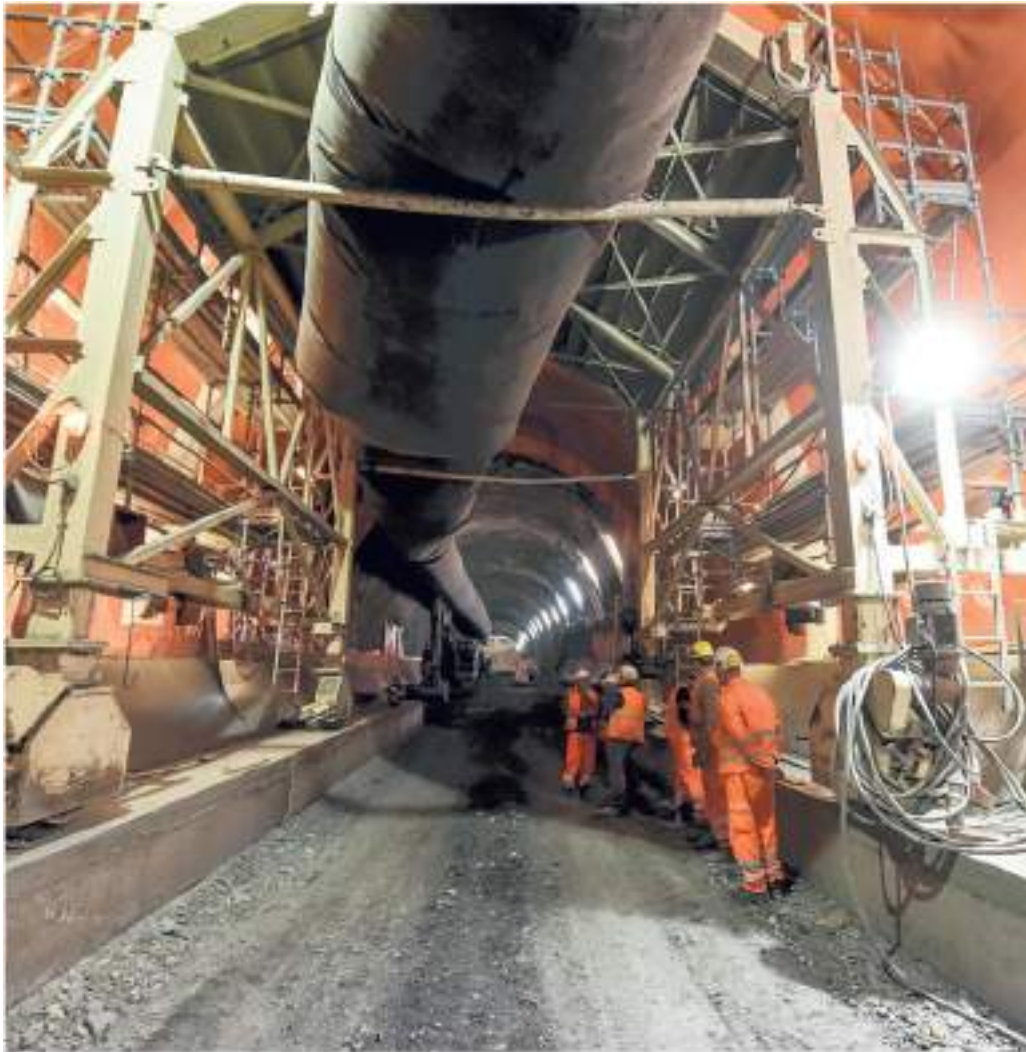
Un sopralluogo al cantiere del Terzo Valico a Trasta
