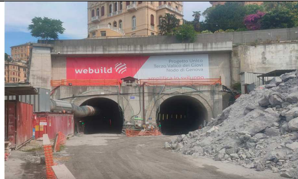
Imbocco Gallerie Nuova Colombo e Nuova San Tomaso(*)
