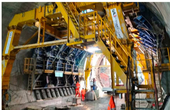
Cantiere Novi Ligure – Gallerie Serravalle
