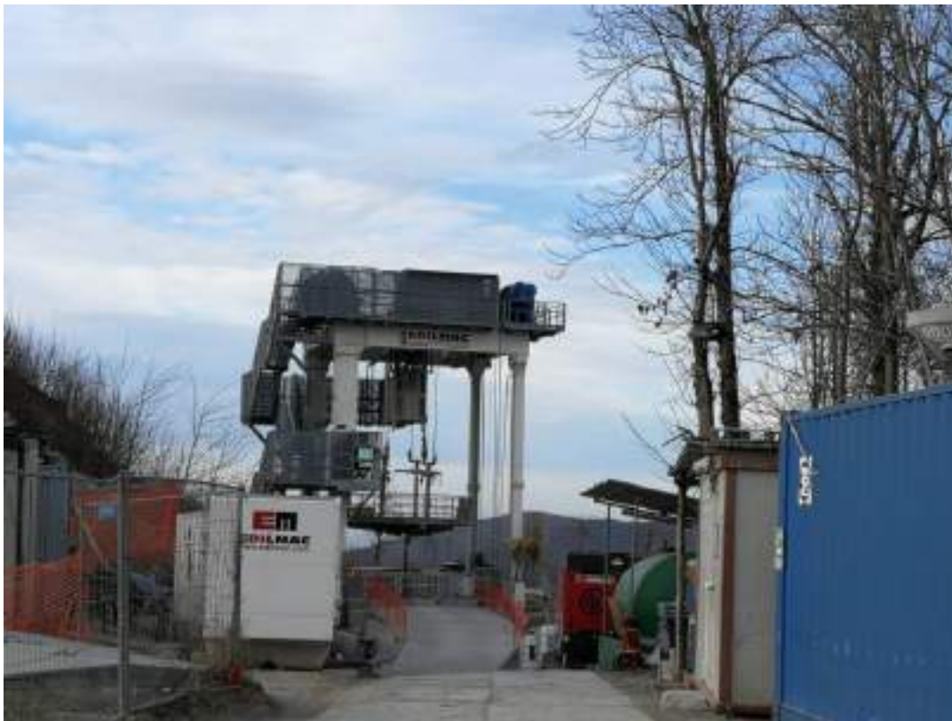
Il pozzo di aerazione del cantiere Val Lemme del Terzo valico
