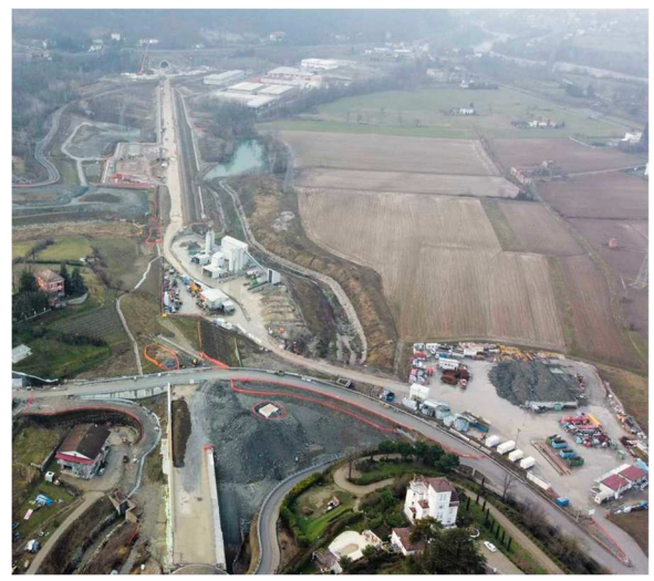
Cantiere Operativo Libarna
