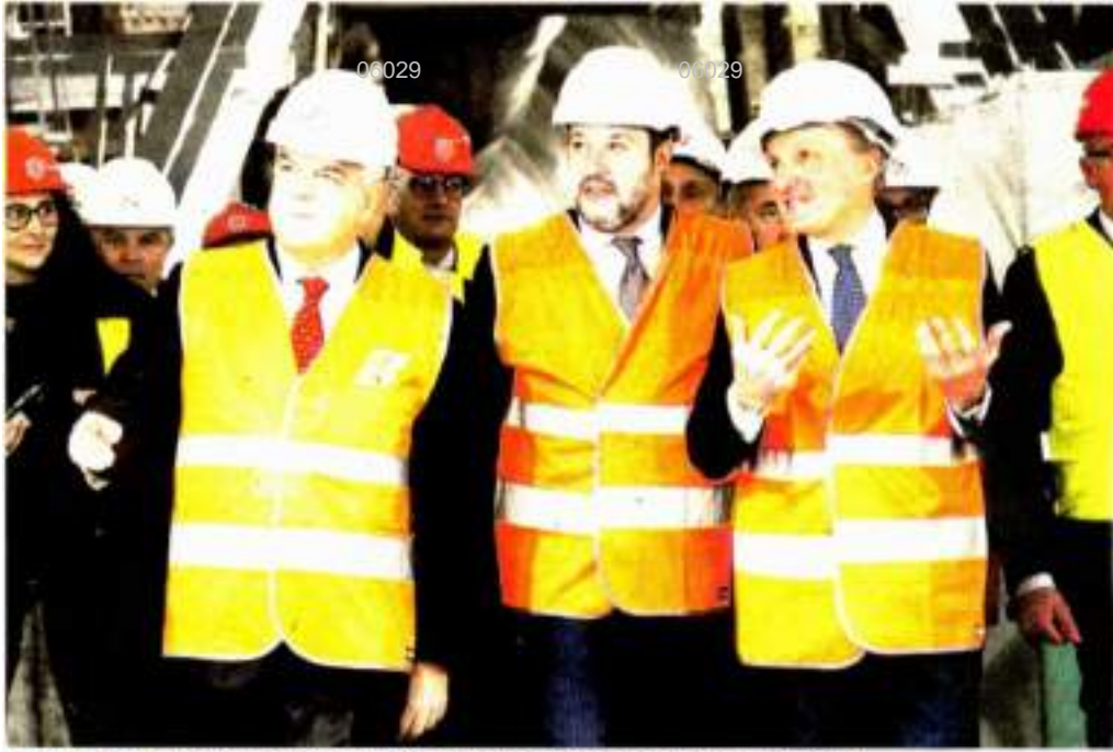
NEL TUNNEL Ferraris, Salvini e Mauceri in visita ai cantieri del Terzo Valico
