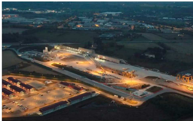
COP 07 - Cantiere Operativo Novi Ligure
