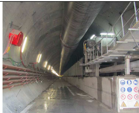
Cantiere di Pozzo Cascina Radimero
