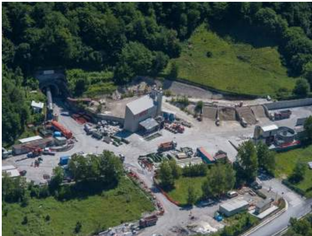
Il cantiere Vallemme a Voltaggio
