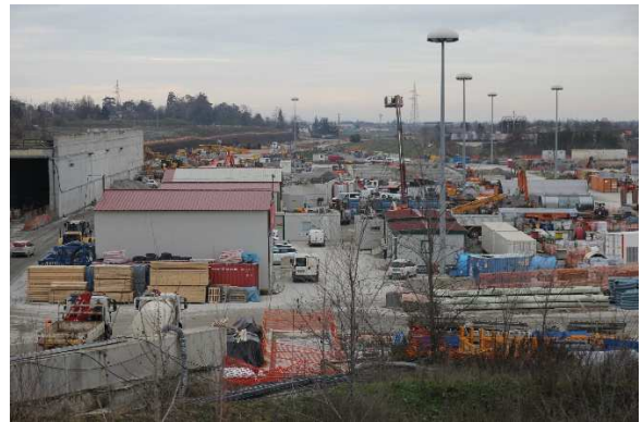
COP 07 - Cantiere Operativo Novi Ligure
