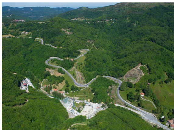
Nuova viabilità di accesso al cantiere Castagnola
