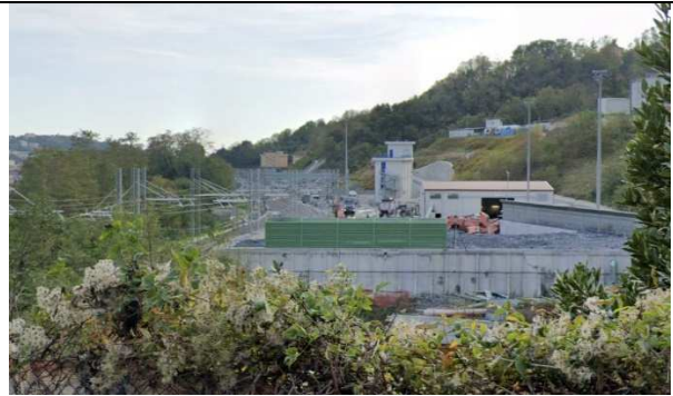
Fegino - Cantiere Trasta
