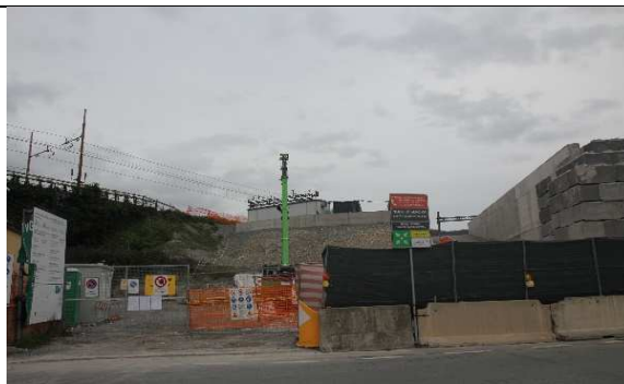
Fegino-Cantiere bivio Polcevera
