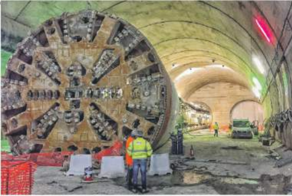
TBM Le talpe meccaniche sono ferme perché non riescono a consolidare la volta di scavo
