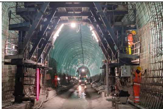
Galleria Nuova San Tomaso Attività di realizzazione armatura Calotta(*)
