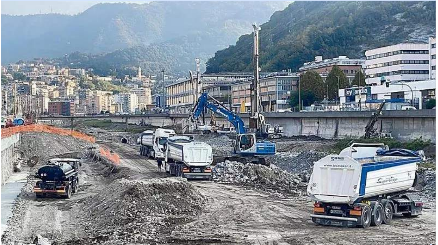
Il cantiere dello scolmatore del Bisagno
