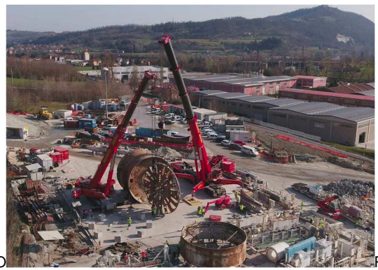
COP 07 - Cantiere Operativo Novi Ligure
