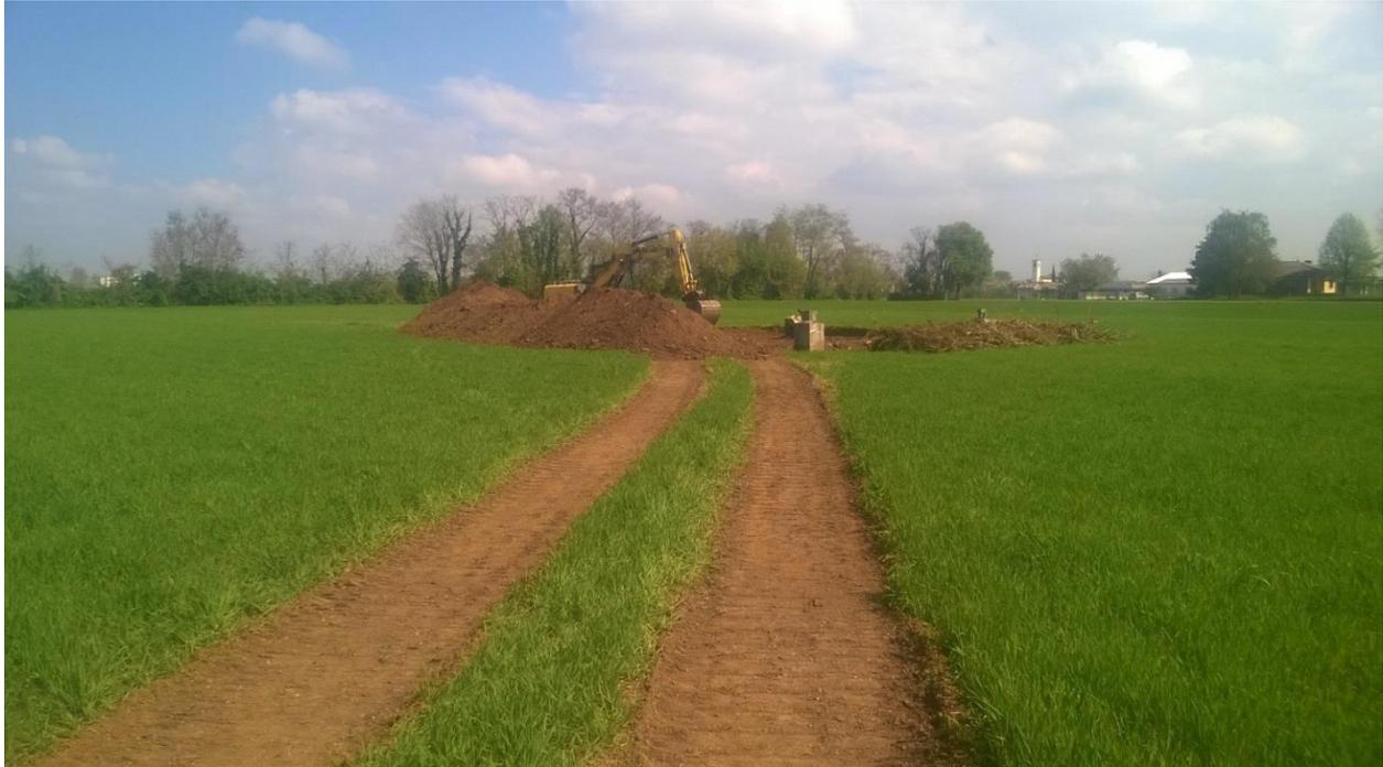
*Figura 05 - Esempio di pista temporanea su terreno agricolo*
