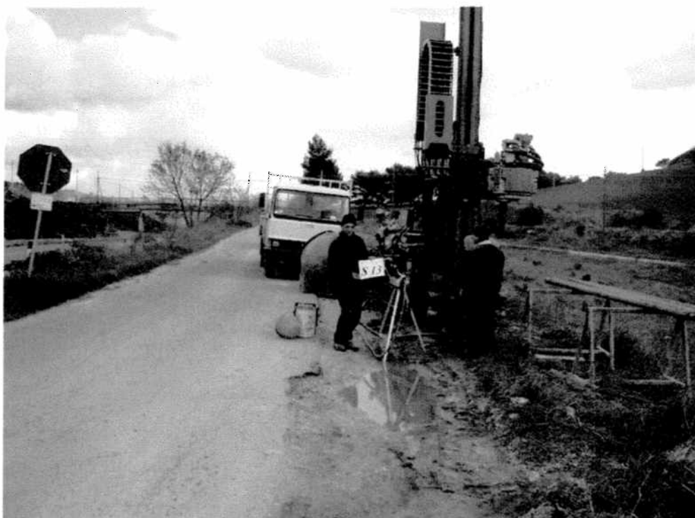
Postazione sondaggio meccanico S13
