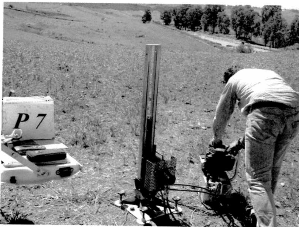
Postazione prova penetrometrica CPT7
