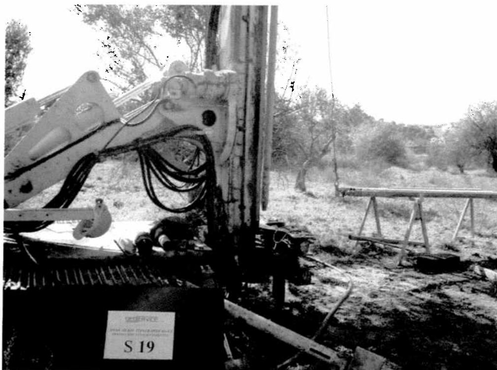
Postazione sondaggio meccanico S19
