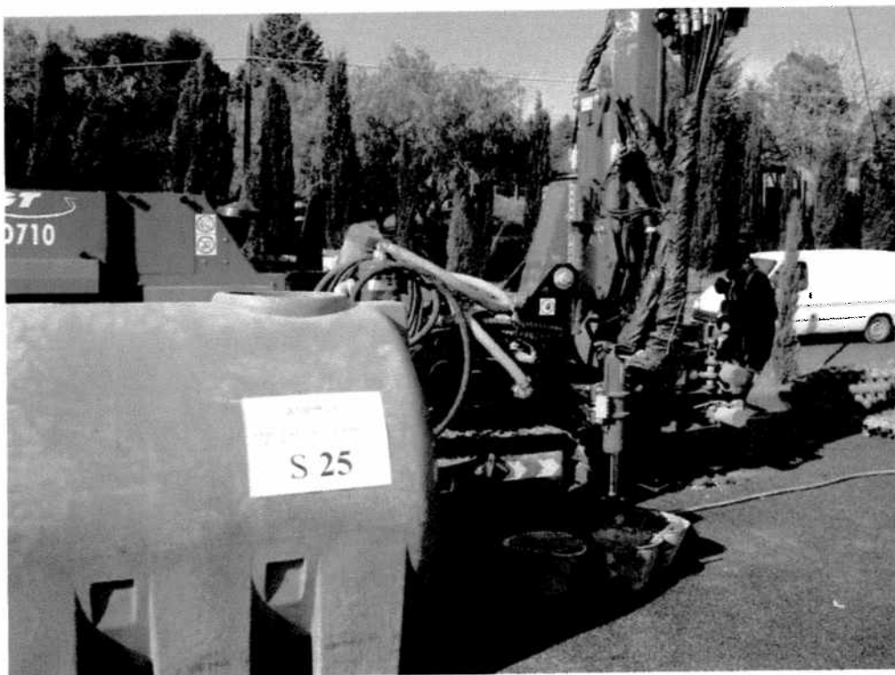
Postazione sondaggio meccanico S25
