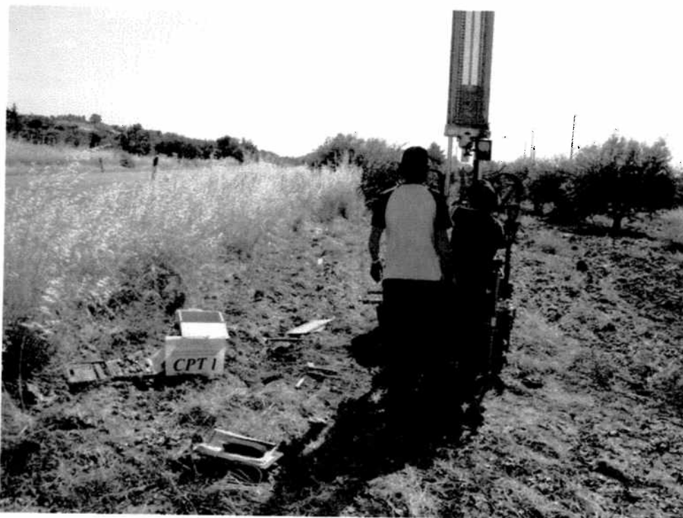
Postazione prova penetrometrica CPT1
