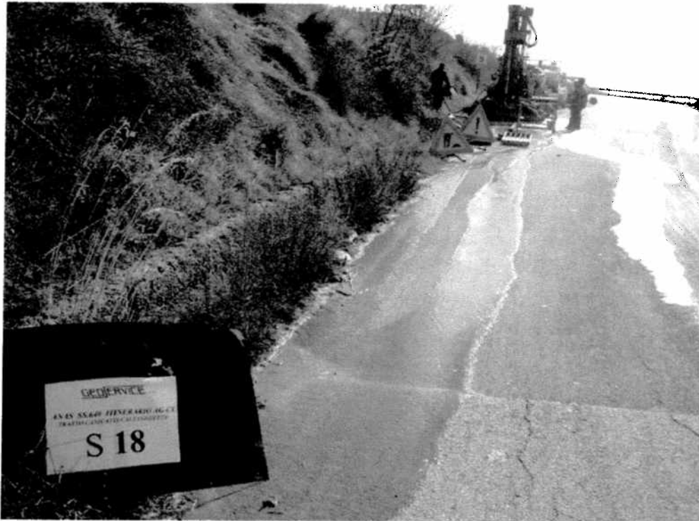
Postazione sondaggio meccanico S18
