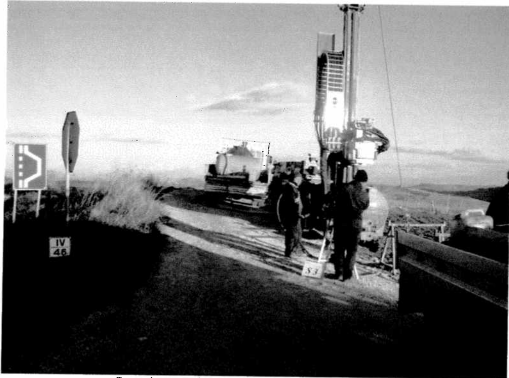
Postazione sondaggio meccanico S3 (km 46+IV)
