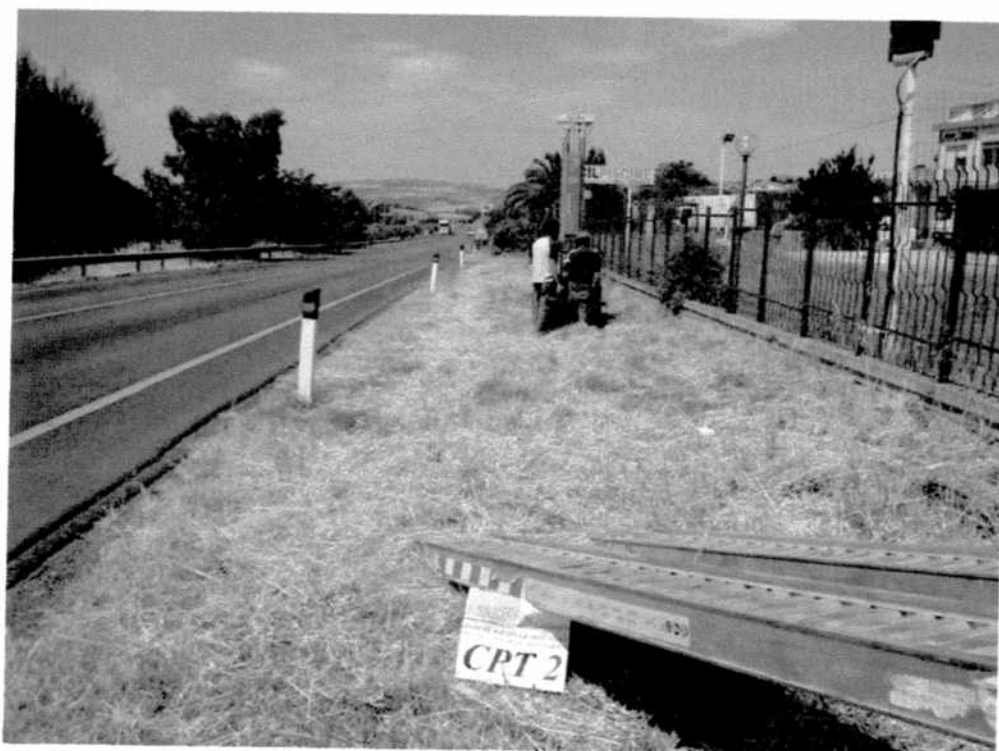
Postazione prova penetrometrica CPT2
