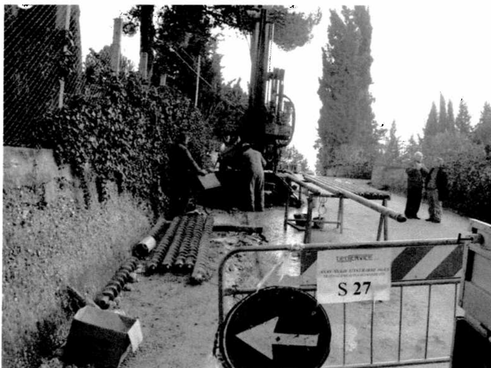
Postazione sondaggio meccanico S27
