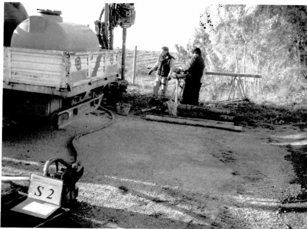
Postazione sondaggio meccanico S2 (km 45+VI)
