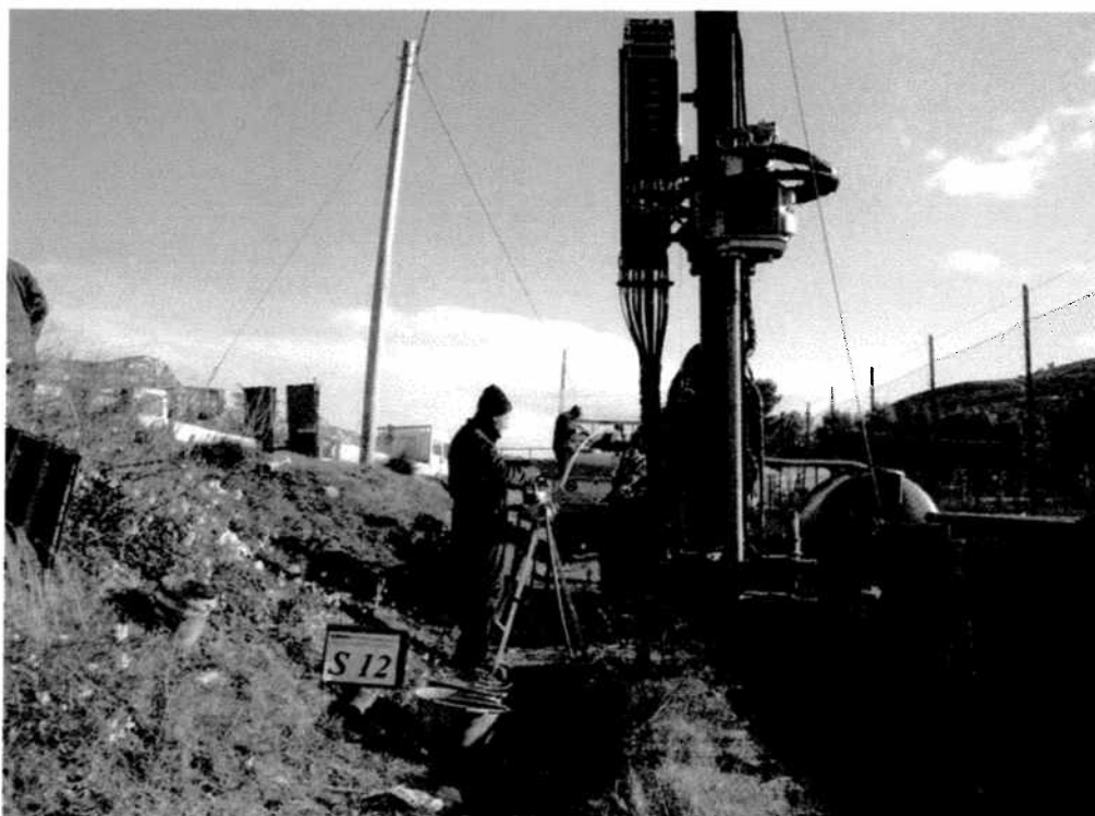
Postazione sondaggio meccanico S12
