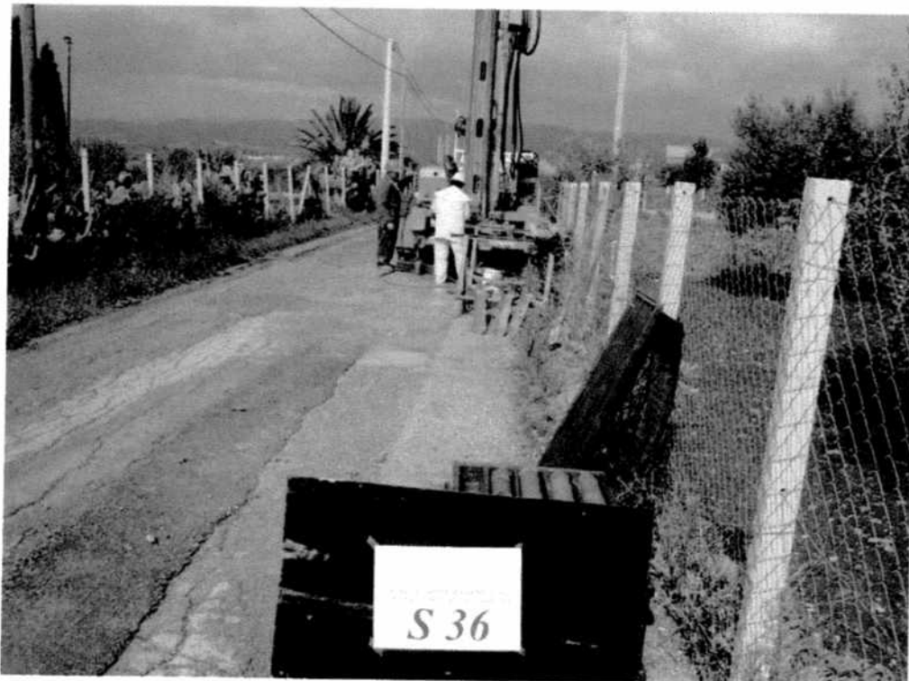
Postazione sondaggio meccanico S36
