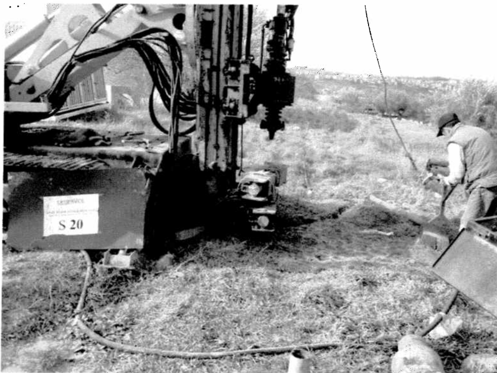
Postazione sondaggio meccanico S20
