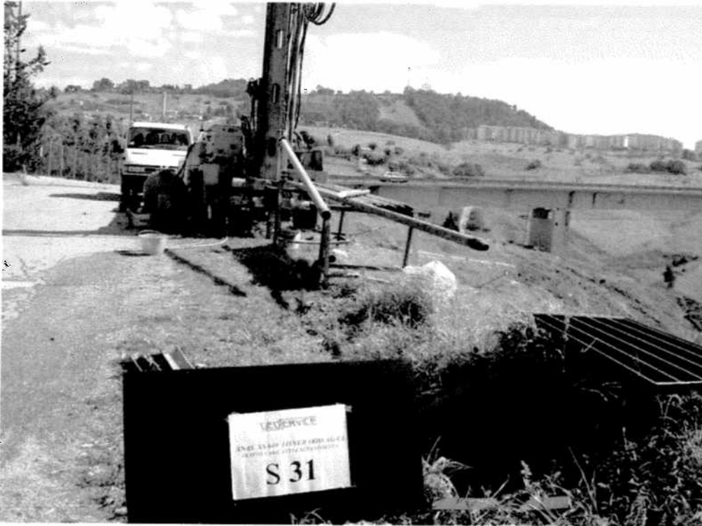
Postazione sondaggio meccanico S31
