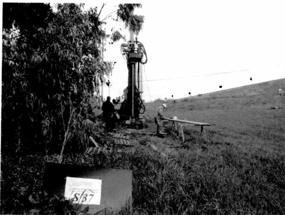
Postazione sondaggio meccanico S37
