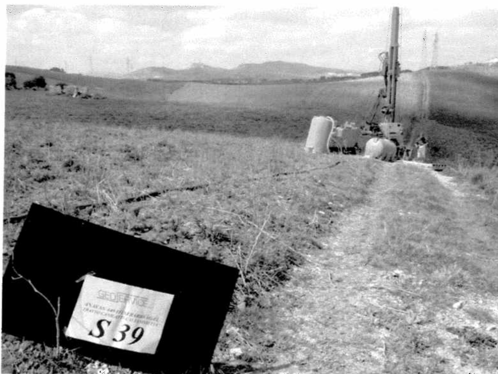
Postazione sondaggio meccanico S39
