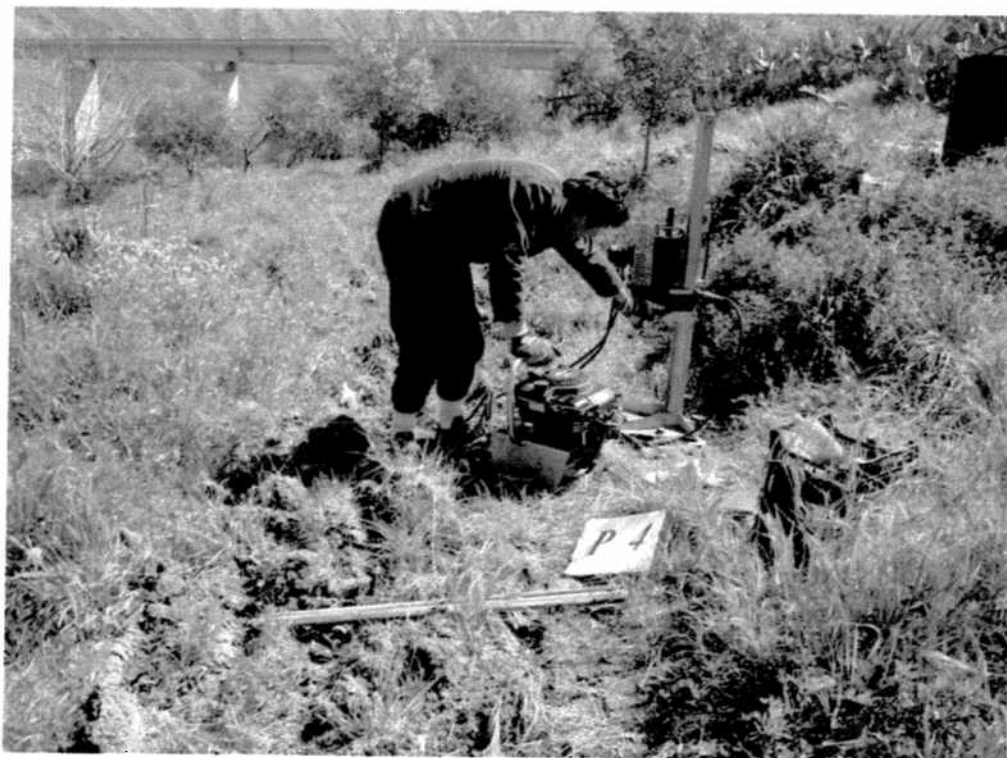
Postazione prova penetrometrica CPT4
