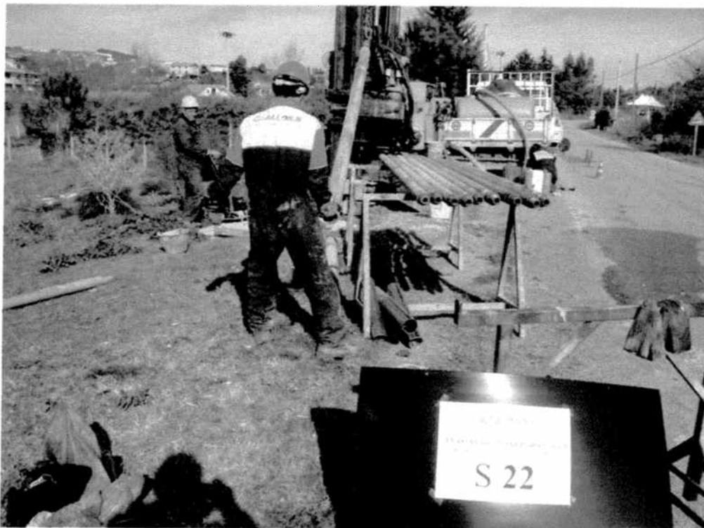
Postazione sondaggio meccanico S22
