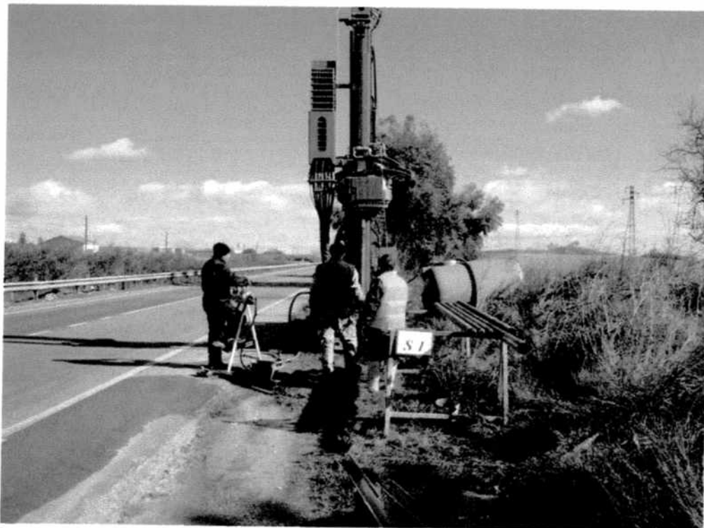
Postazione sondaggio meccanico S1 (km 45+11)
