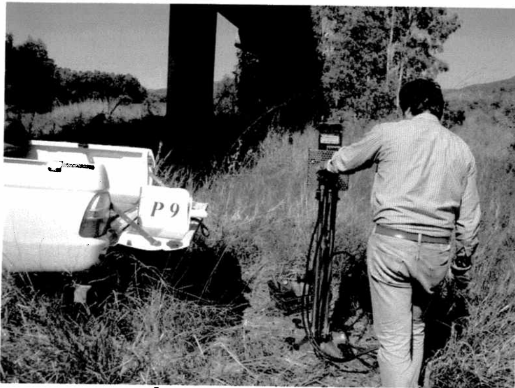
Postazione prova penetrometrica CPT9
