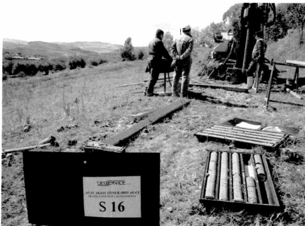
Postazione sondaggio meccanico S16
