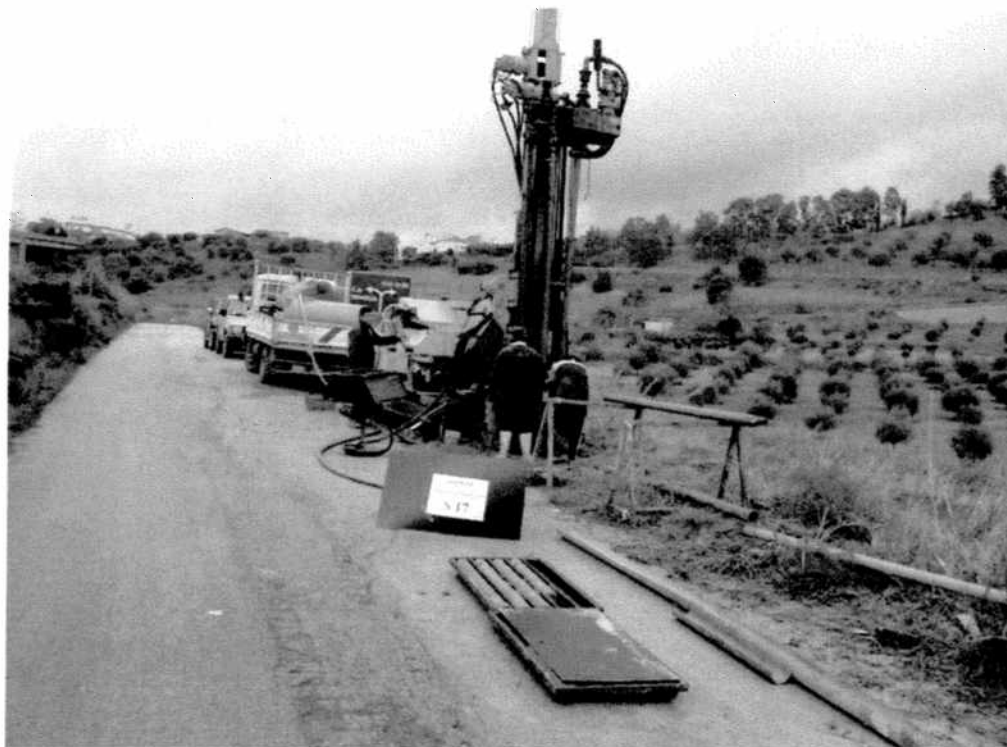
Postazione sondaggio meccanico S17
