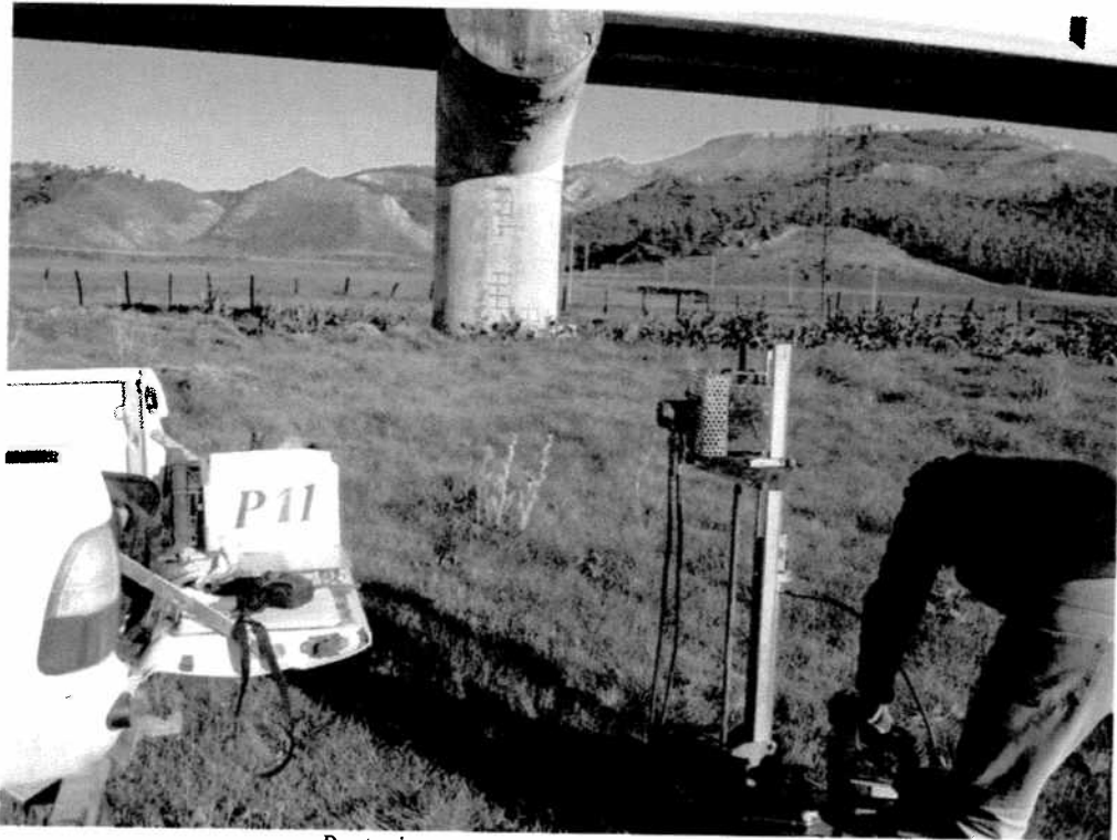
Postazione prova penetrometrica CPT11
