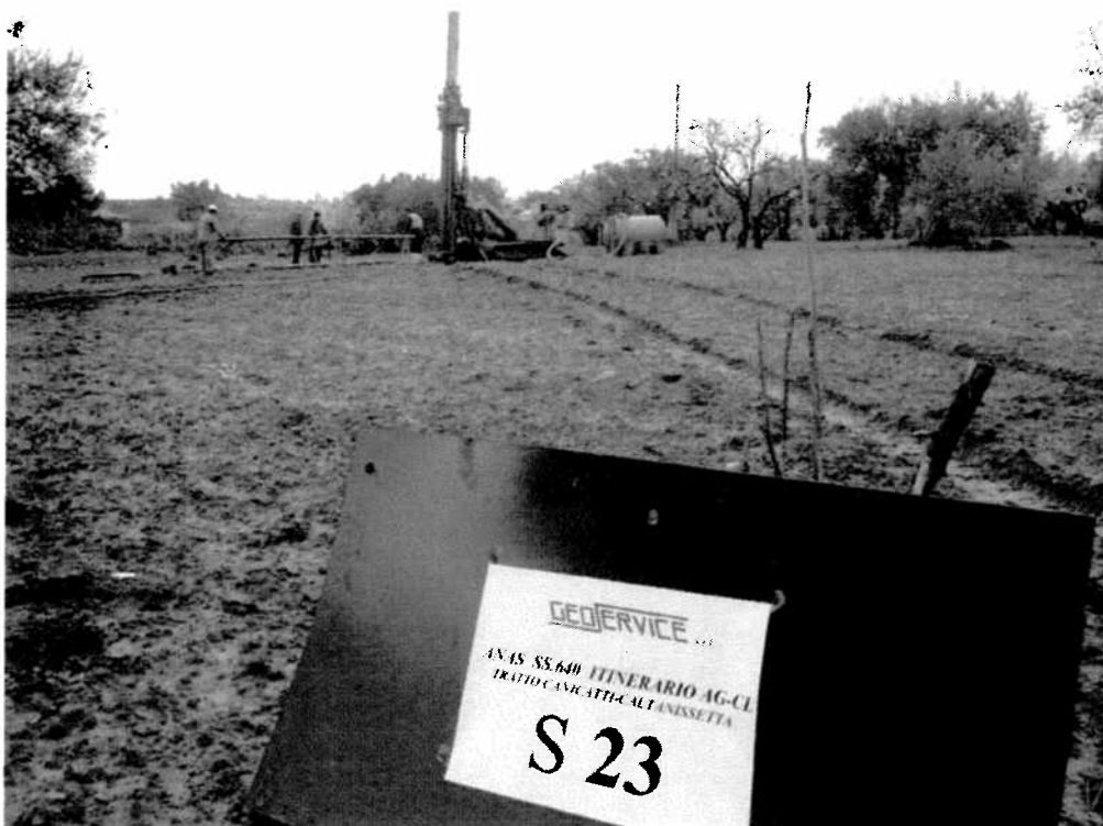
Postazione sondaggio meccanico S23
