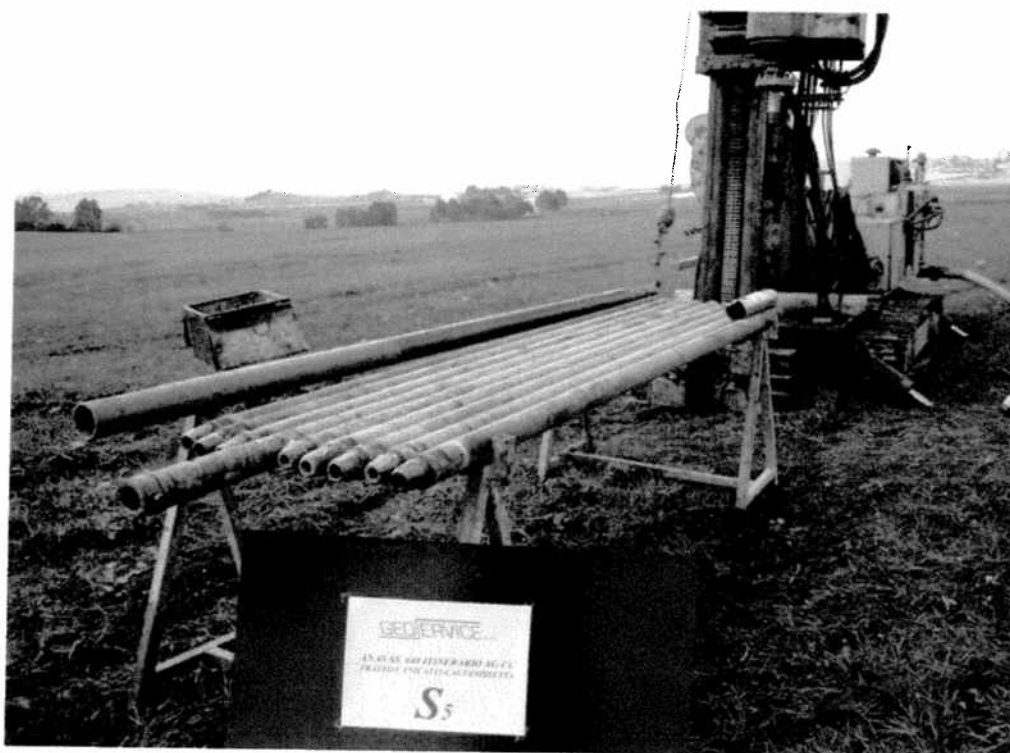
Postazione sondaggio meccanico S5
