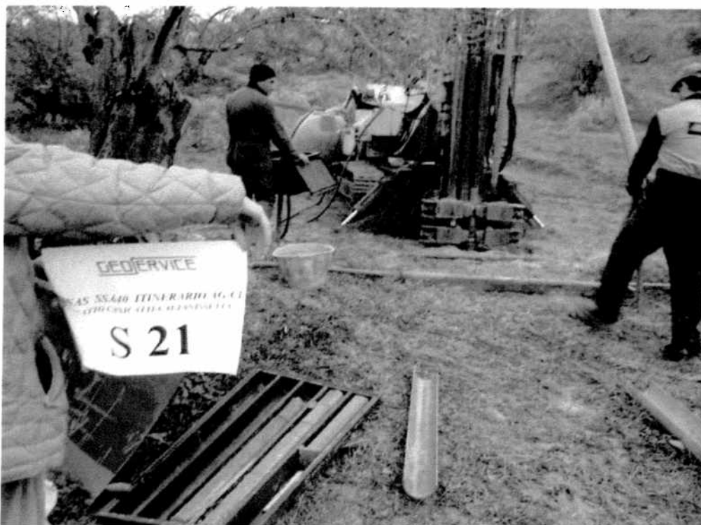
Postazione sondaggio meccanico S21
