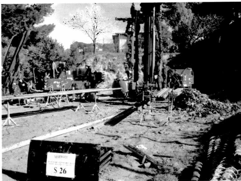
Postazione sondaggio meccanico S26
