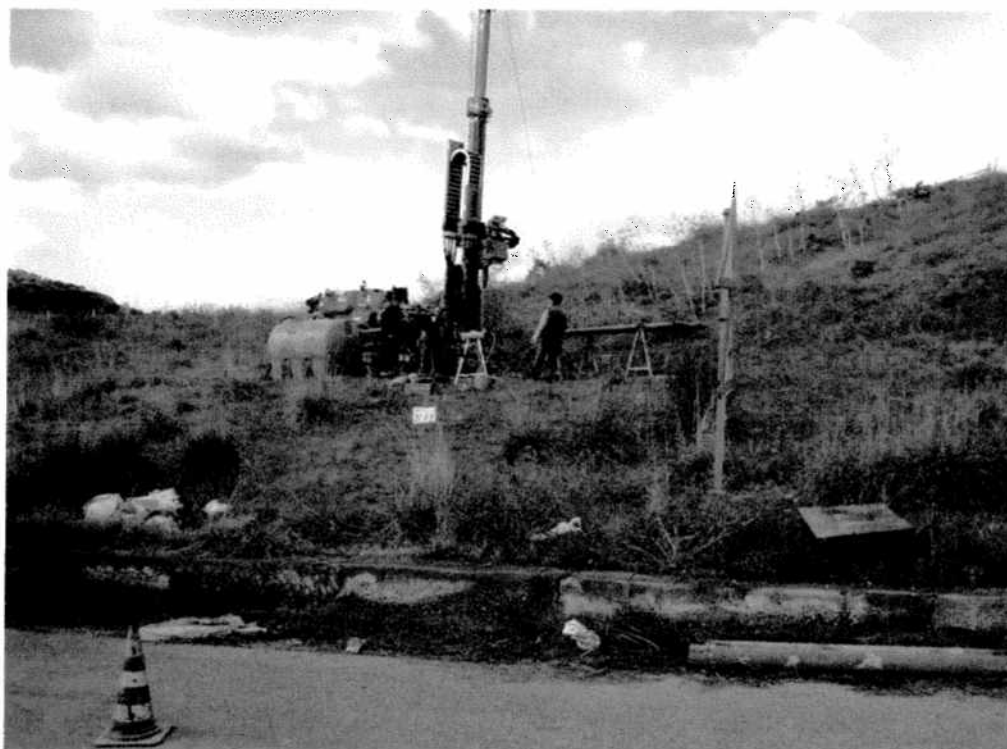
Postazione sondaggio meccanico S15
