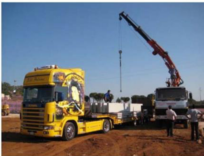
Figura 12 | Attività di scarico cabina di campo
