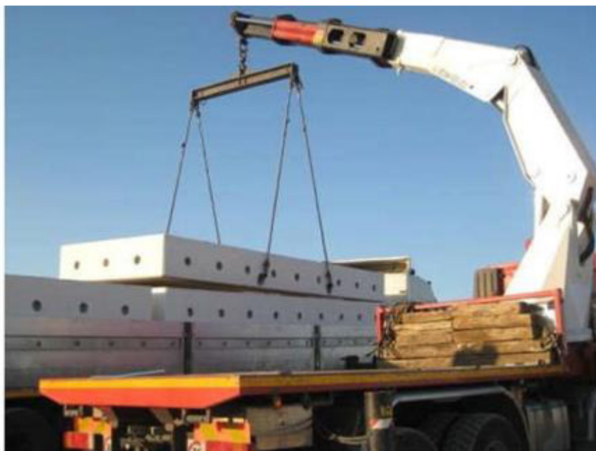
Figura 13 | Scarico cabina trasformazione
