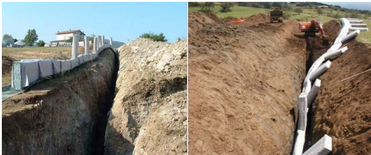
Figura 2 Fasi di lavorazione durante la posa - Avanzamento dello scavo durante la posa
