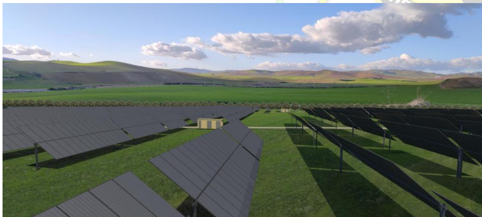
Figura 2 - Inserimento impianto fotovoltaico
