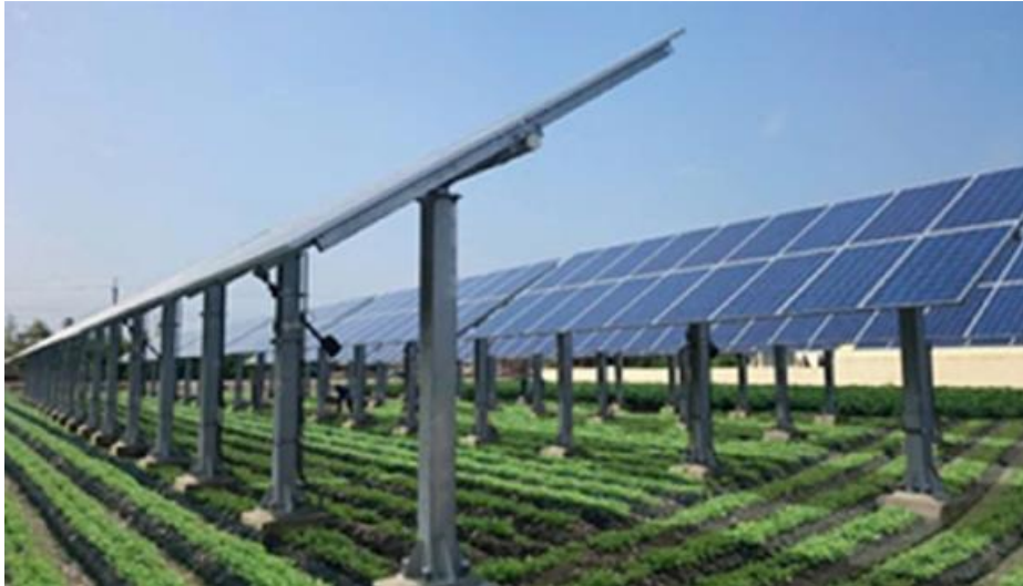
Figura 17 | Esempio impianto agrivoltaico
