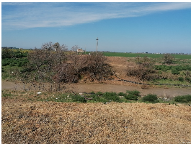
Canale Cervaro Nuovo
