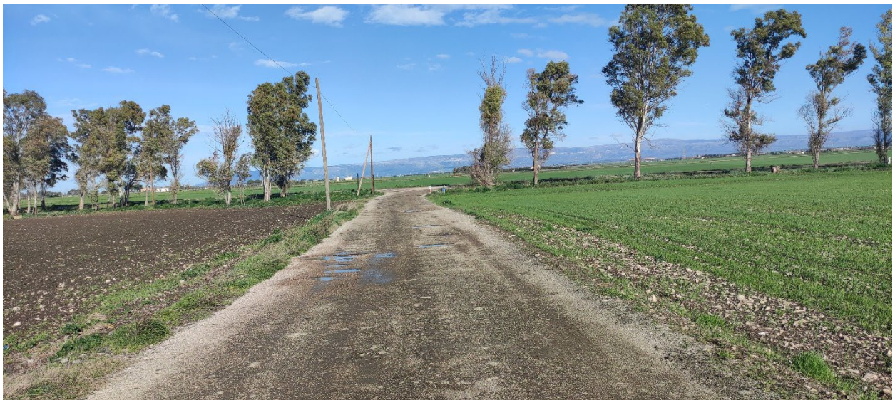
Viabilità in conglomerato bituminoso esistente
