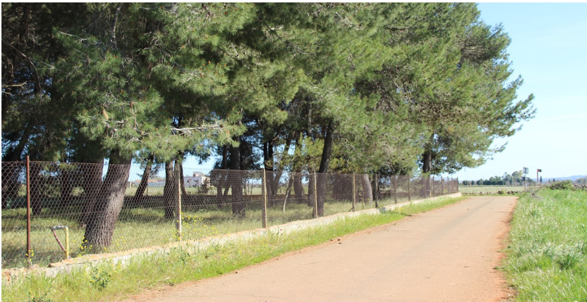
Figura 11 – viabilità esistente interessata dal passaggio del cavidotto MT - foto scattata in corrispondenza della particella 44 del foglio 60
