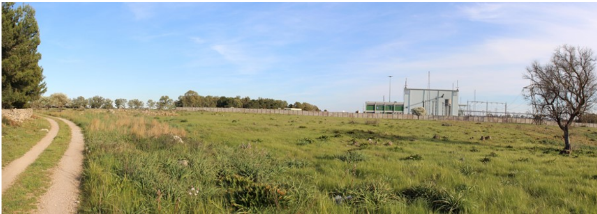
Figura 10 - vista dell’area di impianto (campo 8) dallo spigolo nord ovest
