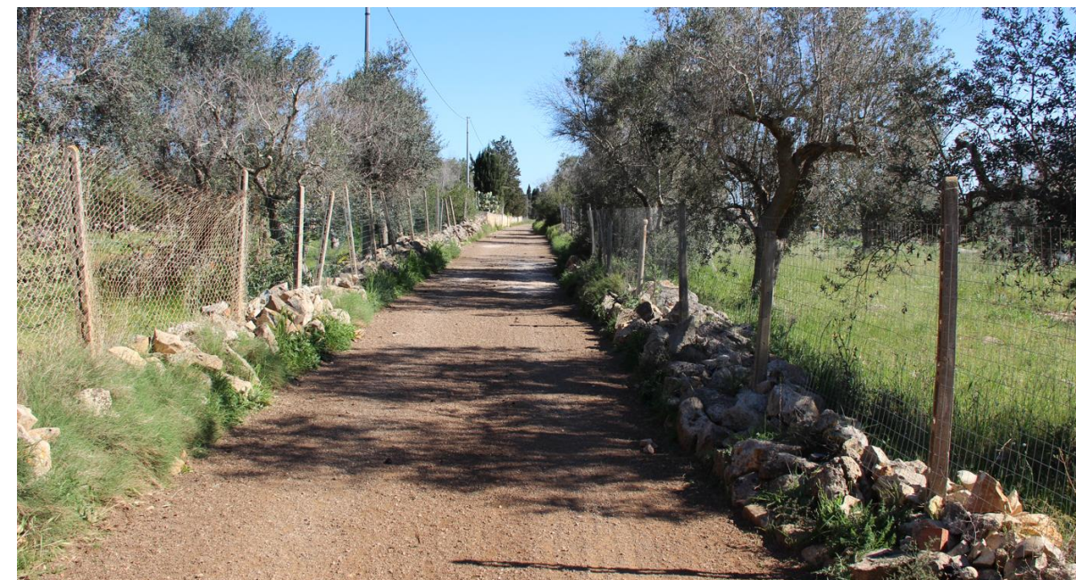
Figura 11 - strada vicinale Malevodi interessata dal passaggio del cavidotto MT - foto scattata in corrispondenza della particella 264 del foglio 34
