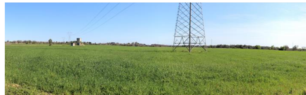
Figura 12 - vista dell'area di ubicazione della futura stazione Terna "Galatina" RTN 380/150 Kv
