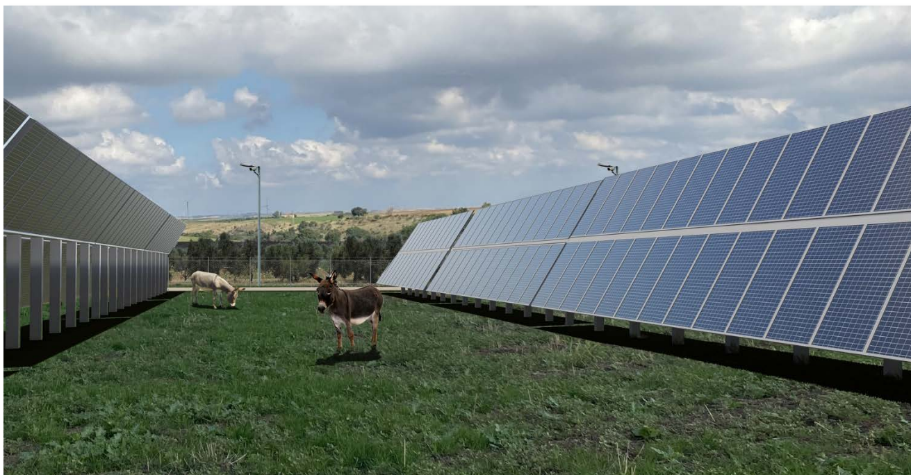
Fotoinserimento vista interna impianto
