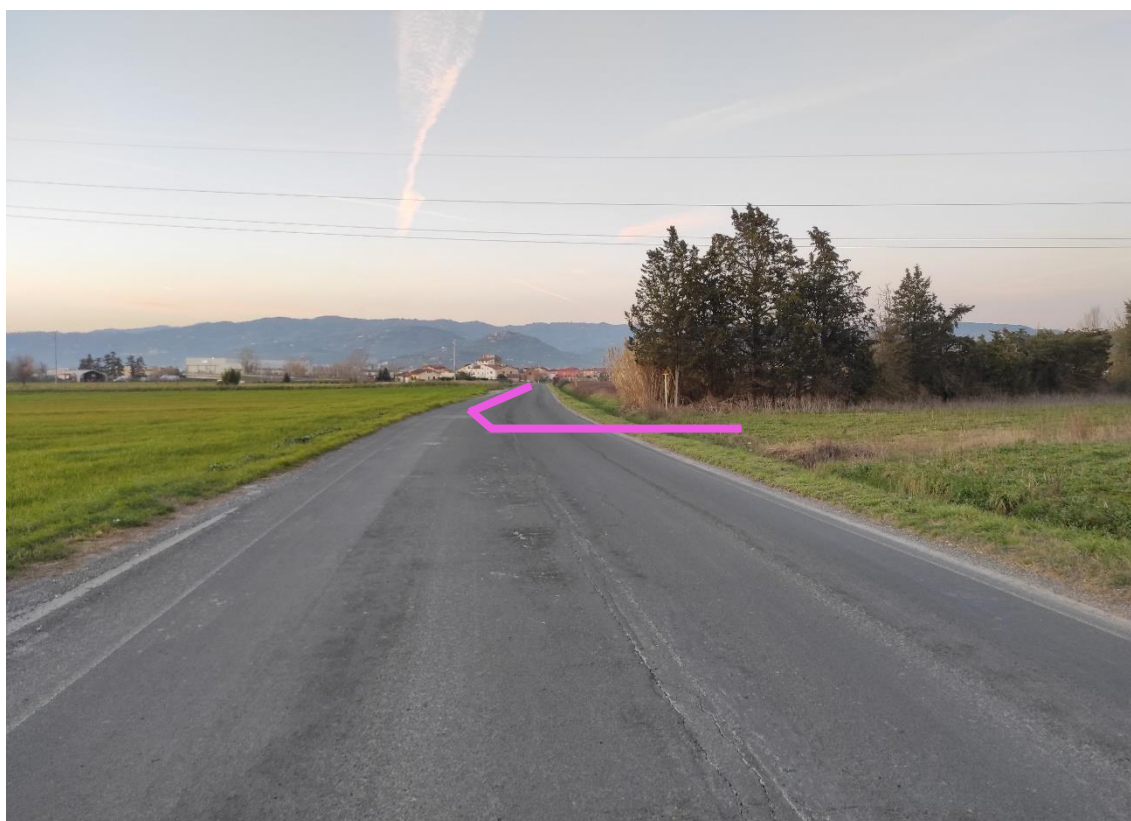
Figura 18. Via del Fossetto – Posa linea elettrica su strada asfaltata e interferenza n.1
