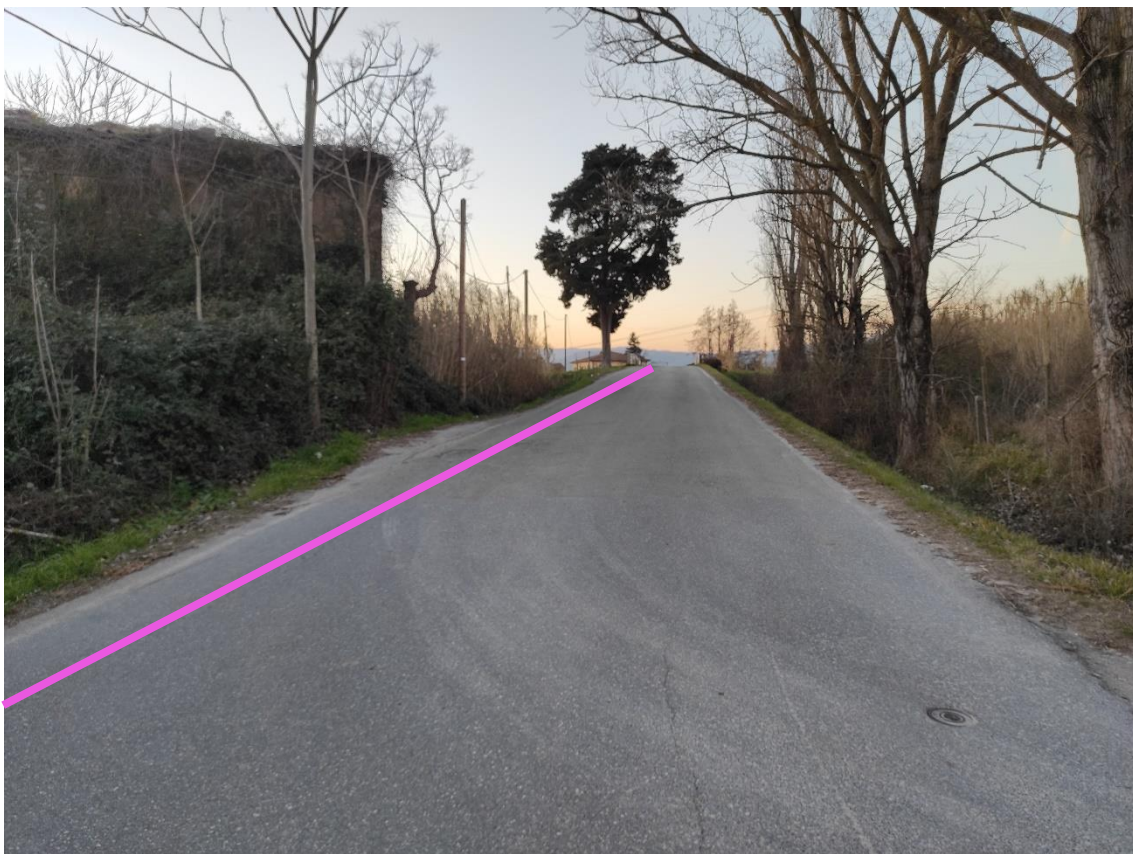
Figura 10. Via del Fossetto – Posa linea elettrica su strada asfaltata
