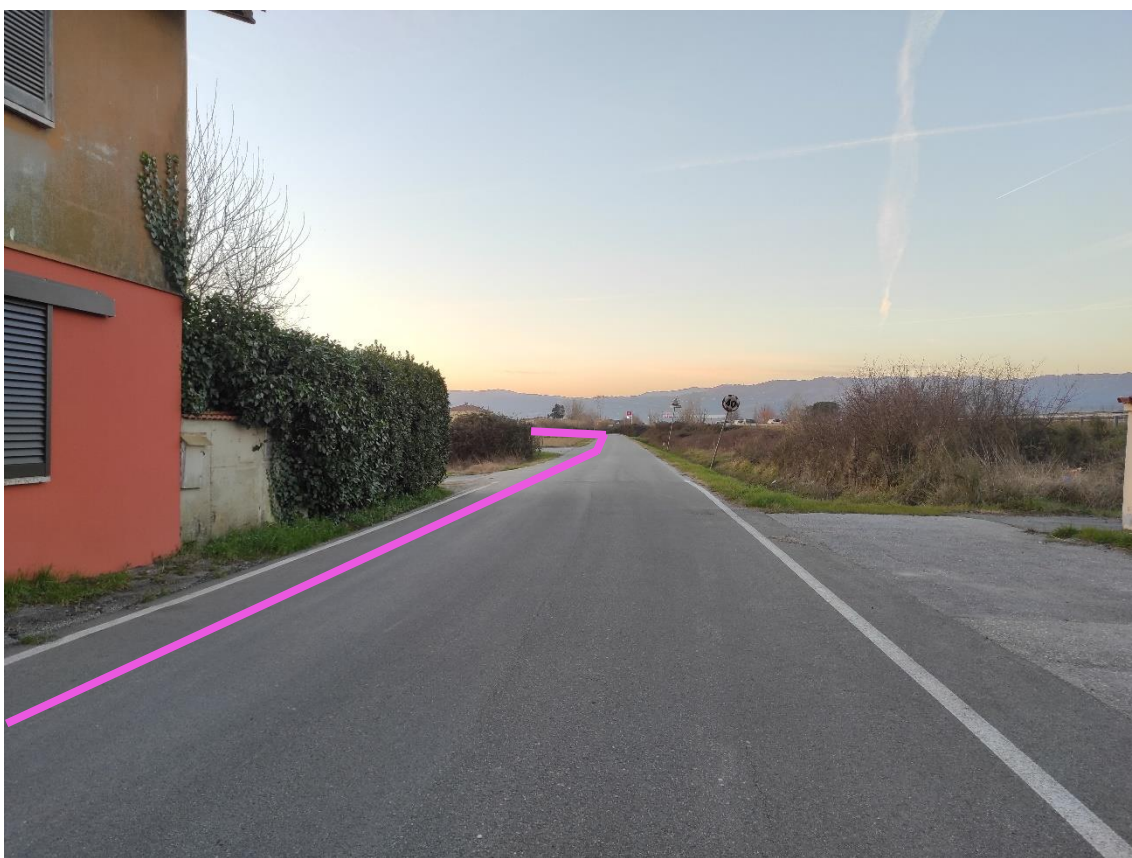
Figura 7. Via del Fossetto – Posa linea elettrica su strada asfaltata
