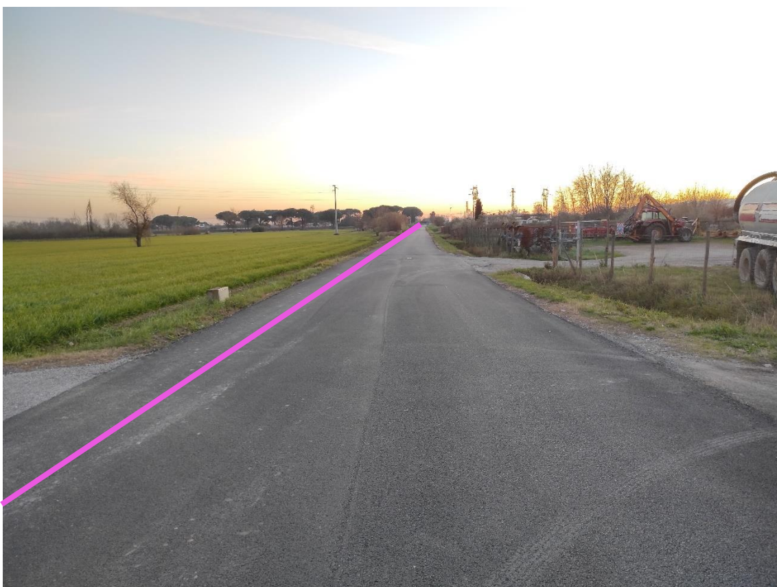
Figura 24. Via delle Colmate – Posa linea elettrica su strada asfaltata
