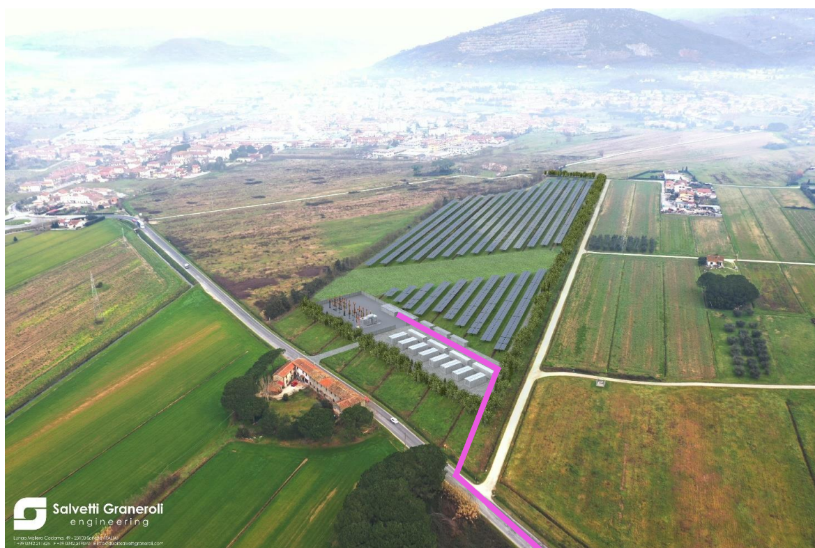
Figura 16. Ingresso linea MT nella sottostazione elettrica
