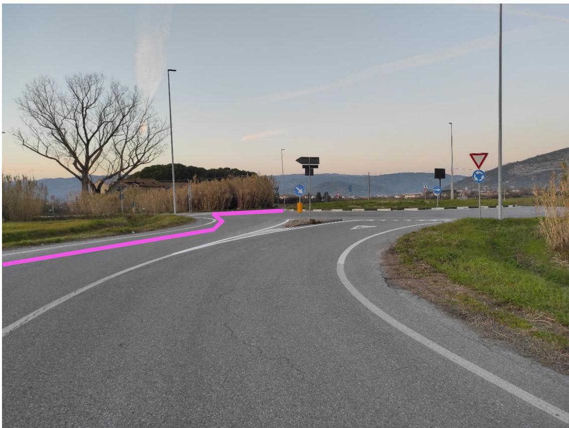
Figura 14. Rotonda SR.436/Via del Fossetto – Posa linea elettrica su strada asfaltata
