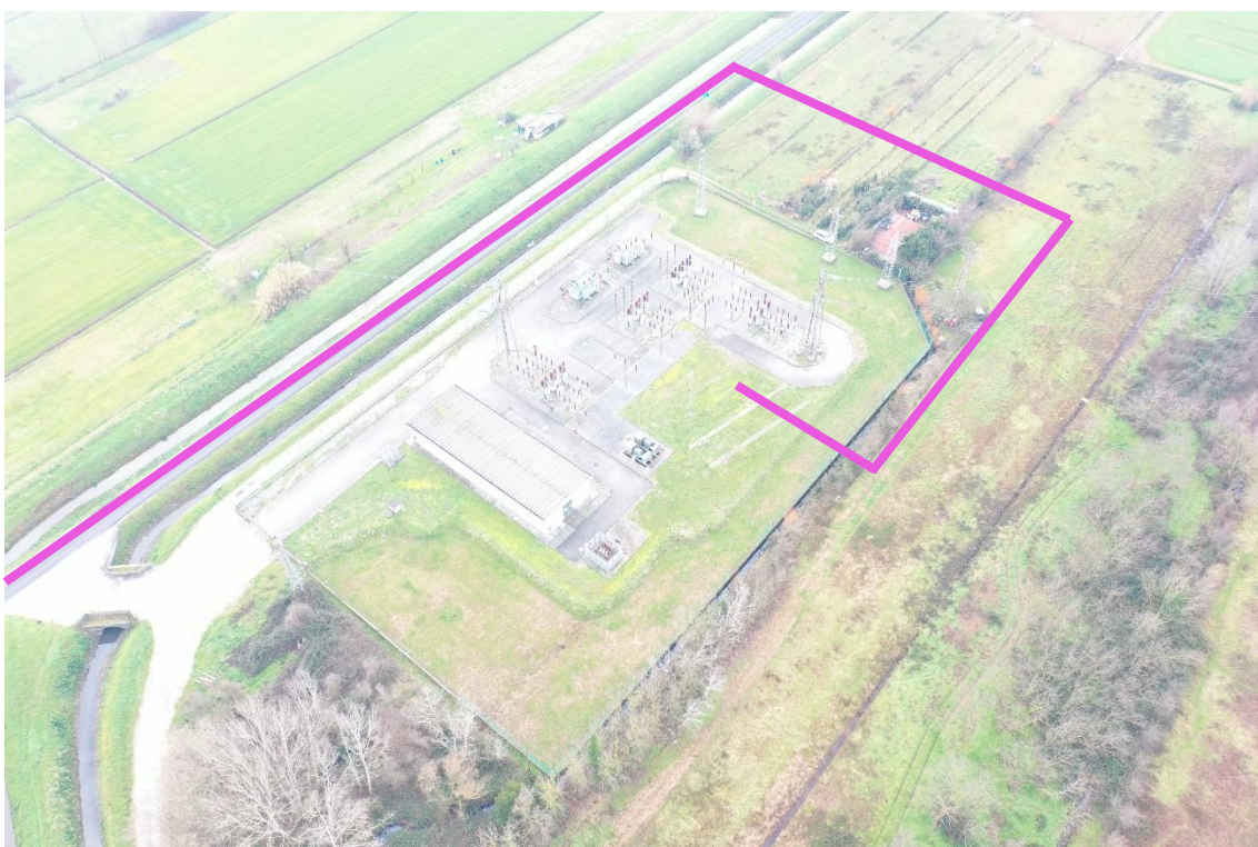
Figura 26. Via delle Colmate/cabina primaria – Posa linea elettrica su strada asfaltata/terreno
