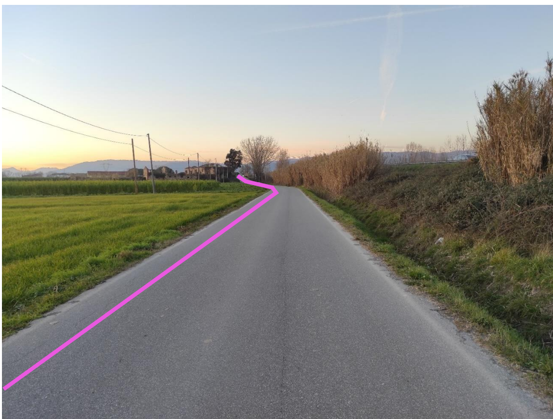
Figura 9. Via del Fossetto – Posa linea elettrica su strada asfaltata
