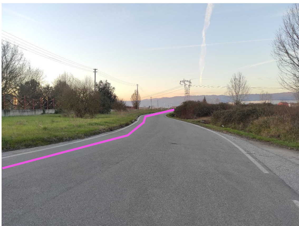
Figura 3. Via del Fossetto – Posa linea elettrica su strada asfaltata
