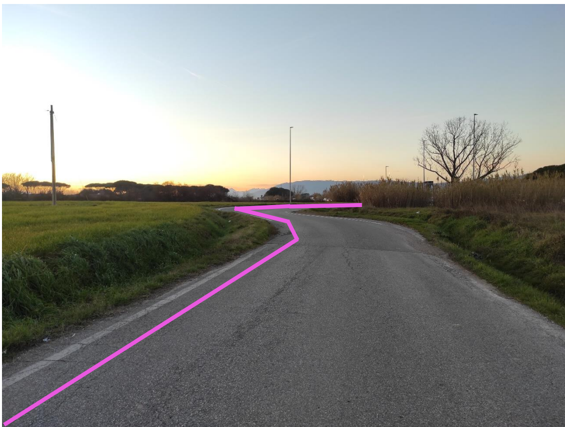
Figura 13. Via del Fossetto – Posa linea elettrica su strada asfaltata
