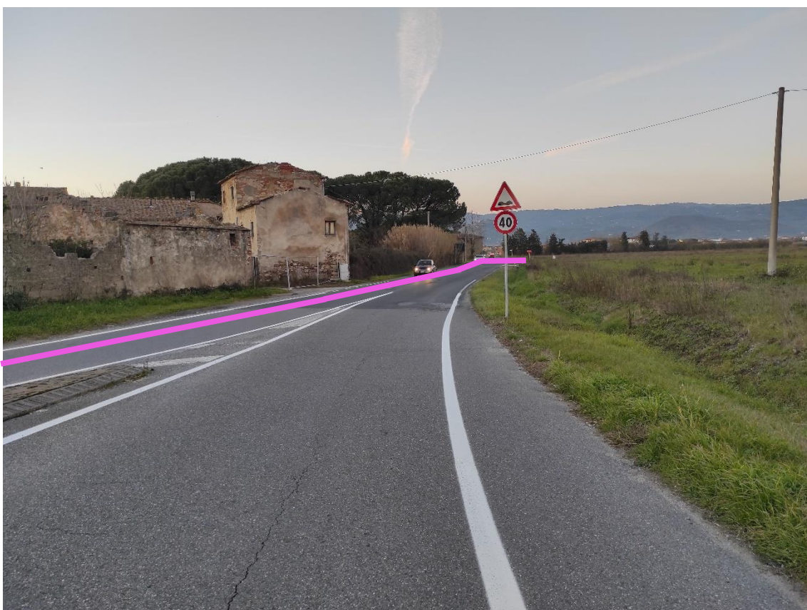
Figura 15. Via del Fossetto – Posa linea elettrica su strada asfaltata
