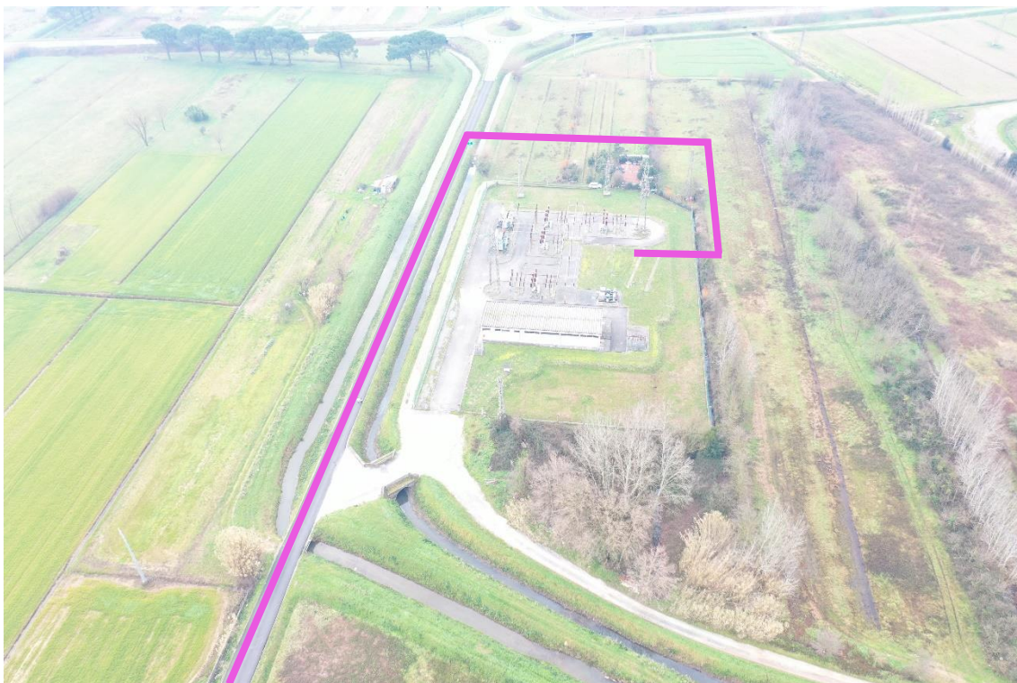
Figura 27. Via delle Colmate/cabina primaria – Posa linea elettrica su strada asfaltata/terreno
