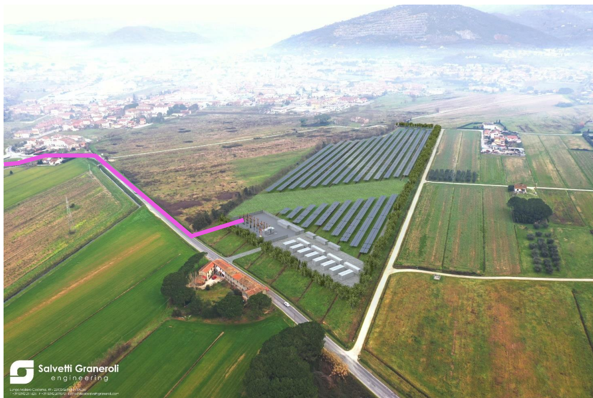
Figura 17. Uscita linea MT dalla sottostazione elettrica
