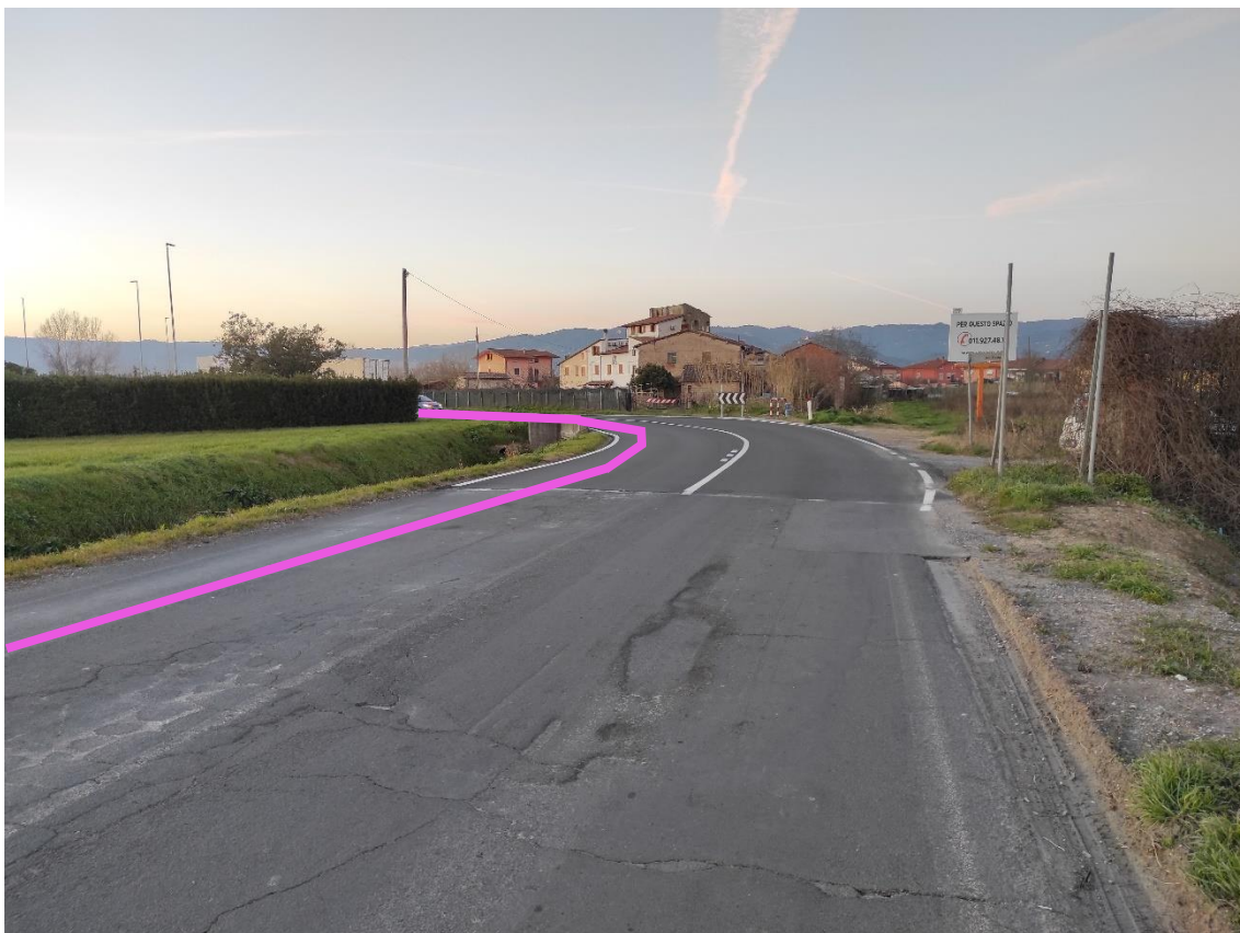
Figura 21. Via del Fossetto – Posa linea elettrica su strada asfaltata e interferenza n.3
