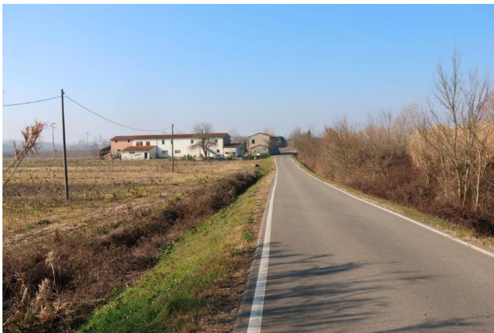
Figura 19 - Stato di fatto del sottocampo 1. Lato nord-est a confine con Via del Fossetto
