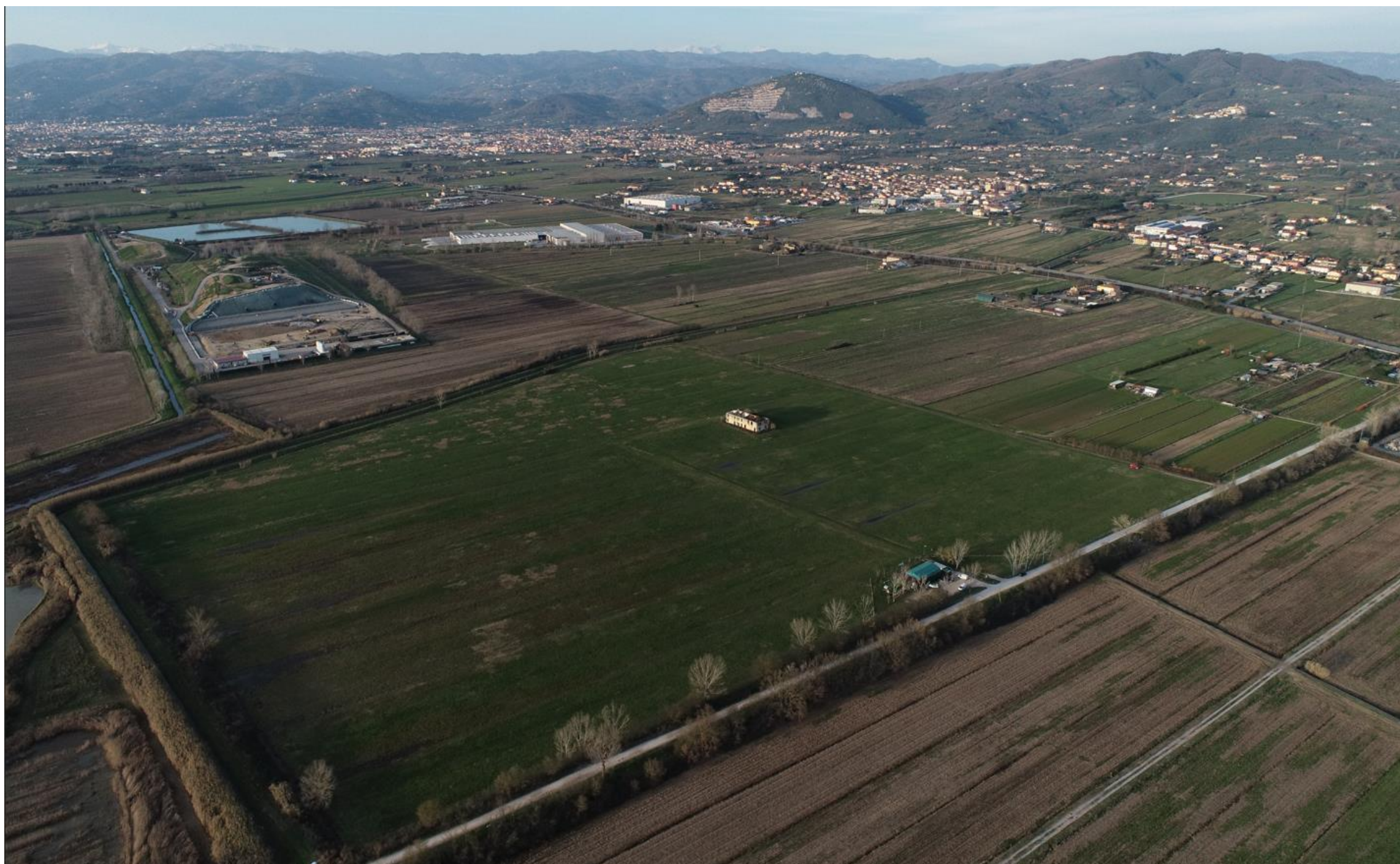
Figura 69 - Sottocampo 1 visto da drone. Stato di fatto
