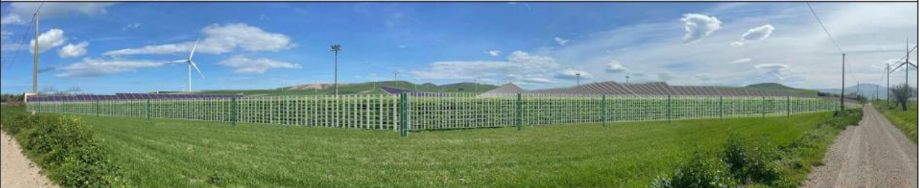
Punto di presa 8: Panoramica stato dei luoghi
