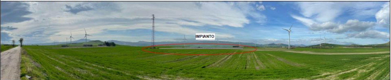
Punto di presa 4: Panoramica stato dei luoghi
