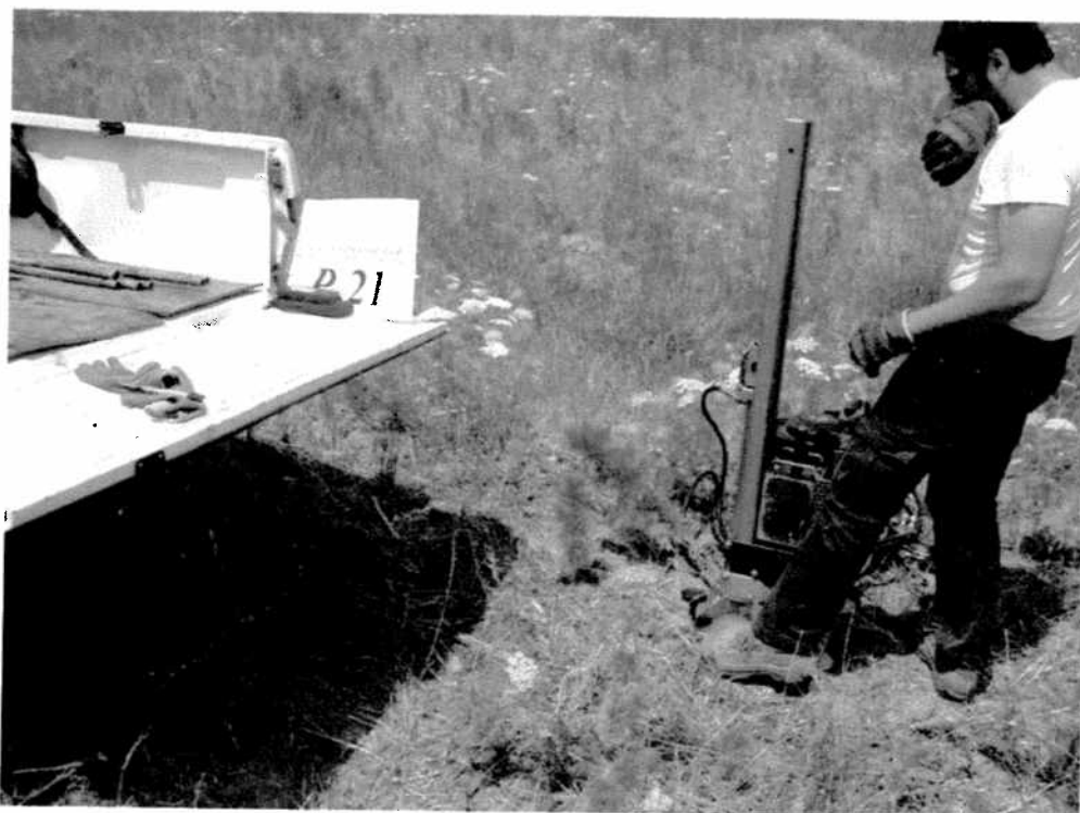
Postazione prova penetrometrica P21
