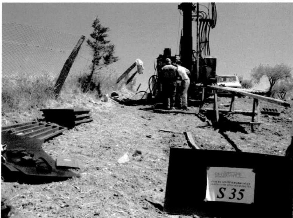
Postazione sondaggio meccanico S35
