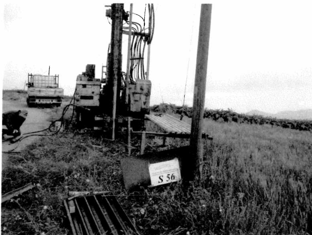
Postazione sondaggio meccanico S56
