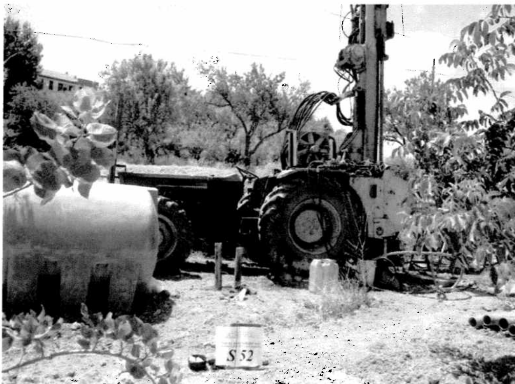
Postazione sondaggio meccanico S52
