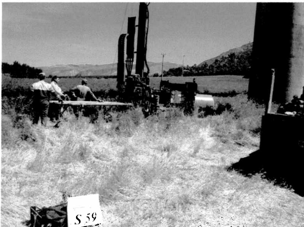
Postazione sondaggio meccanico S59
