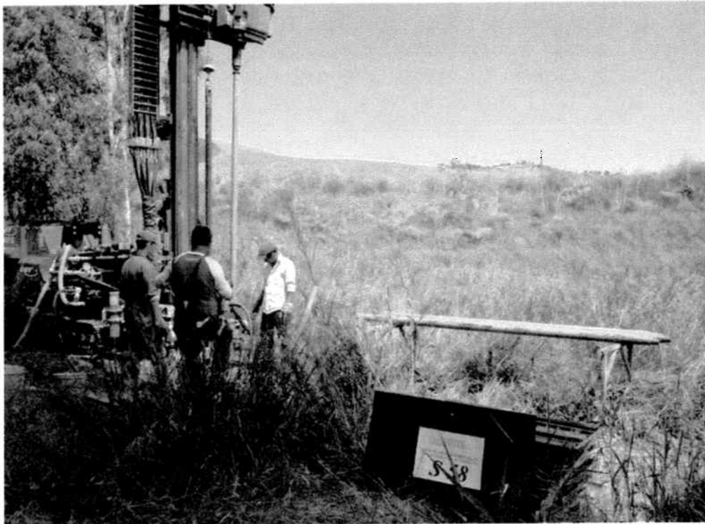
Postazione sondaggio meccanico S58
