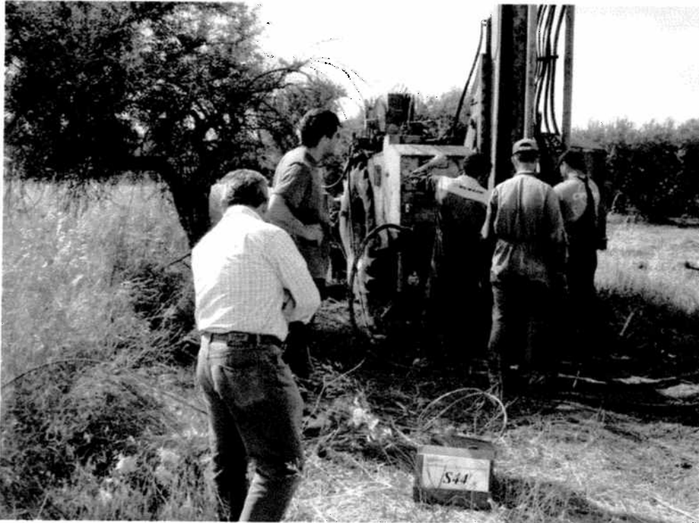
Postazione sondaggio meccanico S44
