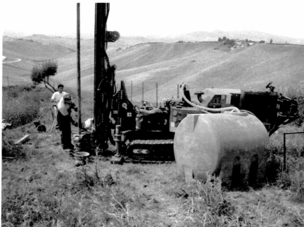
Postazione sondaggio meccanico S30
