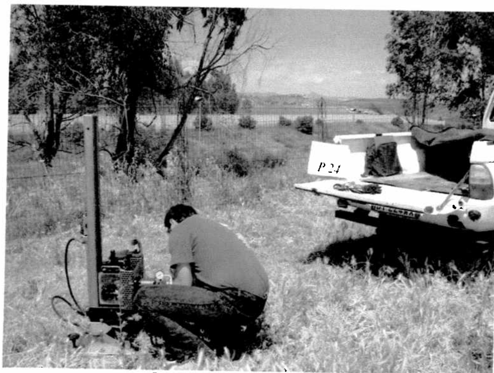
Postazione prova penetrometrica P24
