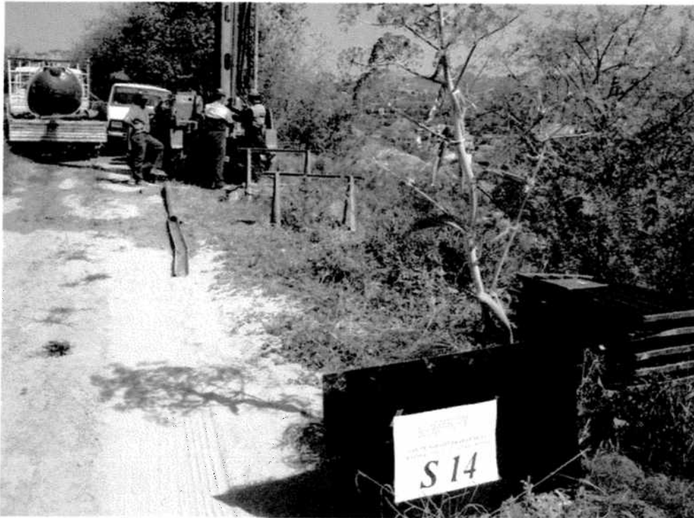
Postazione sondaggio meccanico S14
