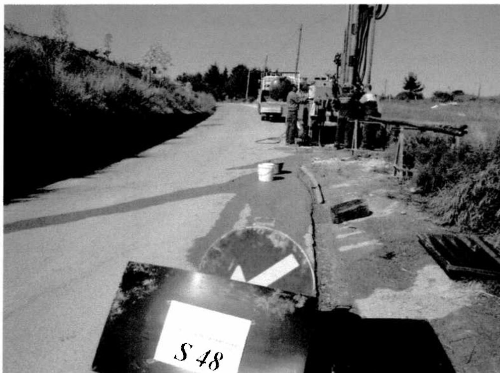
Postazione sondaggio meccanico S48
