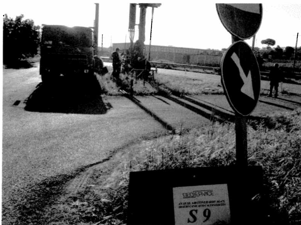
Postazione sondaggio meccanico S9
