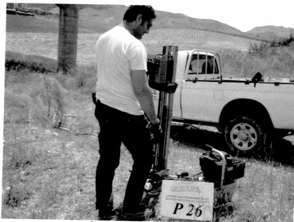
Postazione prova penetrometrica P26
