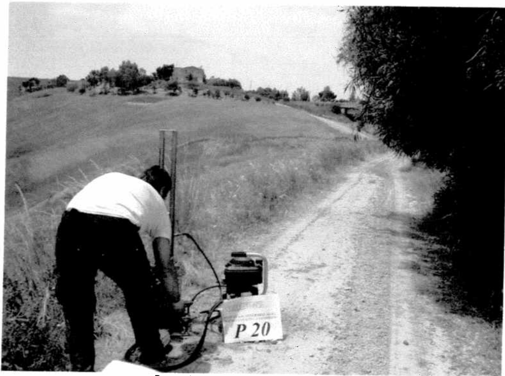
Postazione prova penetrometrica P20
