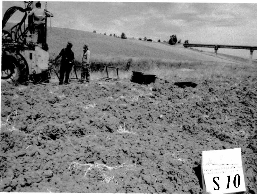
Postazione sondaggio meccanico S10
