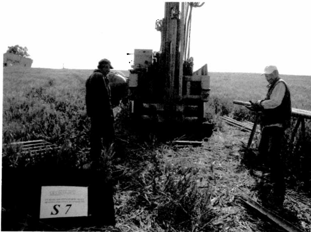
Postazione sondaggio meccanico S7
