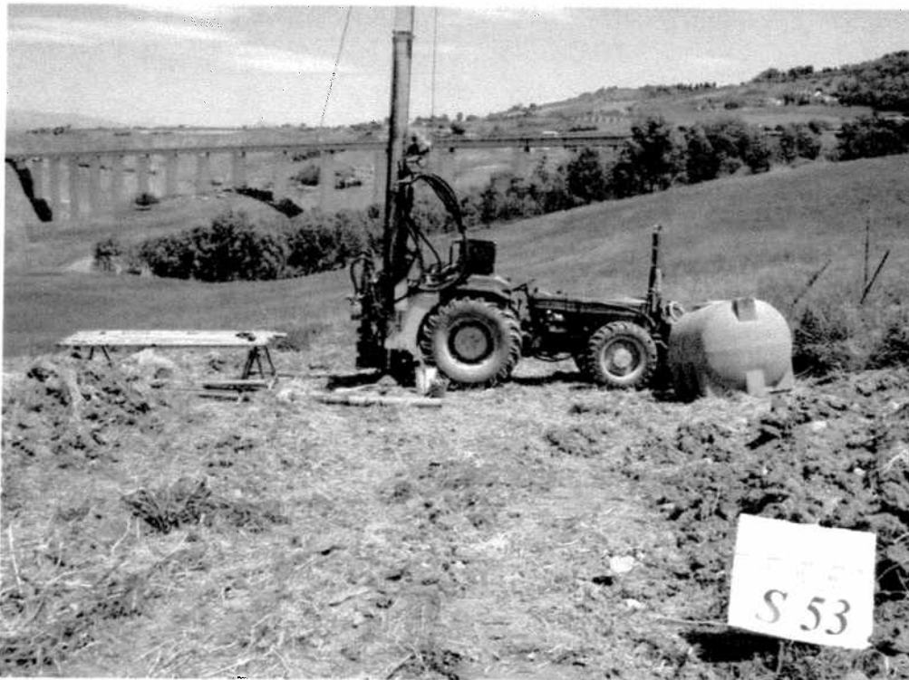
Postazione sondaggio meccanico S53
