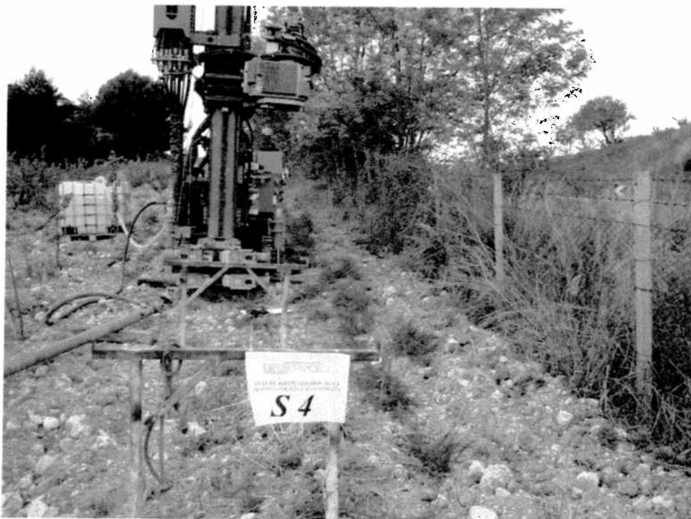
Postazione sondaggio meccanico S4
