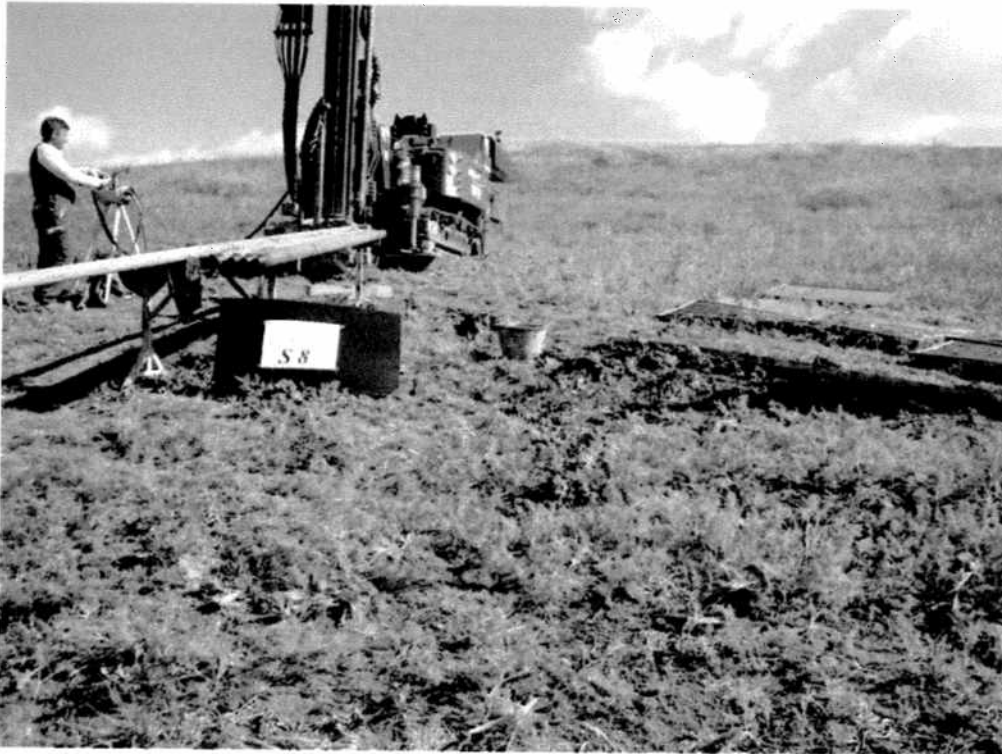
Postazione sondaggio meccanico S8
