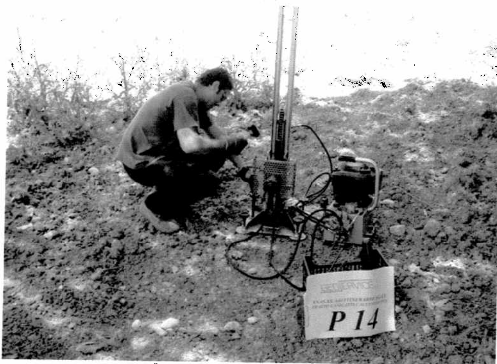
Postazione prova penetrometrica P14
