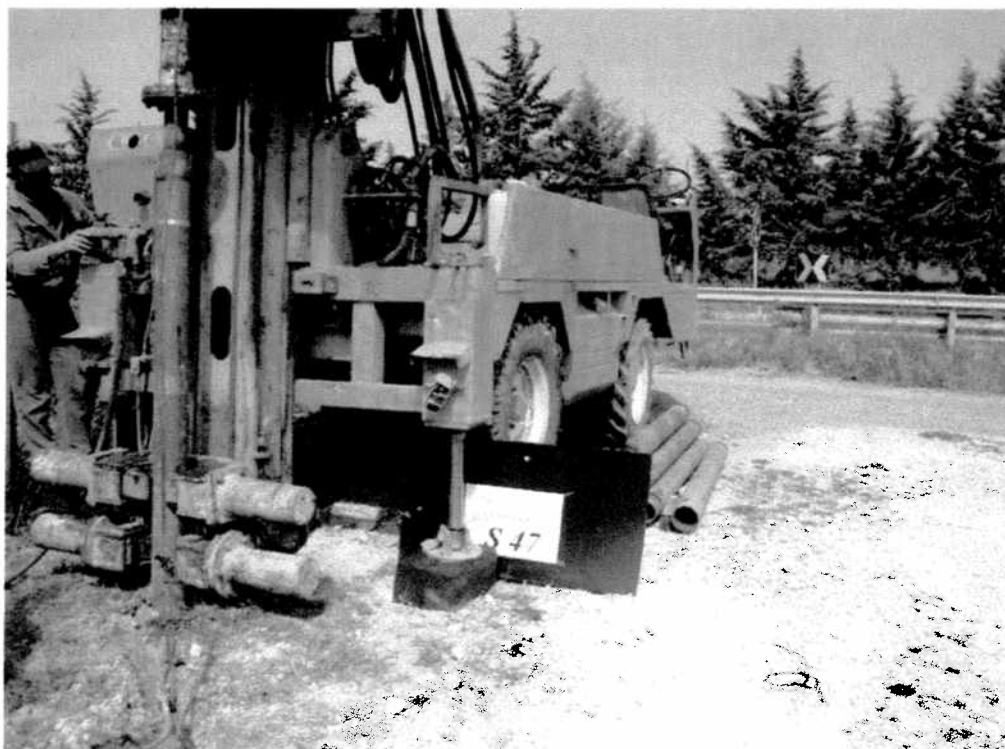
Postazione sondaggio meccanico S47
