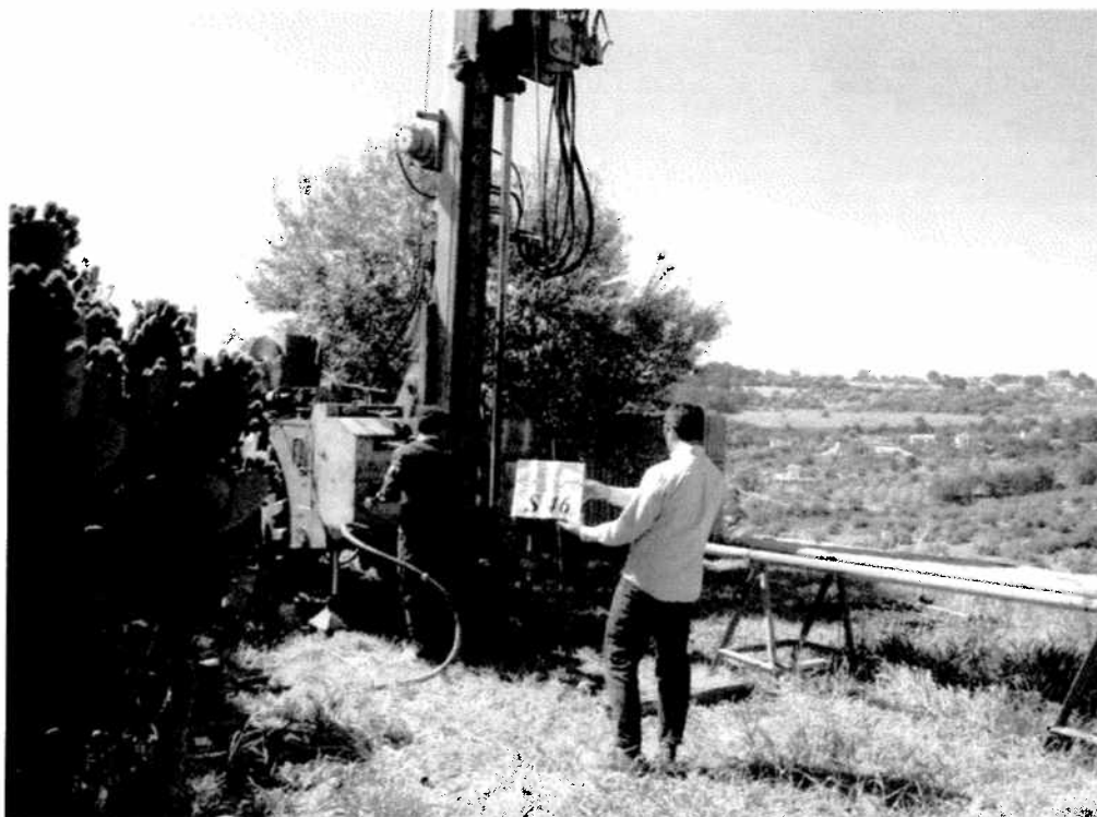
Postazione sondaggio meccanico S46
