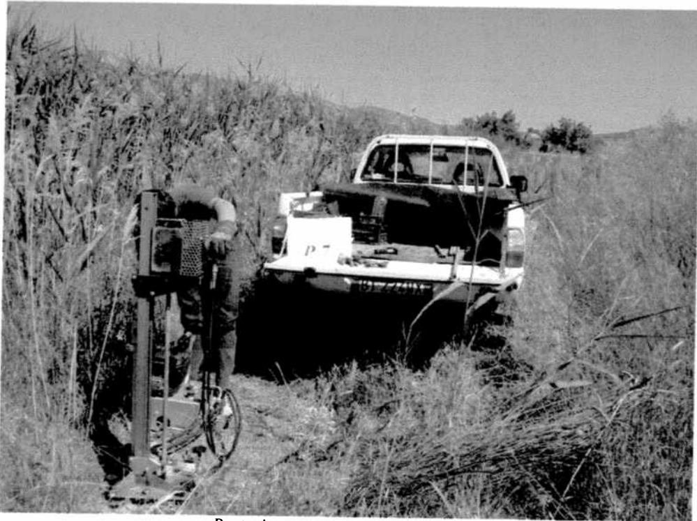
Postazione prova penetrometrica P7
