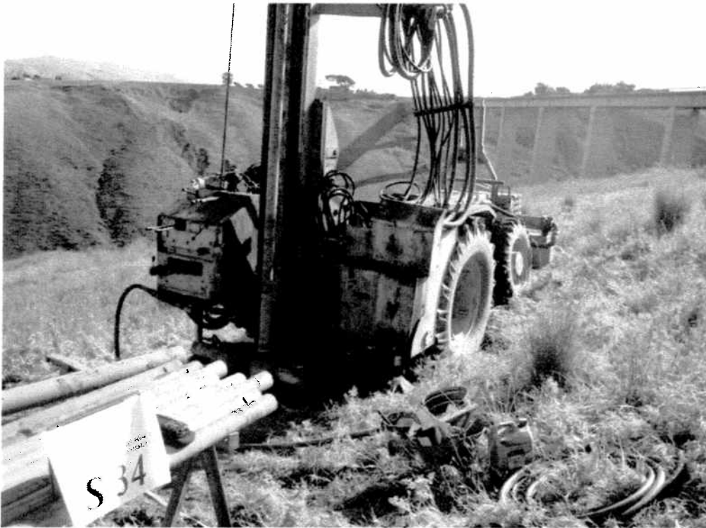
Postazione sondaggio meccanico S34
